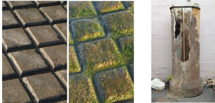
Figura 1.1.- Izquierda: Pavimento del Club de vela sin y con colonización de algas (elaboración propia). Derecha: Tubería de desagüe atacada por *Thiobacillus thiooxidans* ([www.wallisengineering.net](http://www.wallisengineering.net), 2012).
