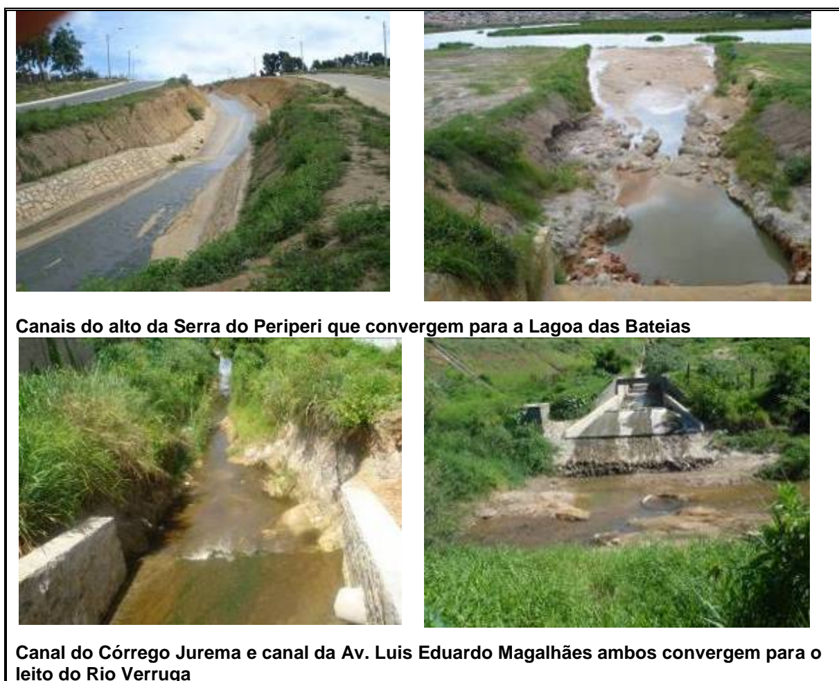
Figura 23- Macrodrenagem urbana de Vitória da Conquista-BA com canalização aberta revestida em pedra, convergindo para o Rio Verruga. Fotos do autor -2009
