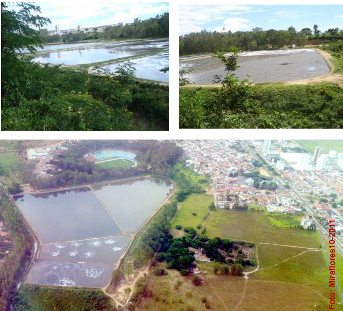
Figura 26- Fotos da estação de tratamento da embasa margem esquerda do Rio Verruga; ao fundo barreira com eucaliptos contra o odor dos efluentes.
