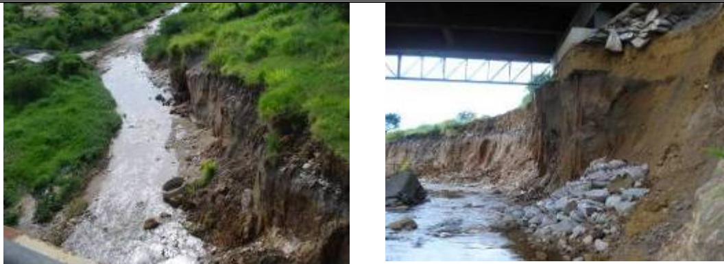
Solapamento da margem direita do Rio Verruga – Visão sobre e sob a Ponte da Av. Luís E. Magalhães - área urbana de Vitória da Conquista-BA :
