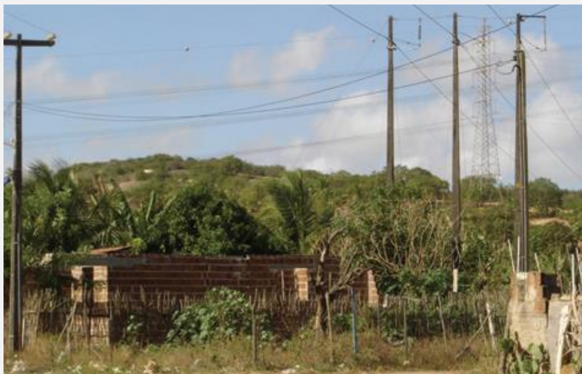
Figuras 8.23 y 8.24. Favelas en fajas de dominio - Redes de Alta tensión RA Oeste
