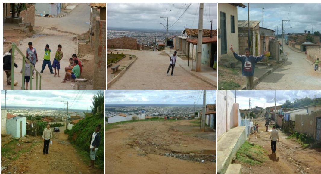
Figura 149 – Infraestrutura do Bairro NSA – 2010/2012 – Parte alta do bairro
