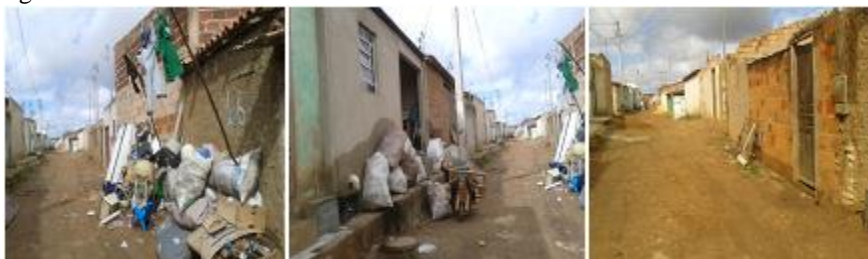
Figura 118 - Rua B: construída em área de invasão
