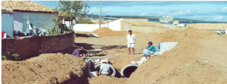
Figura 69 – Drenagem de águas no Bairro NSA
