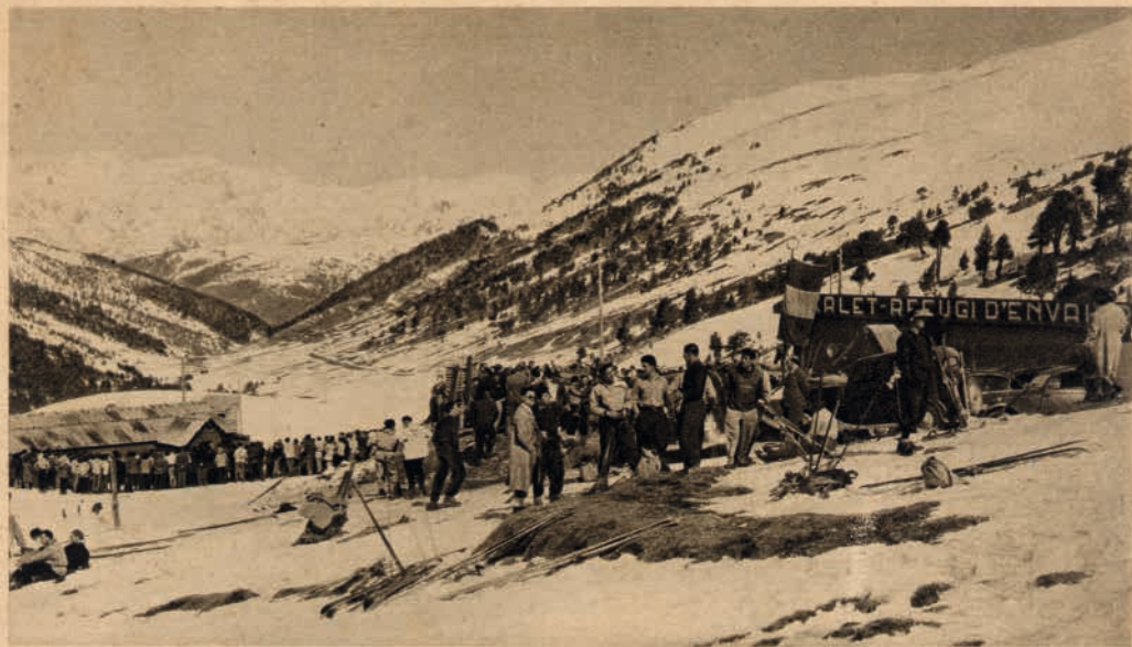
137. VALLS D'ANDORRA. — Envalira. Refugi. Alt. 2.100 mts. VALLÉES D'ANDORRE. — Envalira. Refuge. Alt. 2.100 mts.
