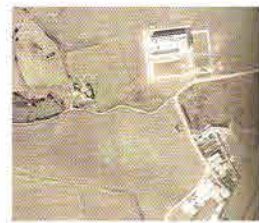
ESCOLA DE ENGENHARIA, U.CATÓLICA
