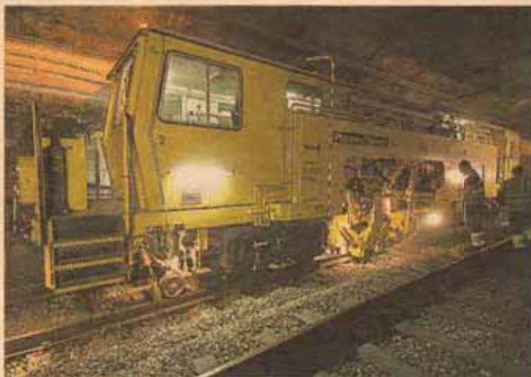
Trabajos de mantenimiento nocturnos en las vías del metro
