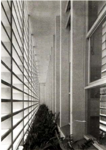
3.25 - Espacio entre los cobogós y las ventanas en el edificio de la Cia Jardins Cafes Finos, Rino Levi, Sao Paulo, 1942 (KON et al, 2001)
