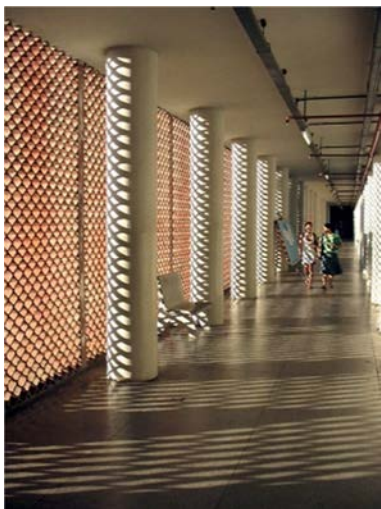
3.29 - Edificio del CFCH, en Recife (PE), 1955, del Filippo Mellia, cobogós cerámicos en su color natural (FREIRE, 2010).
