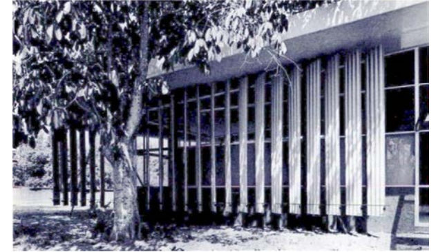
3.15 - Casa Arthur Coimbra, MMM Roberto, Rio de Janeiro, 1952, brises com telhas onduladas. (OLGYAY & OLGAY, 1976).
