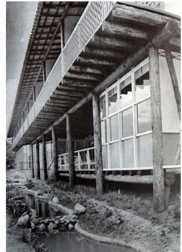
2.7 - El parque hotel, Lucio Costa, 1944/45: la estructura de palos rollizos en una obra moderna. [COSTA, 1995]
