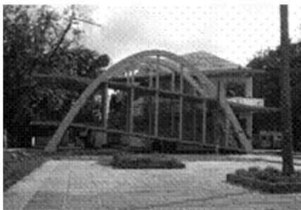
3.8 - Escuela Rural Alberto Torres, arquitecto Luiz Nunes. Recife (PE), 1935. (SMITH e FREITAS, 2008)
