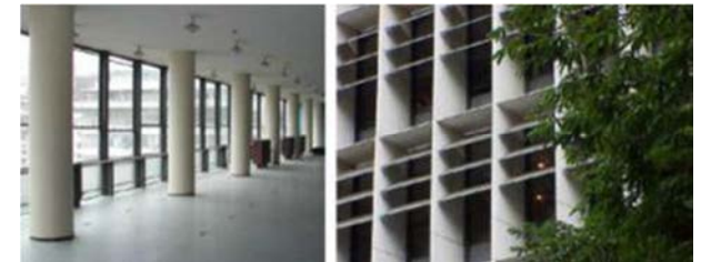
3.16 - A la izquierda, interior del la planta tipo. A la derecha, los brises de la fachada norte. (SEGRE, 2009).
