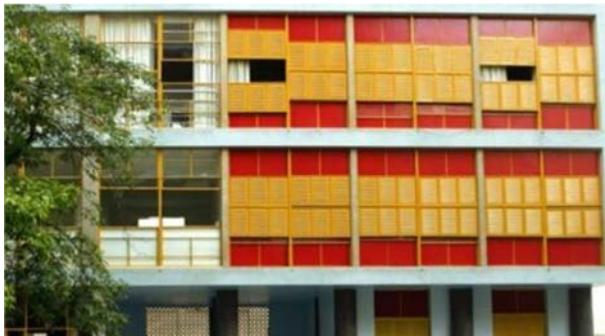
3.33 - Edificio Louveira arquitecto Vilanova Artigas en São Paulo, 1946: Ventanas en doble piel con apertura total. http://caseteimoveis.uol.com.br
