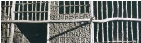
1.11. - Estructura, trama y relleno de la tapia de mano. (COLIN, 2010)
