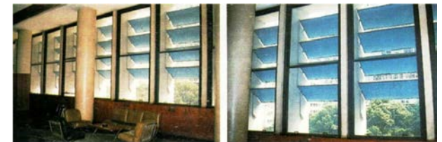
3.17- Los brises del edificio del Ministerio de la Educación y Salud. (COSTA, 1996)
