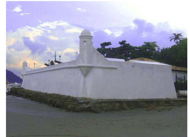
1.2. - Fuerte de Sao João de Bertioga, construido en mampostería de piedra de finales del siglo XVII a partir de una empalizada construida en el siglo XVI (fuente: WikimediaCommons).
