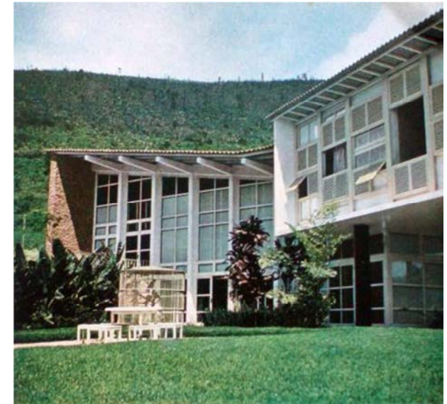
3.35 – Ventanas de doble capa y apertura plena. Casa George Hime, Henrique Mindlin, Petropolis, RJ, 1949. (GOODWIN, 1943)
