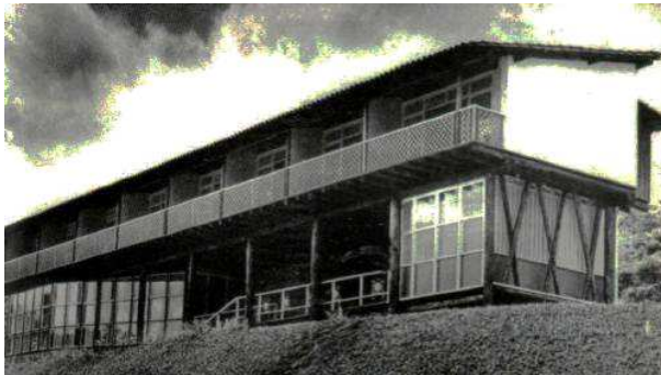
3.37 – Hotel en Nova Friburgo (RJ), 1944, Lucio Costa, la arquitectura moderna con materiales tradicionales. (COSTA, 1996)
