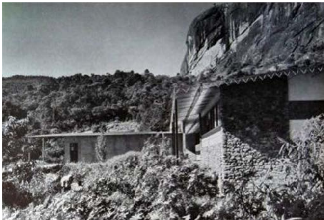
3.48- Cubierta de aluminio y paredes en piedra, Sergio Bernardes, Petropolis (RJ), 1951. (GILDEON, 1943)
