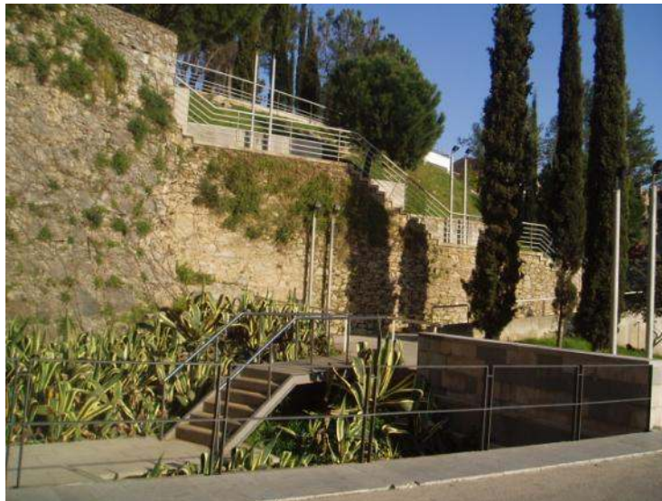
Fig. 74. Fachada sur de la muralla hacia los Jardines de las Pedreras, y escalinatas de acceso hacia el recorrido de la muralla.
