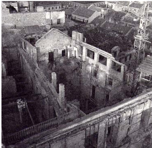
Fig. 15 (izq.). La destrucción al interior de los edificios fue total, sólo quedaron las fachadas de piedra en pie.
