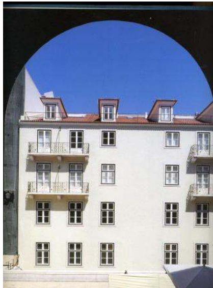
Figs. 58 – 68. Fotografías de varios detalles de las obras de reconstrucción para el Chiado terminadas hacia 1996.
