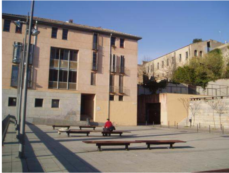
Fig. 72. Vista de la terraza de acceso al edificio de Beatas.
