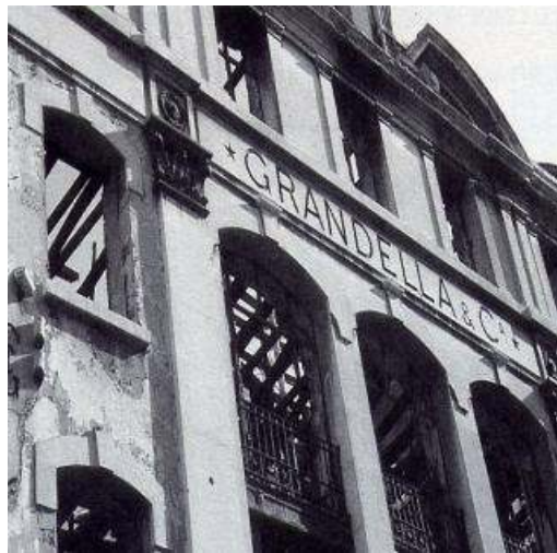
Figs. 97-99. Fotografías del Chiado antes del incendio y después de la reconstrucción, estado actual. Figs. 100-102.
