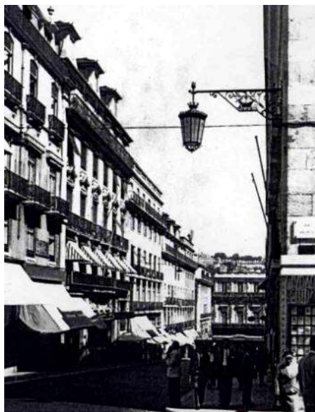
Vistas sobre los Grandes Armazens do Chiado Fig.3 (izq.). Vista desde la Rua Garret, con el edificio al fondo, en 1940.
