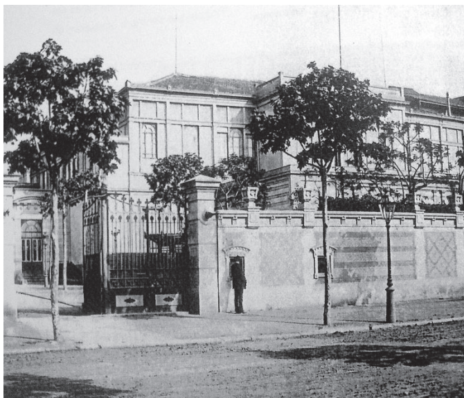
Entrada al recinto del Teatre Líric desde calle Mallorca.
