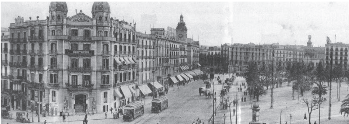
Plaça de Catalunya, lado sur y oeste, 1920.
