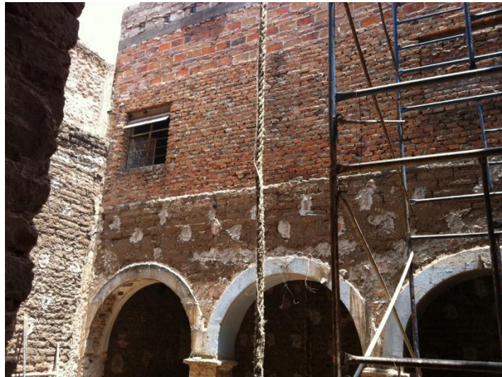
4.22 Cabe destacar que se añadió un piso completo sobre el muro de adobe, como se puede ver en la foto, hecho en varias fases. Hay ladrillo de dos tamaños y bloc de jalcreto.
