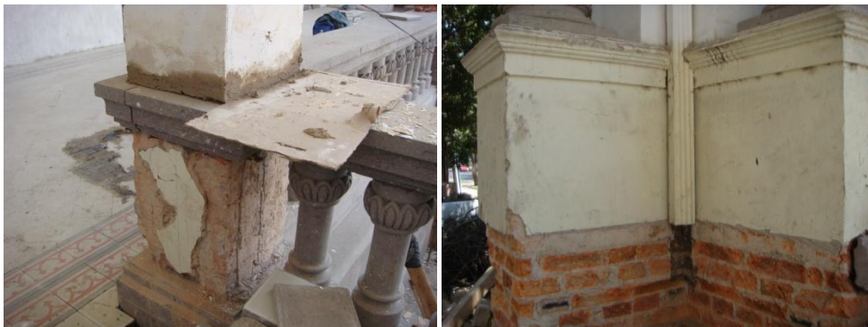
4.50 Detalle de varios pedestales de ladrillo en Vallarta 1252
