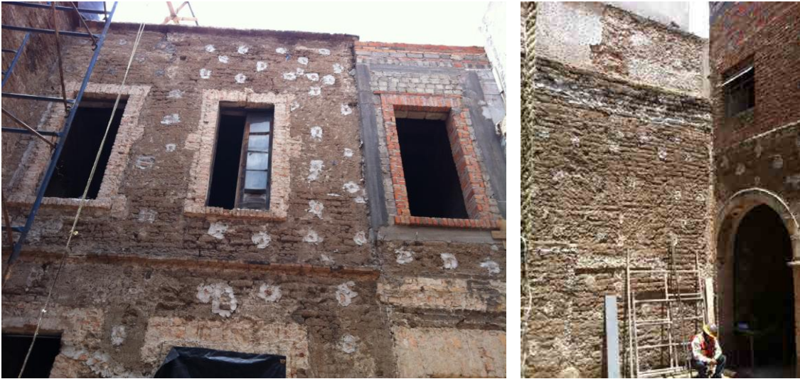
4.21 Muros sin enjarre del patio interno. En ambas fotos se pueden distinguir sendas ampliaciones hechas con ladrillo.
