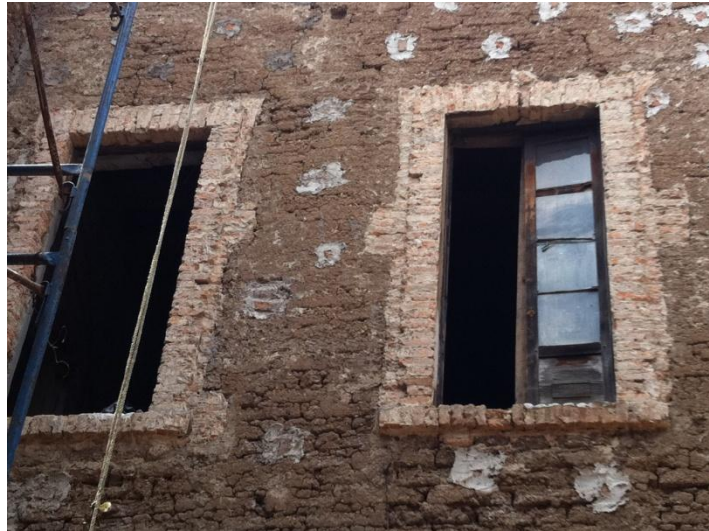
4.65 Detalle de las ventanas construidas en ladrillo. Observar las piezas que sobresalen en la mitad de la jamba que sirven para amarrarla con el muro de adobe.
