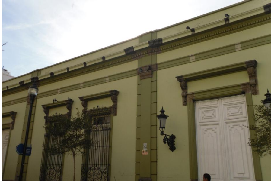
4.68 Detalle de las cornisas en la casa ubicada en Liceo 177 esquina con San Felipe
