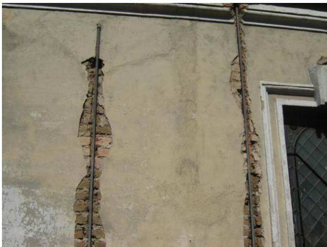
4.16 En la siguiente ranura se puede ver la continuidad de las hiladas de ladrillo
