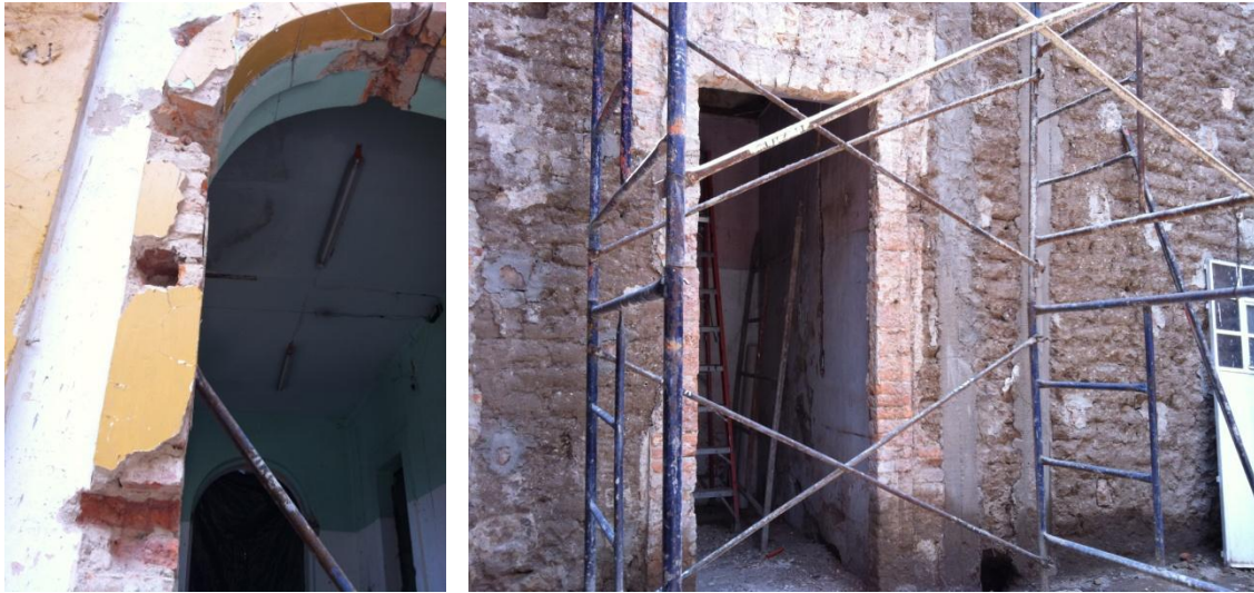
4.63 Detalle de dos puertas de la casa. En la izquierda, un arco de medio punto. En la derecha, un arco plano. En ambos casos sobre jambas de ladrillo.
