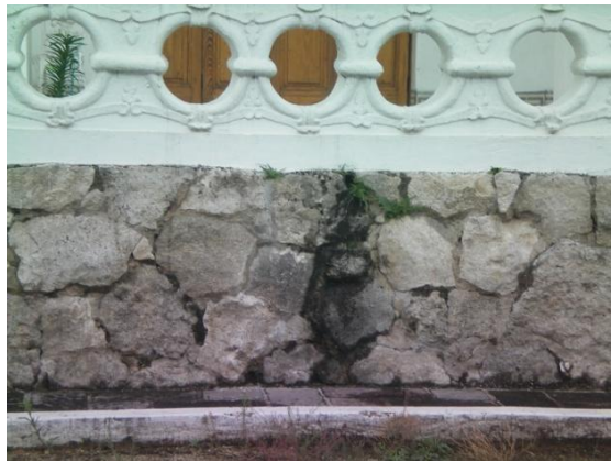
4.7 Muro de nivelación-podium de la casa de Francia 1379. Detalle de la piedra aparente en la foto inferior
