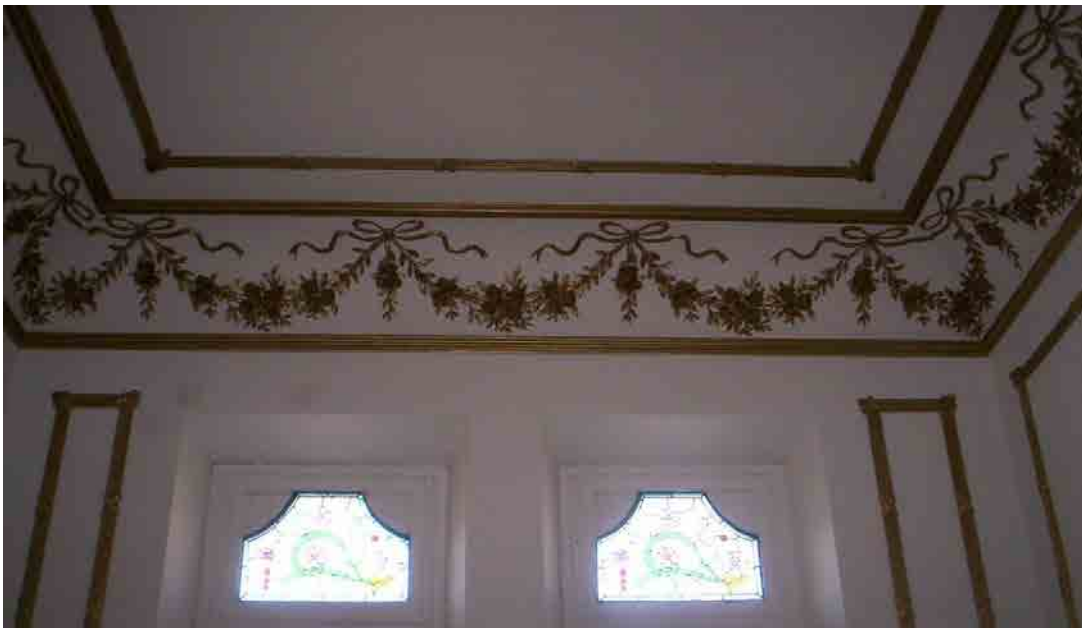
4.45 Detalle del techo de la casa de Libertad 1872. Nótese las molduras decorativas.
