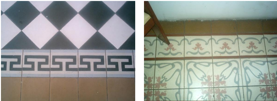
4.86 Dos tipos de pavimentos en la casa de General San Martín 172
