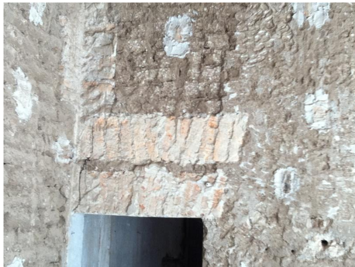
4.64 Detalle de doble dintel. En este caso se apoya sobre el muro de adobe.
