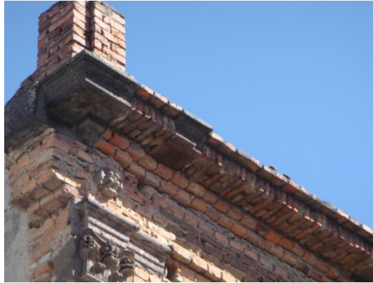
4.70 Observar la pieza de cantera en la esquina de la cornisa. Mezquitán 842
