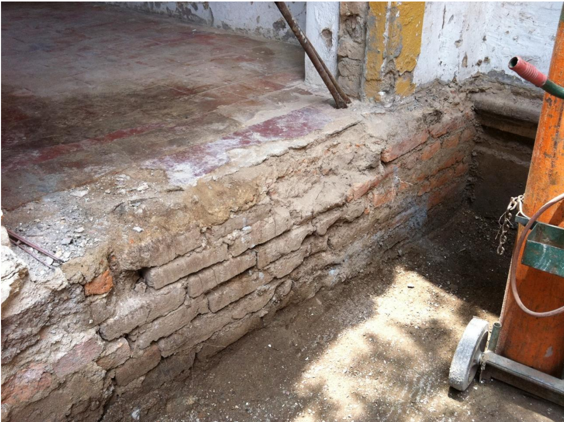
4.11 Muro de nivelación de adobe en la casa de Hidalgo 1291. Obsérvese como a la derecha se puede ver el refuerzo de ladrillo.
