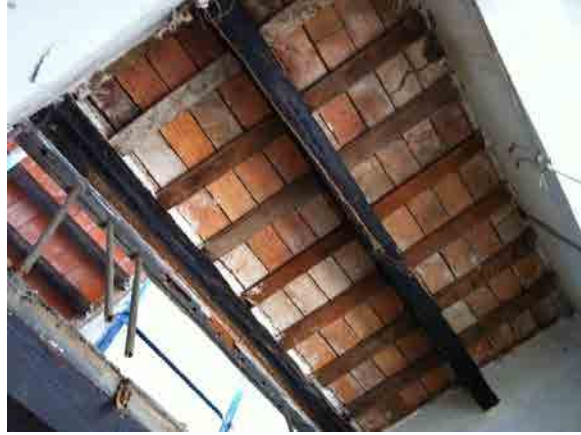
4.35 Un detalle del techo de la planta baja antes de ser intervenida.
