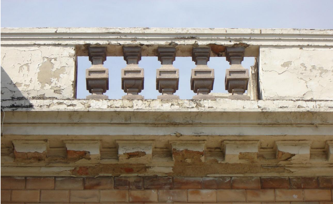
4.82 Detalle de la balaustrada de cantera de la casa de Vallarta 1122.
