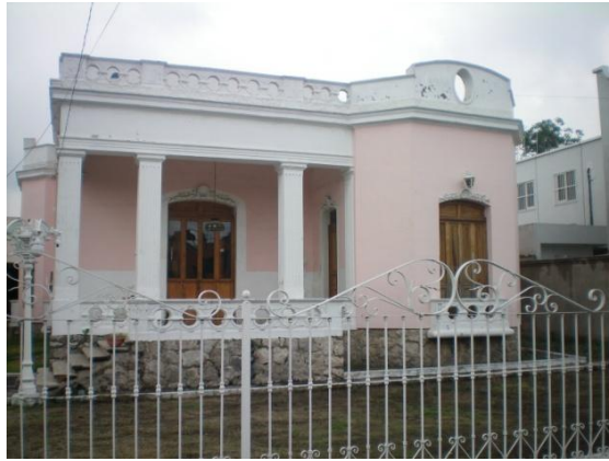
4.7 Muro de nivelación-podium de la casa de Francia 1379. Detalle de la piedra aparente en la foto inferior
