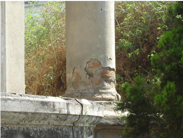
4.52 Columna hecha de ladrillo. Vallarta 1581
