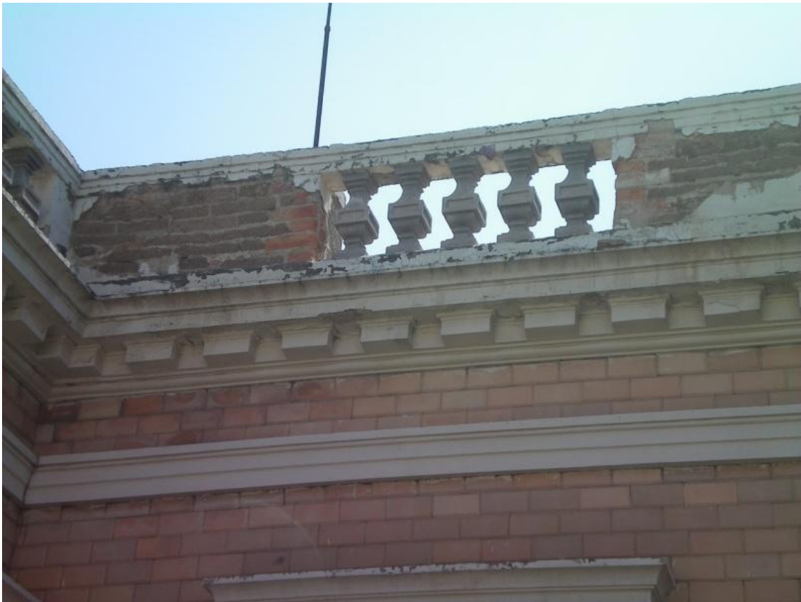
4.18 Se puede ver la combinación de adobe y ladrillo. Este último sirve para reforzar las zonas de balastrada. Vallarta 1122
