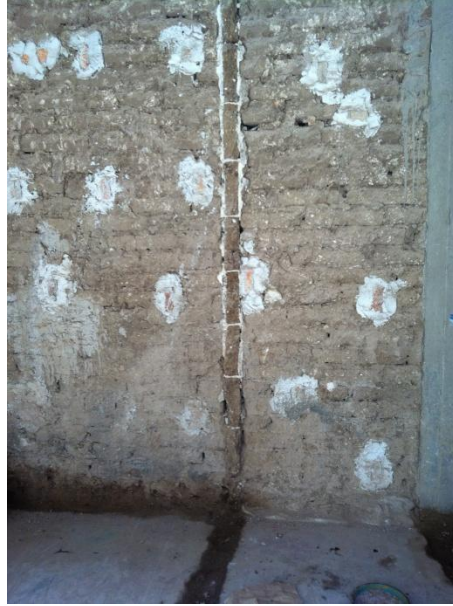
4.23 El muro divisorio fue derruido en algún momento pero, al desaparecer el enjarre, es perfectamente perceptible.
