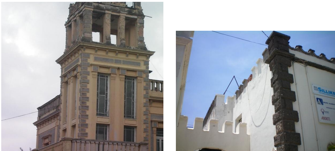
4.29 Dos ejemplos con esquinas de sillares de cantera. Francia 1359, izquierda, Libertad 1903.
