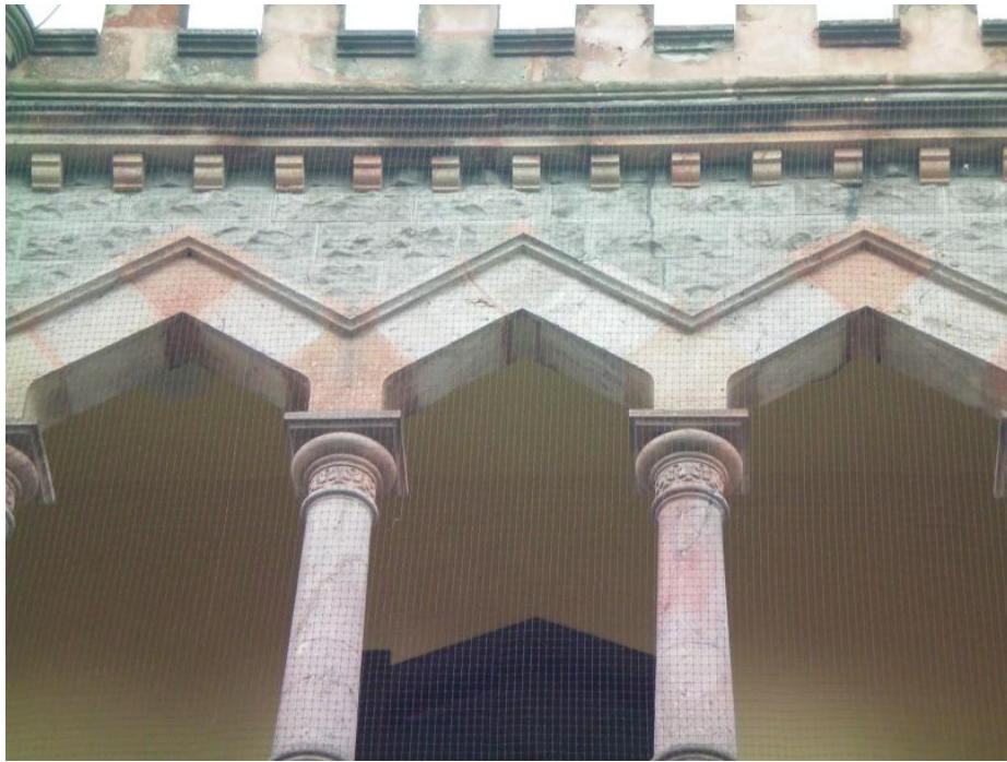
4.60 Arco rectilíneo, en mitra, en la terraza de la planta alta de la casa de España 1355.
