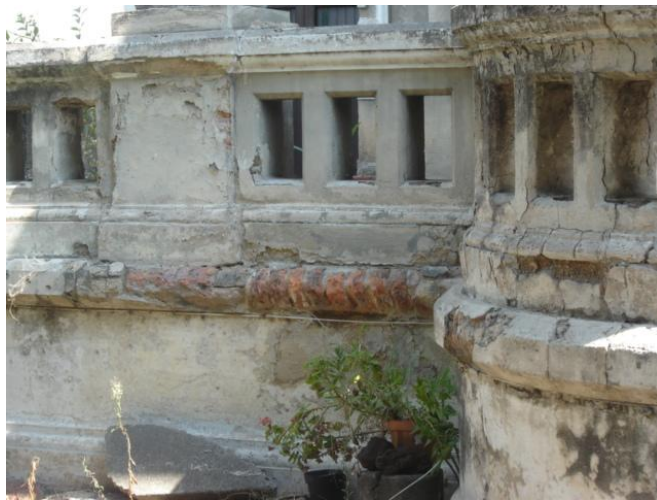
4.73 Detalle de la parte inferior del barandal. Vallarta 1581
