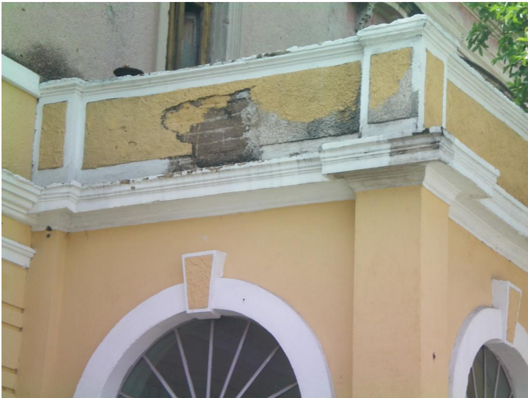
4.20 Fotografía previa a los trabajos del 2012. Se puede ver el adobe del pretil.
