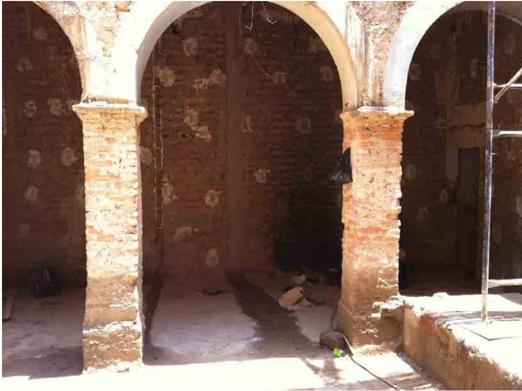
4.53 Pilares de ladrillo en Hidalgo 1291.
