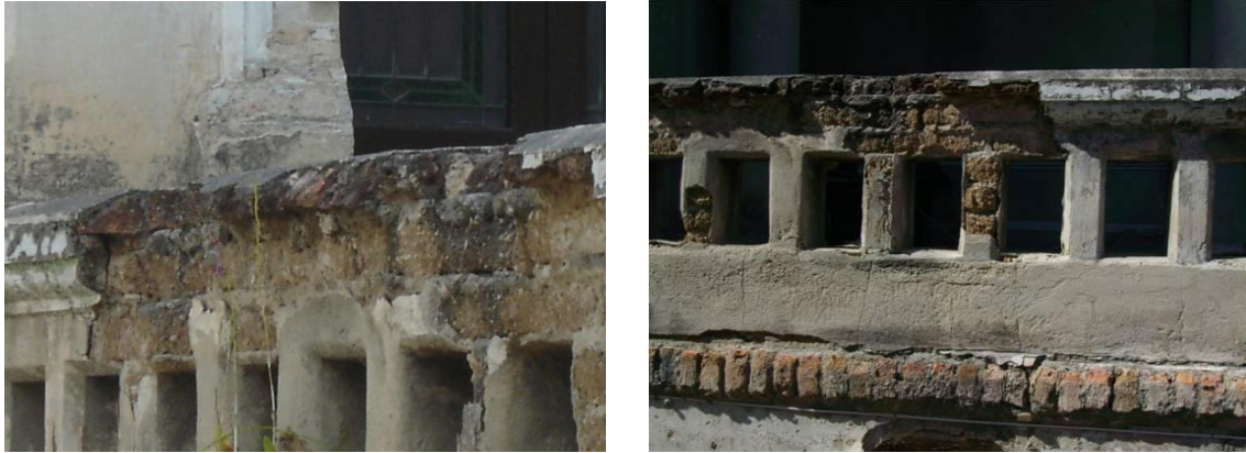
4.72 Detalle de los ladrillos cortados con la forma del remate del barandal. Vallarta 1581
