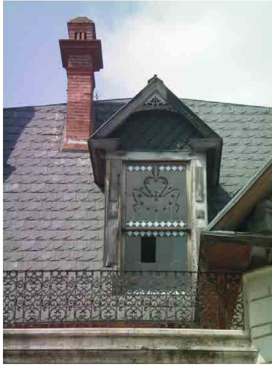
4.48 Láminas de zinc en la cubierta de la casa de La Paz 1831.
