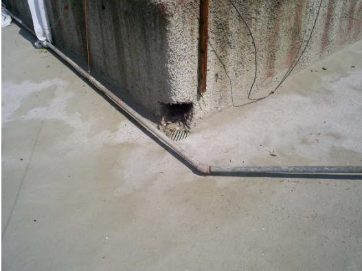
4.96 Detalle de sumideros en las bases de los pretilos en Libertad 1981 y Vallarta 1252
