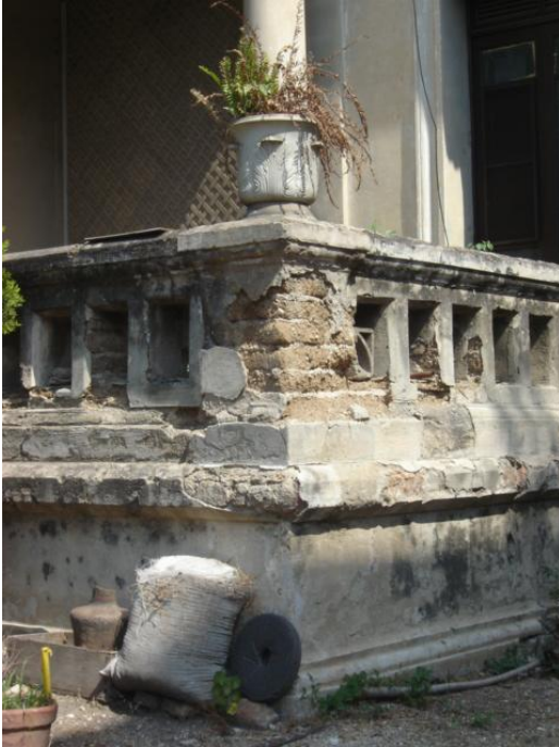
4.51 Pedestal del barandal. Se puede ver que sólo soporta el peso de un florón decorativo. Vallarta 1581
