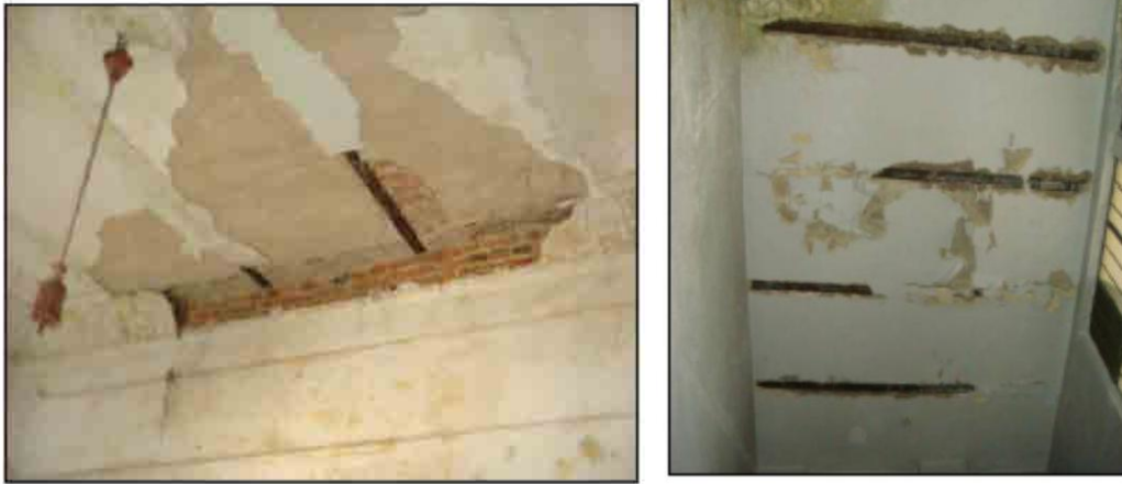
4.44 Vallarta 1252. En ambas fotos se pueden distinguir las vigas metálicas y la bóveda de cuña 79
