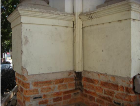
4.100 Bajante metálico en el pórtico de entrada de Vallarta 1252.
