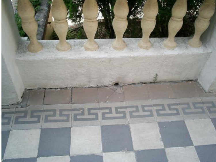
4.98 Hueco de desagüe en Libertad 1966
