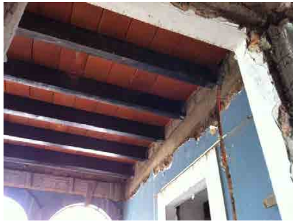
4.36 Detalle del techo en su proceso de restauración.
