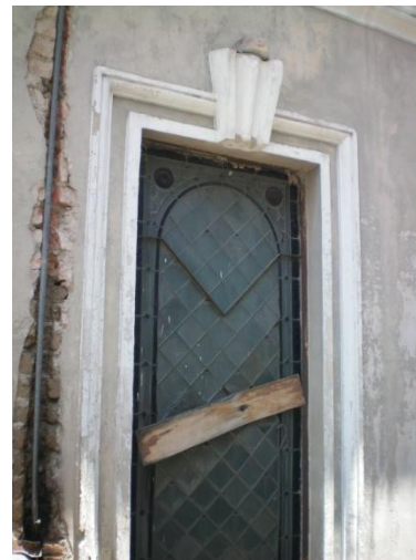
4.16 En la siguiente ranura se puede ver la continuidad de las hiladas de ladrillo
