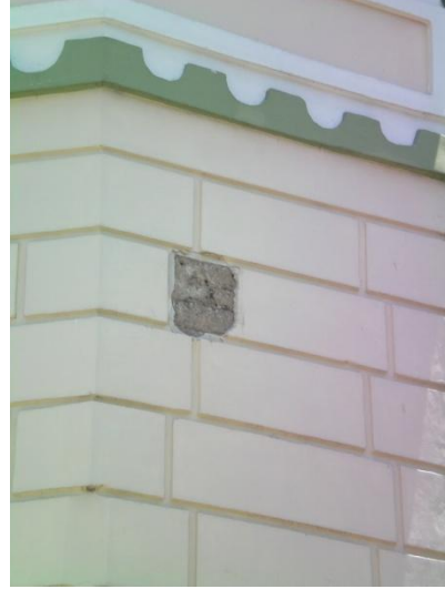
4.19 Izquierda, detalle en el chaflán de la pequeña parte sin enjarre. Derecha, se alcanza a ver las piezas de adobe.
