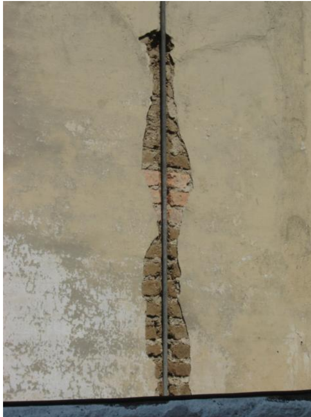
4.15 Se puede ver las hiladas de ladrillo a media altura.
