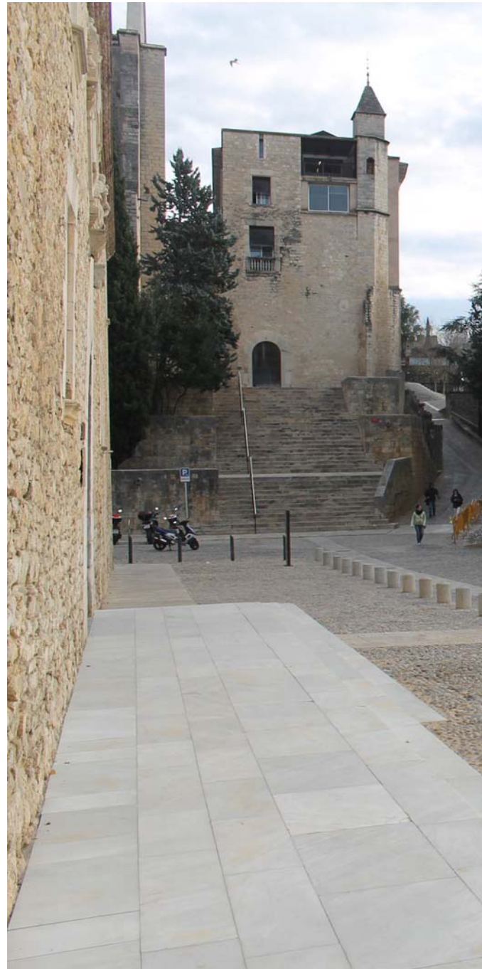
6_Rehabilitació de l'Antic convent de Sant Domènec . Arqtes Bosch-Tarrus-Vives.
