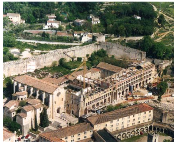
2_Barri vell. Imatge de Sant Domènec en obres, per acollir la Facultat de Lletres. 1991 Foto: Capdeferro. Font: llibre Girona 20 anys del Pla Especial del Barri Vell
