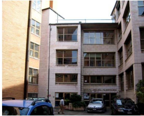
3_Bologna: Istituto de Geologia i Paleontologia, edifici universitari ubicat a dins del teixit històric.
