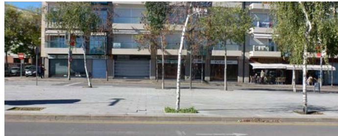
9_Entorn Montilivi. Av. Lluís Pericot. 2012 Terrassa al carrer
