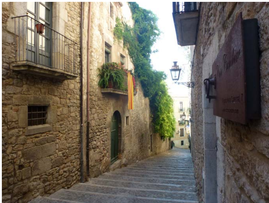
4_Pujada de la Catedral. Girona 2012 Carrer amb "pell noval": nova urbanització i façanes rehabilitades
