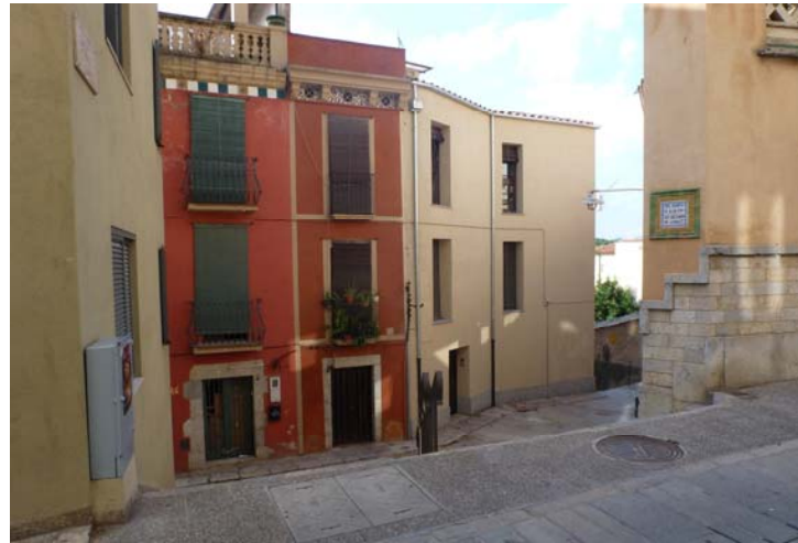
Edificis rehabilitats amb un grau de salubritat i prestacions tècniques pròpies del segle XX 7_Carrer de la Claveria, part alta del Barri Vell. 2012 8_Carrer del Portal Nou. 2012
