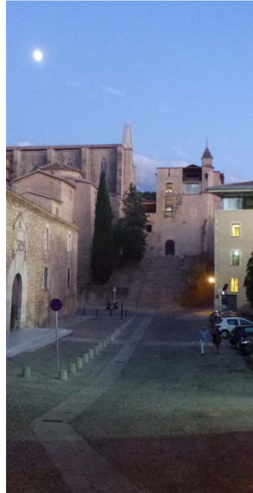
6_ Plaça de Sant Domènec 2012 Urbanització de qualitat amb serveis modernament actualitzats.
