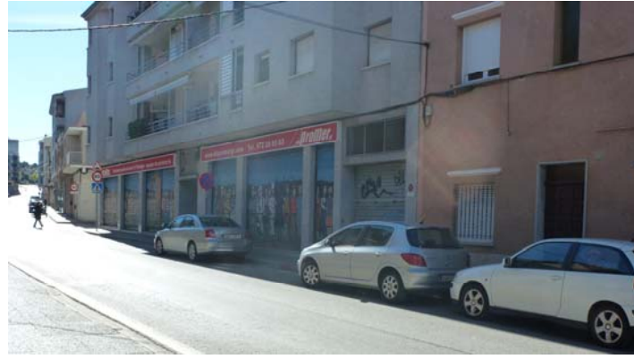
4_Carrer de la Rutlla. 2012., Colmatació de buits amb edificis de veïns amb locals comercials a planta baixa
