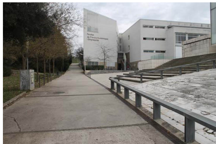
28_vial que dona a l'entrada secundària a C. Jurídiques i a l'entrada a C. Econòmiques, anant cap a l'est
