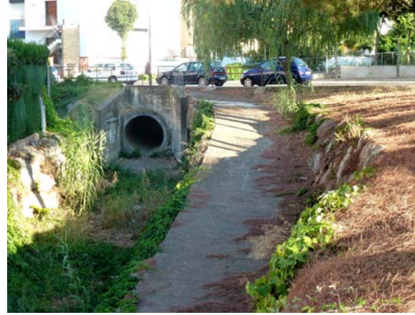
7_entorn avinguda de Montilivi. Espais pendents d'una urbanització més amable en alguns espais verds
