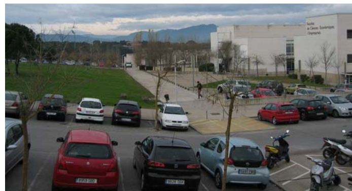
36_extrem llevant, enllaç de terrasses d'aparcament i l'entrada principal de Facultat C.Economiques
