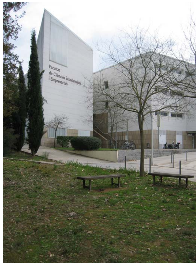
24_ Conjunt de dos bancs de fusta sense respalller, col·locats en perpendicular, amb flexibilitat d'ús, situats fora de la zona de pas dels vials interns
