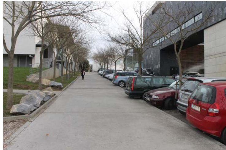
27_tram inicial vial, tocant al carrer perimetral en la part de ponent, anant cap a l'est
