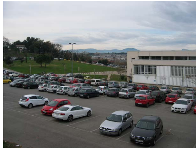
54_tram que dona a la façana de l'edifici de Ciències Econòmiques amb aparcament asfaltat
