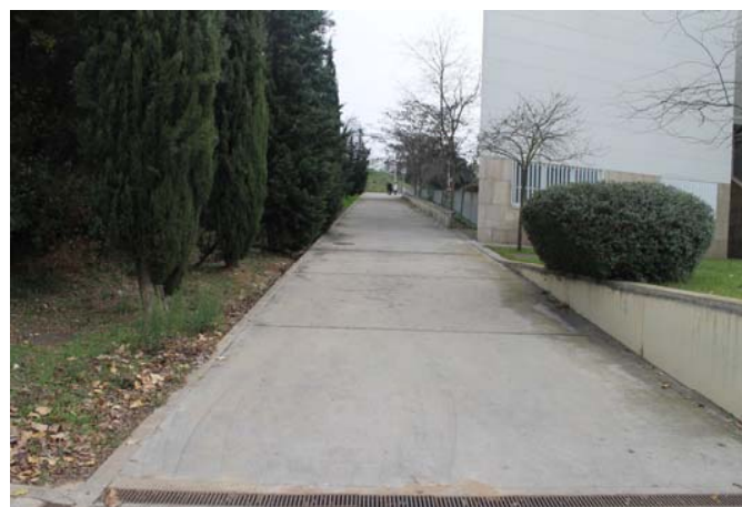
25_tram final vial E03, des de NS3 cap a l'est, costat a façana Facultat econòmiques.
