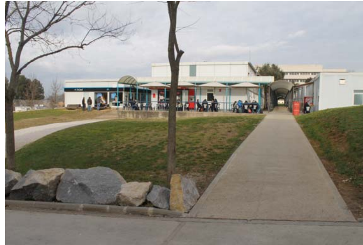
32_visió de l'accés a l'edifici de mòduls prefabricats
