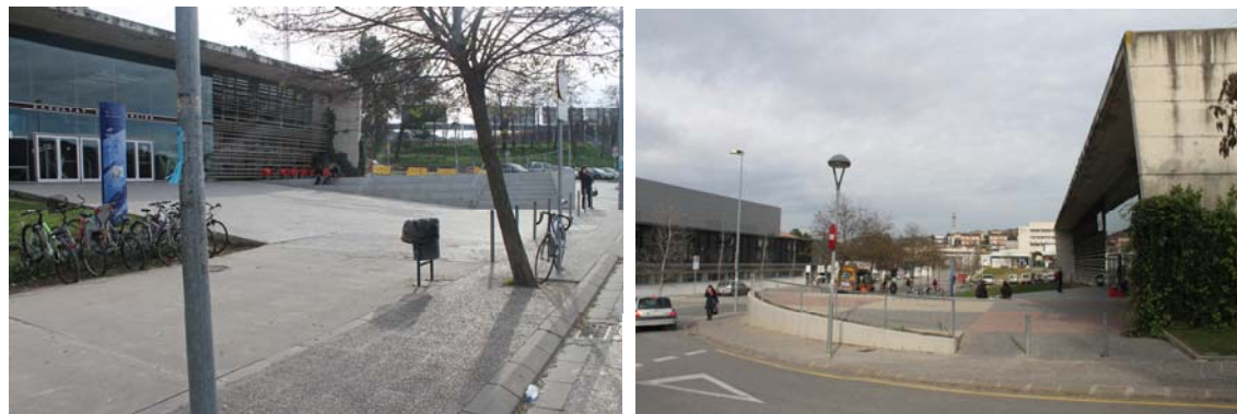
68_Espai de connexió edifici carrer Maria Aurèlia Capmany. 69_Connexió des de carrer Perimetral
