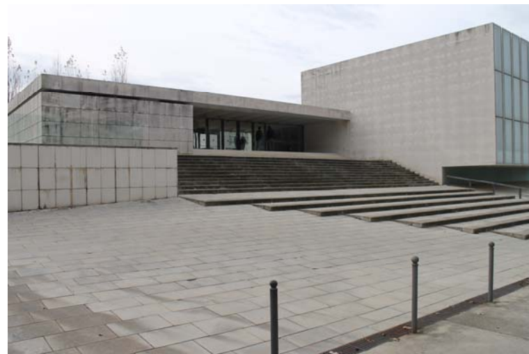
95_Accés nord Facultat Ciències Jurídiques Continuïtat material de pla horitzontal i pla vertical
