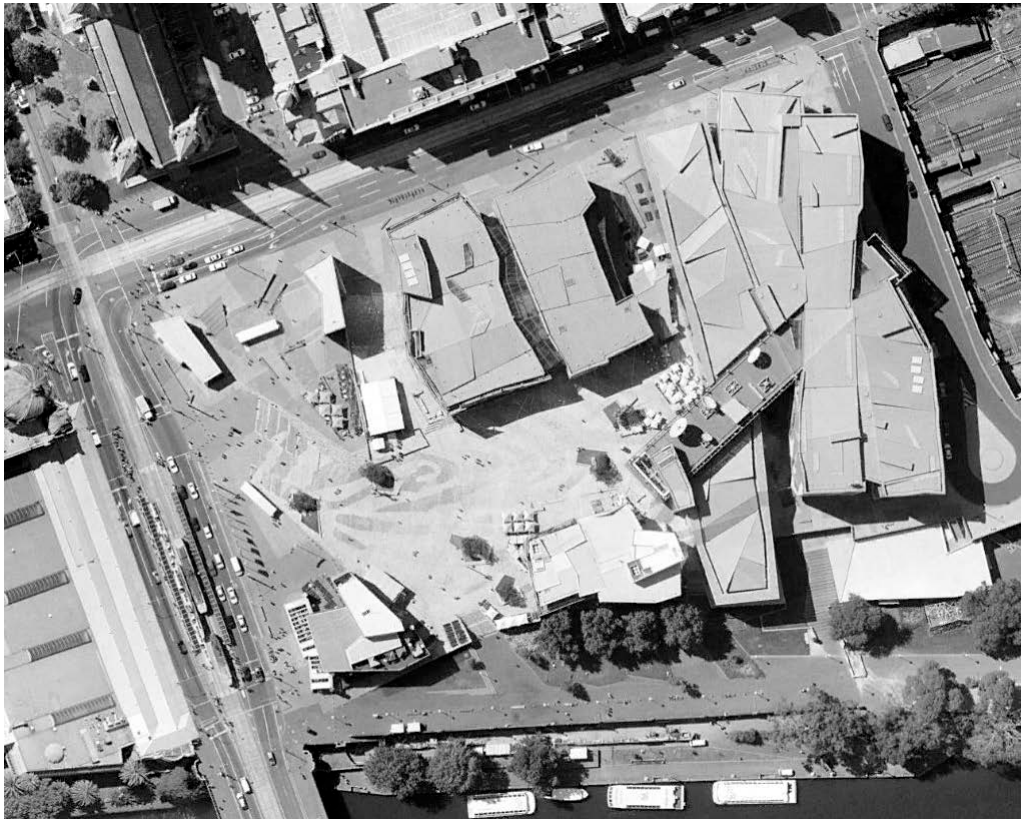
Imagen 1. Vista aérea de la plaza (Fuente: Google maps)
