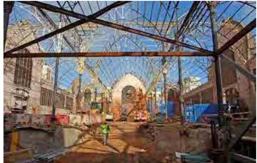
Fig. 648 Imagen de las obras en junio de 2012. Foto: Diari de Tarragona 04/06/2012
