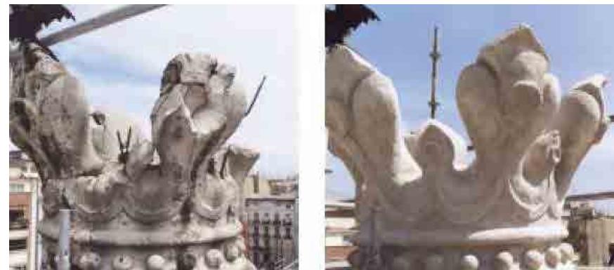
Fig. 425 Proceso de recuperación del escudo de Valencia en la fachada de la calle Jorge Juan. Foto: Tomada del libro Mercado de Colón, historia y rehabilitación, pág. 136
