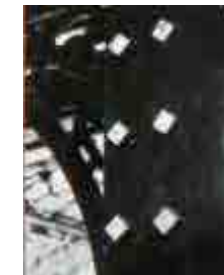
Fig. 198 Izq. Limpieza de albañales. Centro: perforaciones practicadas en los pilares para el retiro del hormigón que los obstruía. Der: Nuevos tornillos y arandelas de plomo sustituyeron a los originales en mal estado.
