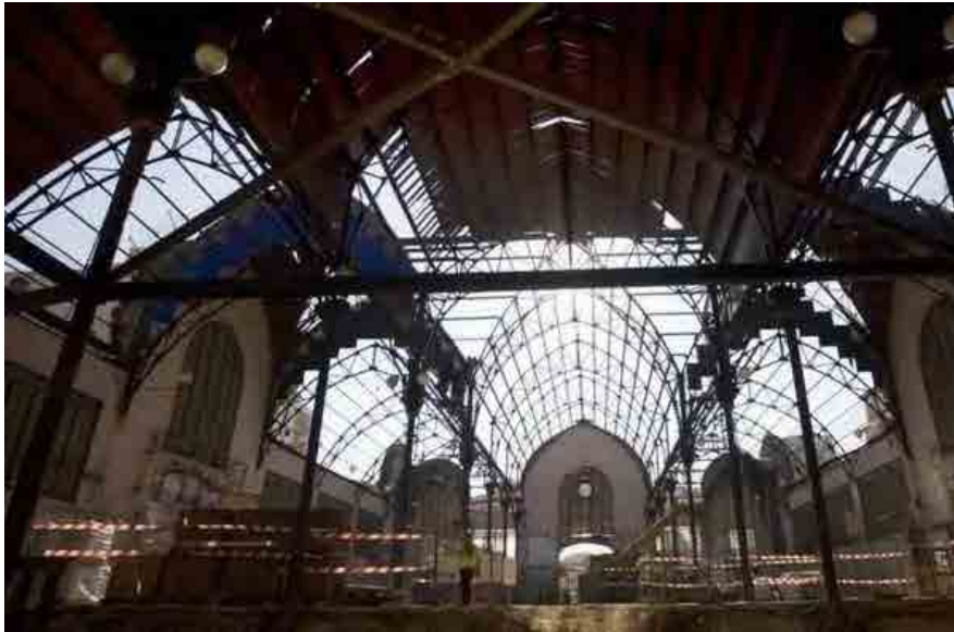
Fig. 647 El mercado en obras, retirado el techo de uralita y madera. Foto: La Vanguardia 30/03/2012
