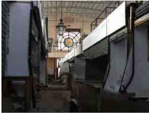
Fig. 763 Interior del mercado en desuso. Foto: El Punt Avui
