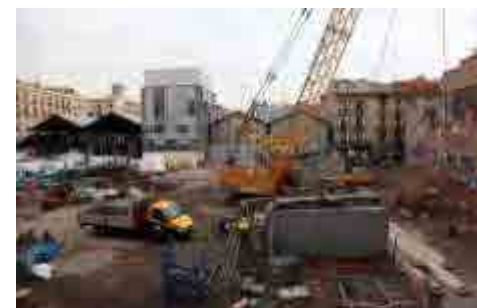
Fig. 121 El aparcamiento subterráneo en la Plaza la Garduña, obras. Estado actual.
