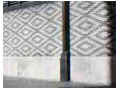
Fig. 200 Izq. La estructura del edificio fue limpiada mediante chorro de arena y protegida posteriormente con nímio. Der. Mediante chorro de arena se dejó al descubierto la obra de fábrica.
