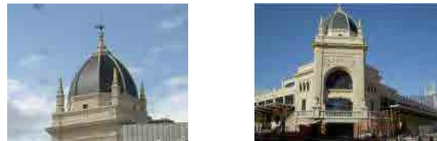
Fig. 447 Detalles de los trabajos en la cúpula y en la escalera.
