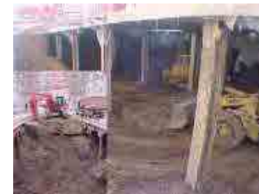
Fig. 408 Extracción de tierras bajo losa del suelo: extracción en rampa. Fuente: MCPC
