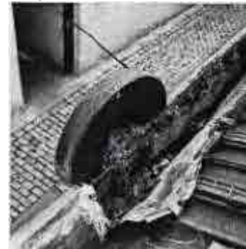
Fig. 505 Izq. detalle de un canalón mal conservado, derecha imagen que demuestra el óxido destruyendo los elementos de hierro, Fotos: Informe del ITEC.
