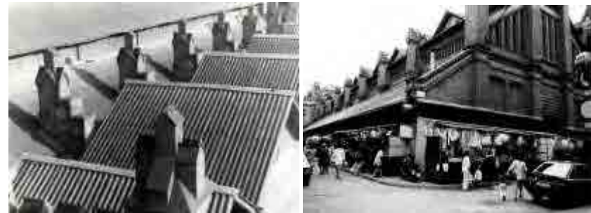
Cubierta y fachada en 1986. AHS
