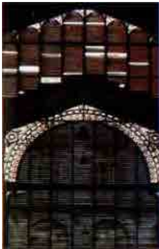
Fig. 196 Celosía de madera que fue colocada sobre la entrada con posterioridad a la construcción del edificio, con el objetivo de eliminar la luz directa. En las obras de restauración fue eliminada.
