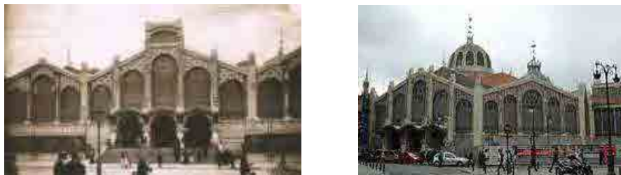
Fig. 21 Mercado Central de Valencia. Izq. el mercado en 1930, derecha el mercado en obras.
