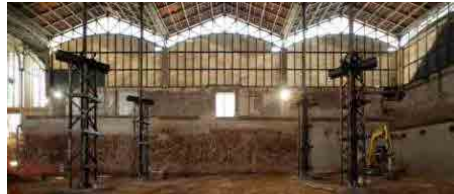
Fig. 705 Interior del mercado en obras donde puede apreciarse el apuntalamiento de la estructura original dado que se han excavado los sótanos. Foto: Adrià Goula, Mateo Arquitectes
