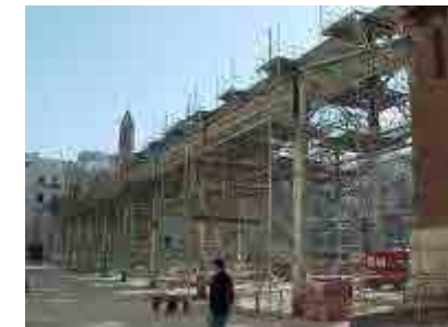
Fig. 420 Montaje de andamios para el reconocimiento y reparación de la estructura. Fuente: Informe AUMSA
