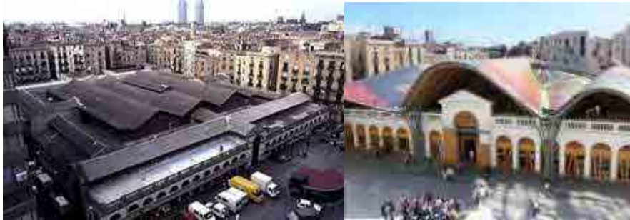
Fig. 10 Antes y después de la rehabilitación. Mercado de Santa Catalina.
