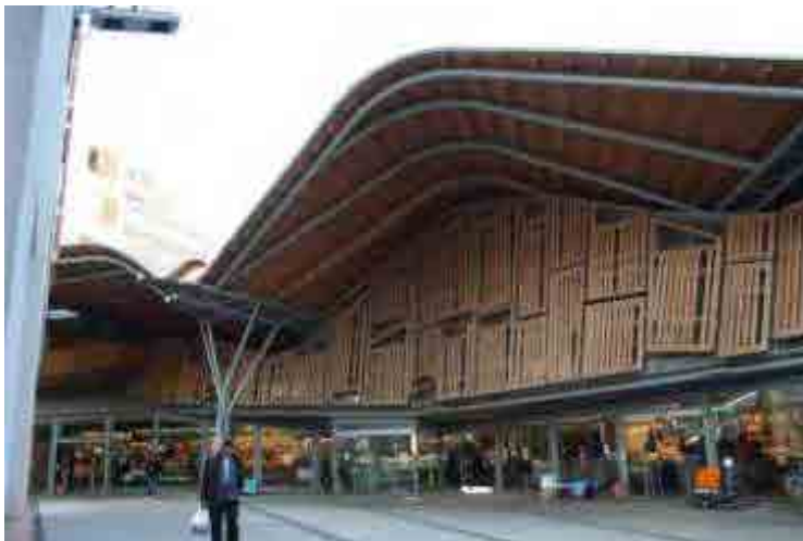
Fig. 164 Fachada interior frente a edificios de viviendas
