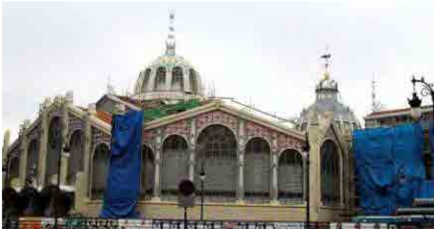
Fig. 354 Trabajos en fachadas y cúpula. Imágenes: Flickr tonogayora
