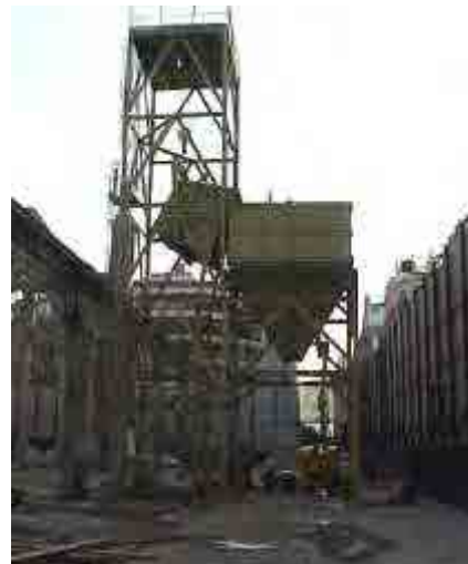
Fig. 409 Extracción de tierras bajo losa del suelo: Excavación bajo la nueva cimentación de la portada Jorge Juan y elevación de tierras y carga de camiones. Fuente: Informe AUMSA
