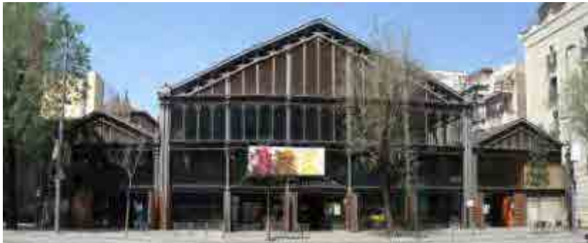
Fig. 516 Estado actual. Fachada calle Aragón. Foto: Autora
