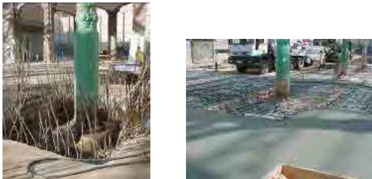
Fig. 405 Ejecución de la losa de suelo. Armaduras y hormigonado de losa sobre el suelo y preparación de apeo de pilar de fundición. Fuente: MCPC
