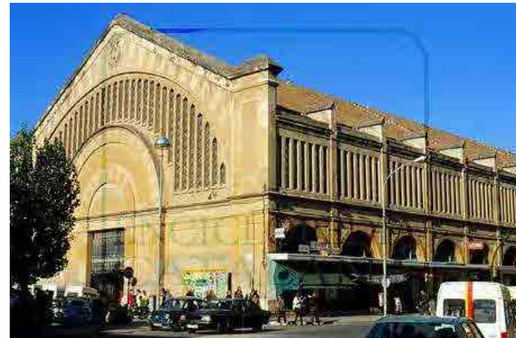
Fig. 811 Aspecto del edificio después de la reparación finalizada la guerra. Se eliminaron los detalles decorativos. Foto: Enciclopedia catalana.
