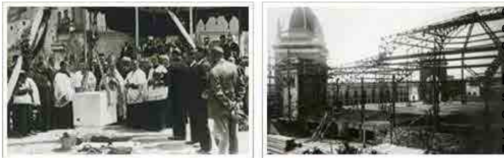
Fig. 434 Colocación de la primera piedra y mercado en obras. Fuente: página web del mercado de Sabadell
