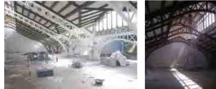
Fig. 351 Trabajos sobre plataforma, 2006. Foto: F. Hidalgo.
