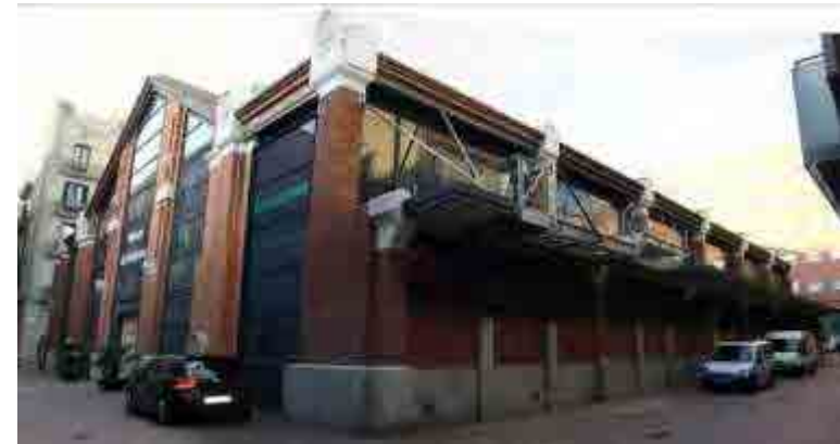
Fig. 719 El mercado rehabilitado. Foto: Autora
