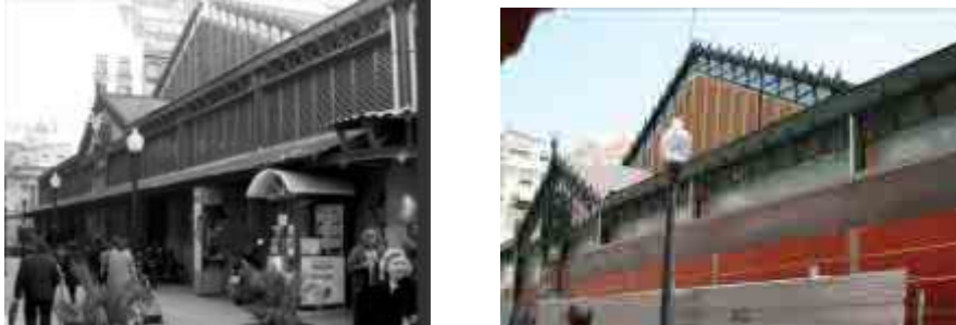
Fig. 13 Mercado de la Libertad, antes y después de la intervención.
