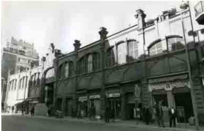
Fig. 743 Fachada calle Reina Elisenda. Fuente: COAC
