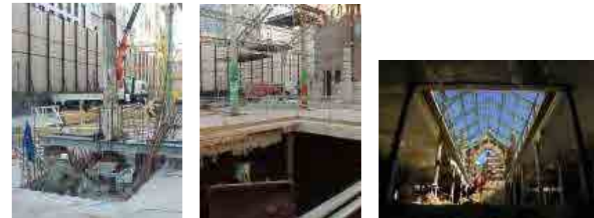
Fig. 407 Ejecución de apoyo definitivo. Izquierda: Extracción de tierras bajo losa del suelo, Centro: Extracción en hueco central, Derecha: Vista general Fuente: MCPC
