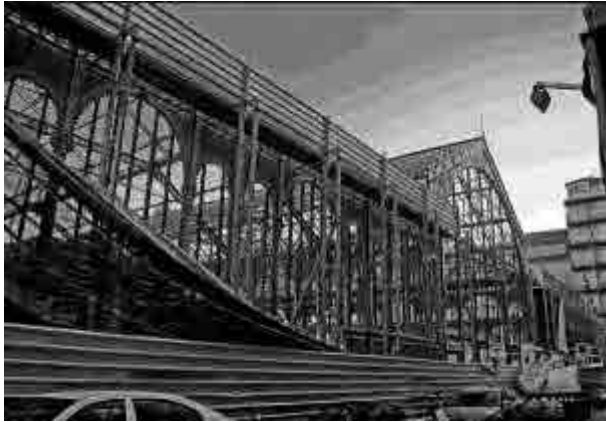
Fig. 258 Esqueleto del mercado durante los trabajos de rehabilitación.
