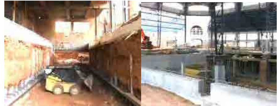
Fig. 443 Trabajos en la cimentación. Micropilotes en todo el perímetro del edificio. Imágenes: extraídas del video sobre la reforma del mercado de Sabadell, disponible en youtube.
