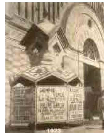
Fig. 799 Mingitorio (hoy desaparecido) instalado en la fachada sur del edificio, obra del arquitecto Pablo Montguío Segura, en 1923. Fuente: Archivo de Luís Salamó.
