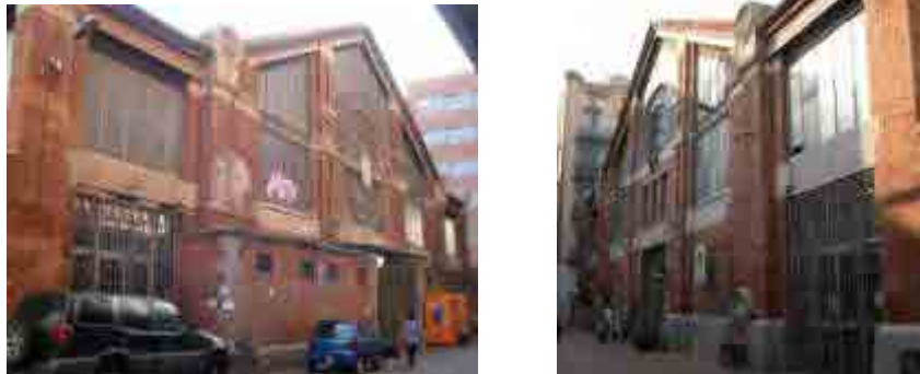
Fig. 716 Fachadas antes de la reforma. Fotos: Autora
