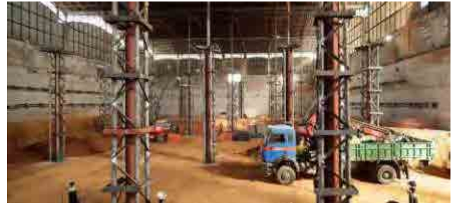
Fig. 704 Interior del mercado en obras donde puede apreciarse el apuntalamiento de la estructura original dado que se han excavado los sótanos. Foto: Adrià Goula, Mateo Arquitectes
