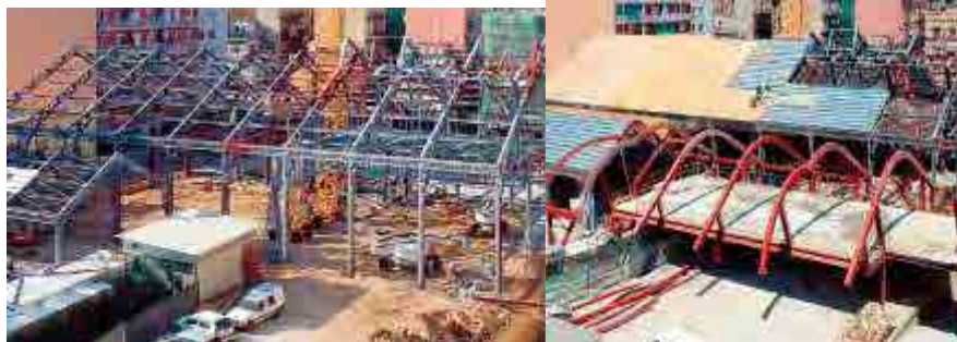
Fig. 481 Fases diferentes del proceso de remodelación y rehabilitación del nuevo mercado de la Barceloneta. Fotos: El Periódico 26/03/2007 p.6
