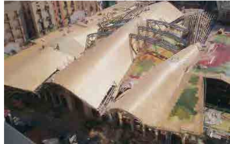
Fig. 155 Durante los trabajos de colocación de las piezas cerámicas.
