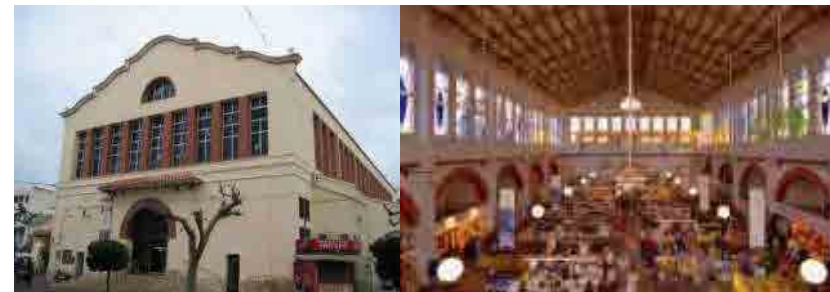
Fig. 68 Mercado de Amposta (vistas exterior e interior)
