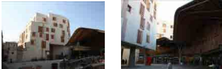
Fig. 150 Vistas del mercado y los edificios destinados a vivienda.
