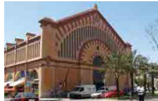
Fig. 818 Fachada principal. Estado actual. Foto: autora
