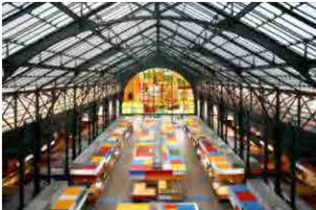
Fig. 262 Imagen del interior después de la rehabilitación, con los nuevos puestos, la vidriera restaurada y limpiada, la estructura restaurada y la cubierta transparente de la nave central.
