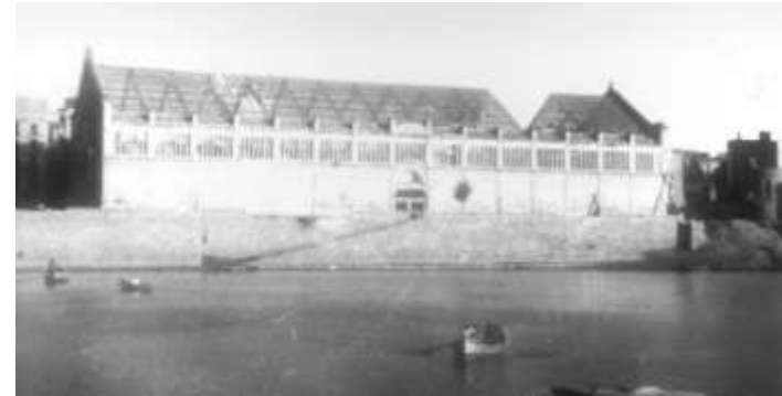
Fig. 807 Imagen del edificio en 1940 donde pueden apreciarse los daños sufridos por la cubierta que perdió todas sus tejas. Fuente: Archivo de Luís Salamó.
