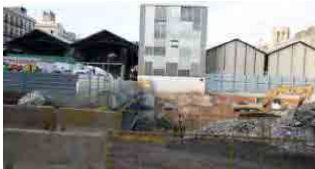
Fig. 128 Estado actual de las obras en la plaza la Garduña. Abril de 2011.
