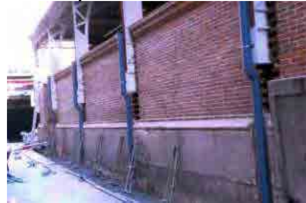
Fig. 572 Apuntalamiento en fachadas. Foto: PB2
