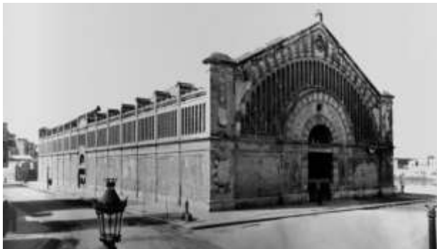
Fig. 806 El edificio una vez finalizada la guerra en 1940, que resultó deteriorado por la metralla. Desapareció también la arboleda de la calle Maragall, posteriormente llamada calle del Generalísimo. Fuente: Archivo de Luís Salamó.
