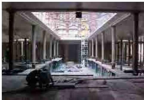
Fig. 418 Apoyo de pilar definitivo de la estructura del mercado, encofrados de la losa semisótano. Fuente: MCPC
