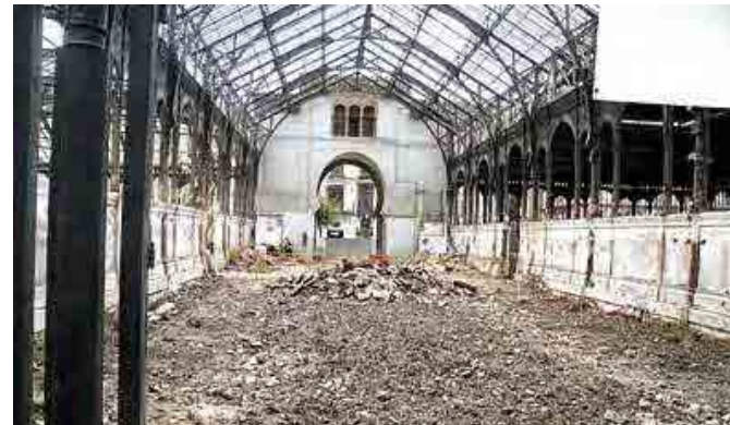
Fig. 257 Demolición de puestos y de entreplanta. Retirada de placas de uralita en las cubiertas. Foto: Diario Sur
