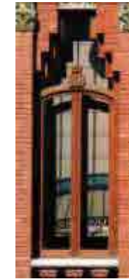
Fig. 428 Izq. Detalles de la restauración de los canecillos de madera y cubierta en la fachada Jorge Juan. Der. Detalle de ventana y carpintería de madera del salón noble en la misma fachada, tras la restauración. Fuente: Libro Mercado de Colón, historia y rehabilitación, págs. 206 y 207.
