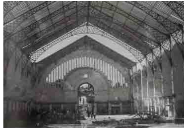
Fig. 808 Interior del mercado. Puede observarse la falta de una de las armaduras de la cubierta. Fuente: Archivo de Luís Salamó.
