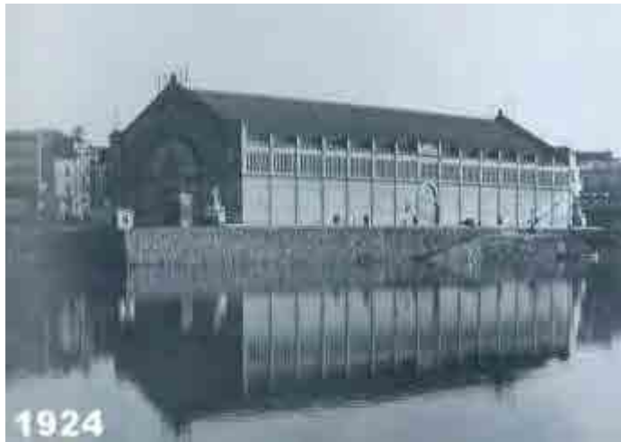
Fig. 800 El mercado en 1924, puede apreciarse que está finalizado el muro de contención, sólo en la parte del mercado. Fuente: Archivo de Luís Salamó.
