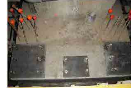
Fig. 223 Armado del encepado de 3 micropilotes con los conectores colocados con resina epoxi, junio de 2009. Derecha, encepado acabado a la espera de la introducción del mortero sin retracción bajo las placas metálicas.
