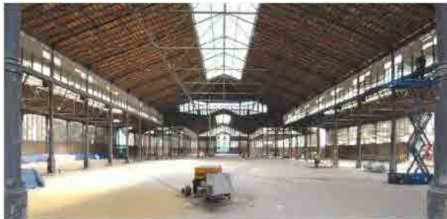
Fig. 233 Vista general nave central y laterales, mayo de 2008
