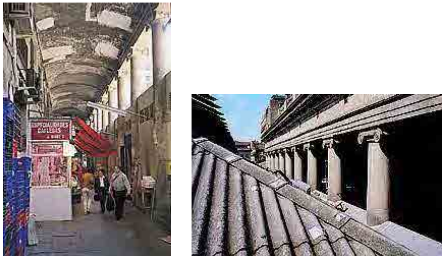
Fig. 109 Izq. Pasadizo lateral antes de la reforma, Der. Cubierta de 1914 y las columnas jónicas -hasta ahora inapreciables- que rodeaban el recinto. Fotos: Enrique Marco. Fuente: Quadern Central num. 51, Boqueria, la gran restauració .
