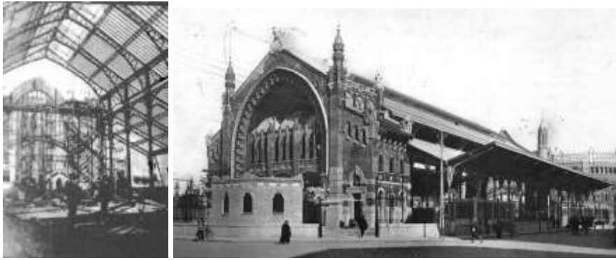
Fig. 377 Izquierda: La estructura metálica de la cubierta durante su construcción, fuente: Informes Generales de la Construcción, Vol. 52. Derecha: fotografía antigua del mercado de Colón, visto desde la calle Filipinas (Jorge Juan). Fuente: COAC
