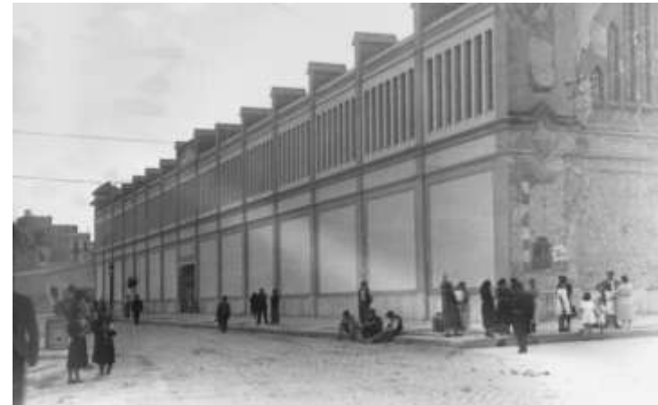
Fig. 810 Fotografía que muestra la fachada lateral reparada, aún falta restaurar la fachada norte. Fuente: Archivo de Luís Salamó.
