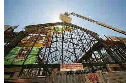
Fig. 259 Trabajos en la vidriera de la fachada posterior, desmontaje y limpieza.
