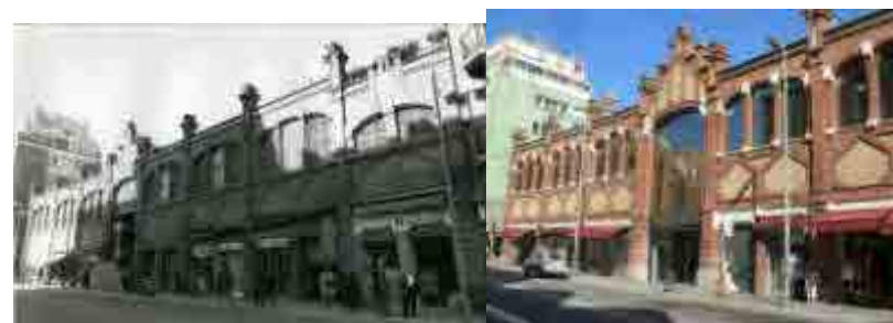
Fig. 20 Mercado de Sarrià, antes y después de la reforma.
