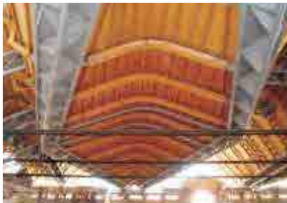
Fig. 157 Detalles estructura de la cubierta
