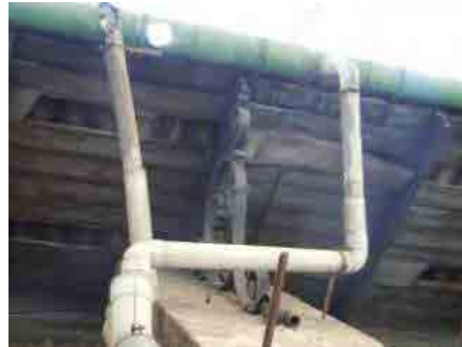
Fig. 677 Estado actual de las obras, aún pendientes los trabajos de recuperación de la cubierta. Julio de 2012. Foto: Autora
