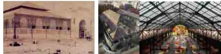
Fig. 7 Mercado Atarazanas, Málaga. Izq. Postal de 1880. Derecha: El mercado en obras de rehabilitación, fotos: DiarioSur.es
