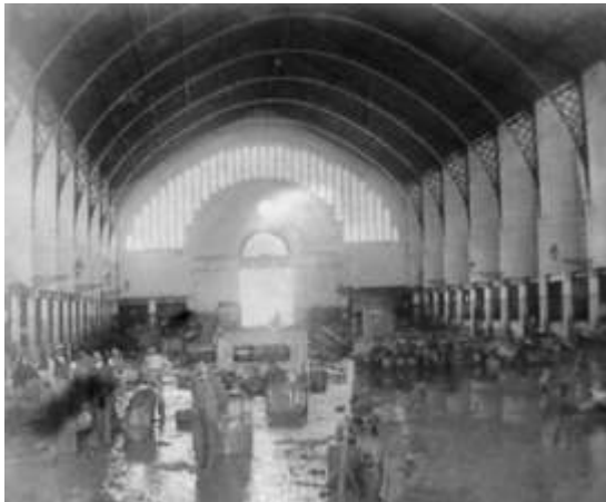
Fig. 793 Vista interior del mercado, inundado después de una riada en 1907. Fuente: Archivo Luís Salamó
