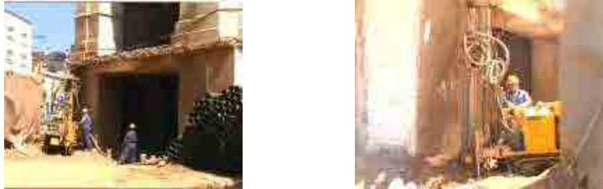
Fig. 444 Apeamiento con peines de micropilotes en los pilares de los pórticos principales. Imágenes tomadas del video.
