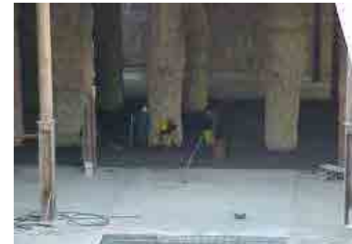
Fig. 411 Vista de la ejecución de la losa del primer sótano y de los pilotes de apoyo de la portada. Fuente: MCPC
