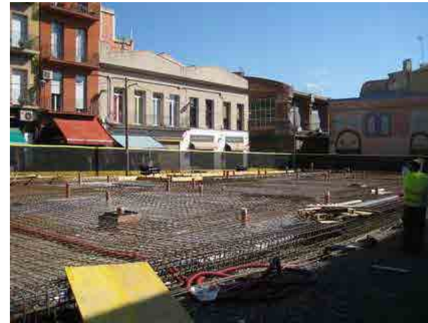
Fig. 765 Construcción del mercado provisional, al fondo puede observarse el mercado Maignon. Foto: Ayuntamiento de Badalona
