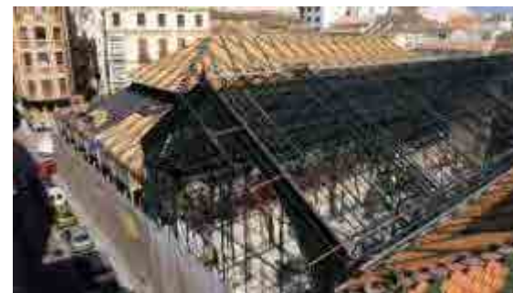
Fig. 260 Trabajos en las cubiertas de las naves. Foto: laopiniondemalaga.es
