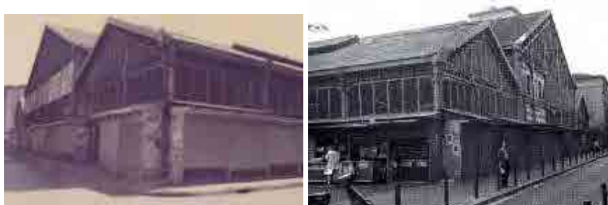
Fig. 461 El mercado antes de la rehabilitación. Foto izq.: página web IMMB Foto derecha, publicada en El Periódico, 26/03/2007 p.7
