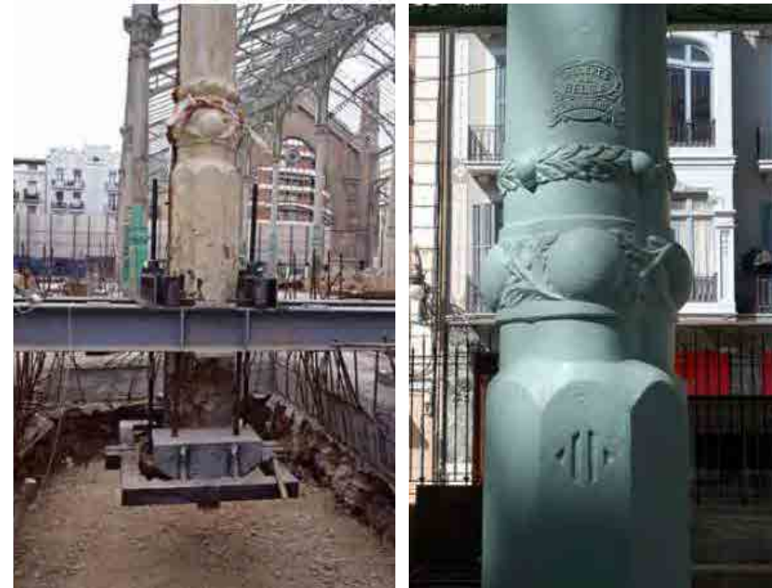
Fig. 403 Pilares de fundición originales. Fuente: informe AUMSA
