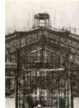
Fig. 197 Las tejas fueron reemplazadas en su totalidad y fueron ajustados los listones de madera en función de las nuevas piezas. A la derecha fotografía hecha durante las obras.
