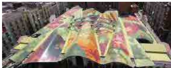
Fig. 154 Fotos: proceso constructivo de la cubierta
