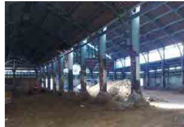
Fig. 567 Imagen del mercado antes de la excavación. Foto: IMMB
