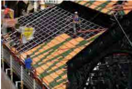
Fig. 261 Trabajos en las cubiertas de las naves. Foto: laopiniondemalaga.es
