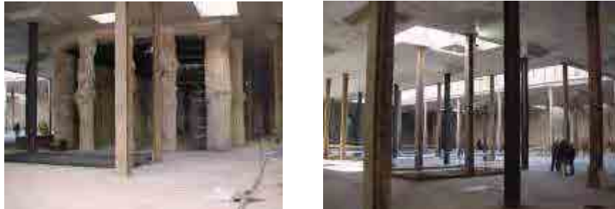
Fig. 417 Colocación de pilares de apoyo de la estructura del mercado, colocación de ábacos de apoyo de la losa semisótano. Fuente: Informe AUMSA
