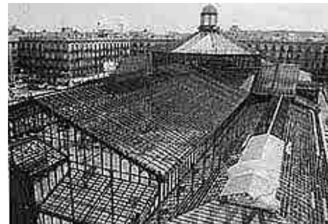
Fig. La construcción del mercado, fuente: AMA
