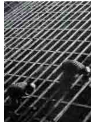
Fig. 197 Las tejas fueron reemplazadas en su totalidad y fueron ajustados los listones de madera en función de las nuevas piezas. A la derecha fotografía hecha durante las obras.
