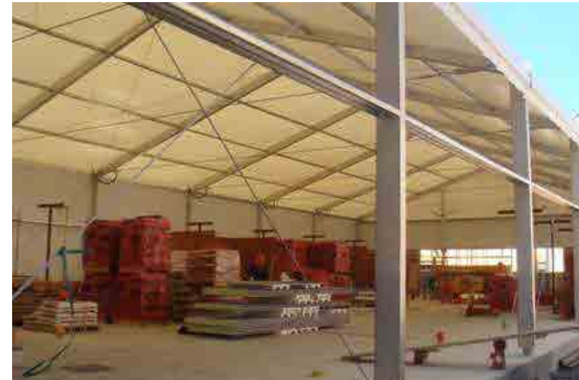
Fig. 766 Construcción del mercado provisional. Foto: Ayuntamiento de Badalona
