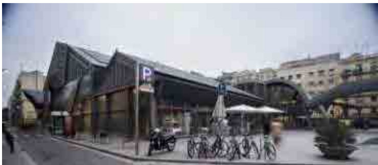
Fig. 486 Diversas vistas de las fachadas, estado actual. Fotos: Plataforma Arquitectura
