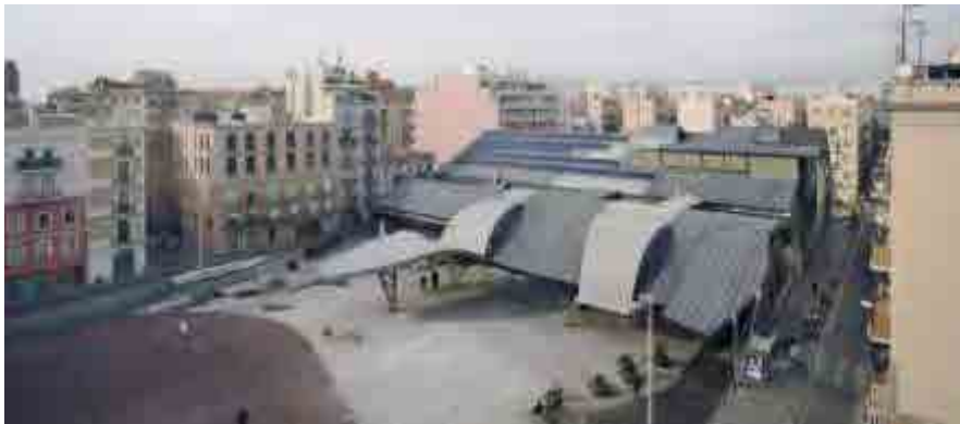
Fig. 484 La cubierta y su nueva configuración. Foto: Plataforma Arquitectura
