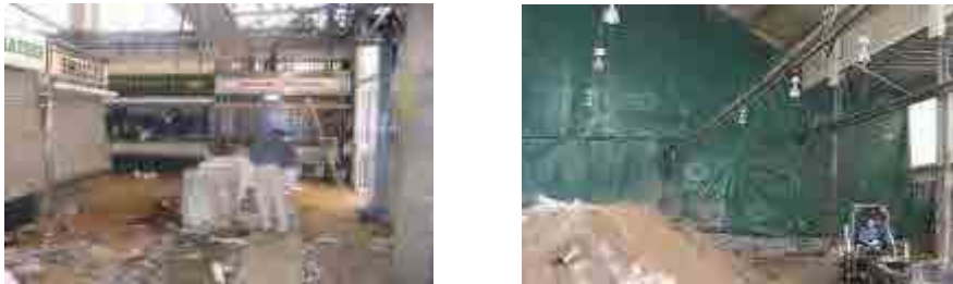
Fig. 720 Trabajos de demolición en el interior. Fotos: IMMB
