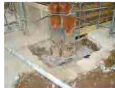
Fig. 225 Izq. Repicado de la base de un pilar para su extracción. Der. Punto de apoyo de la micropilotadora.
