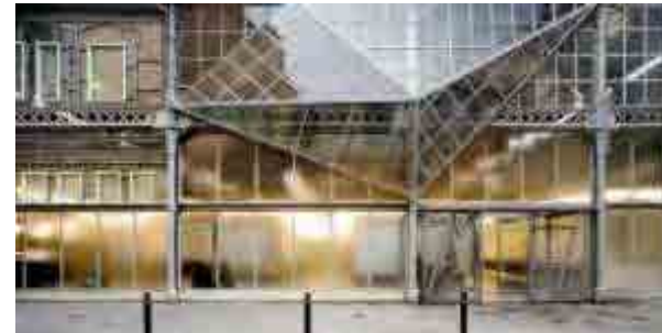
Fig. 487 Vistas de fachada, estado actual. Foto: Plataforma Arquitectura
