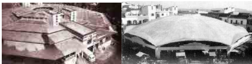
Fig. 31 Mercado de Olavide. Derribado en 1974 Fig. 32 Mercado de Algeciras (1933).
