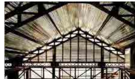
Fig. 482 Diversos momentos del proceso de rehabilitación de la estructura de hierro original. Fotos: El Periódico. 26/03/2007 p.3
