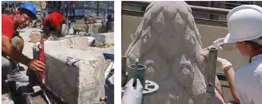
Fig. 423 Trabajos de restauración. Fuente: informe AUMSA
