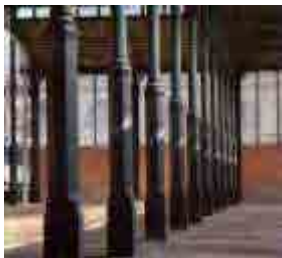
Fig. 202 Los pilares de fundición después de los trabajos de restauración.
