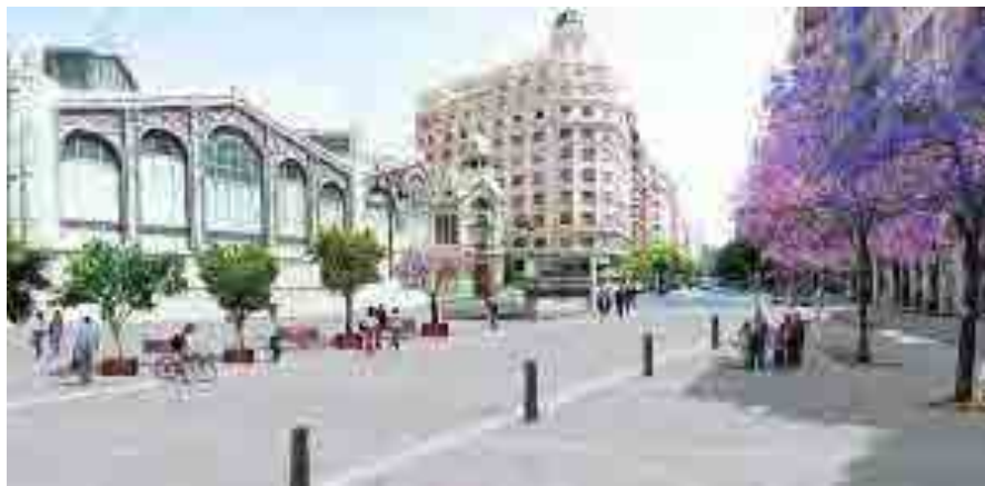
Fig. 363 Imágenes del estado de las obras en septiembre de 2011, abajo imagen virtual de la plaza terminada. Tomadas de: lasprovincias.es “Así será la plaza del mercado central”, nota publicada el 10 de septiembre de 2011.
