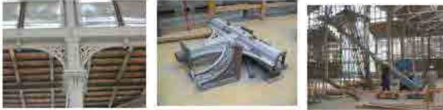
Fig. 217 Detalles de la reparación de algunas piezas de la estructura.
