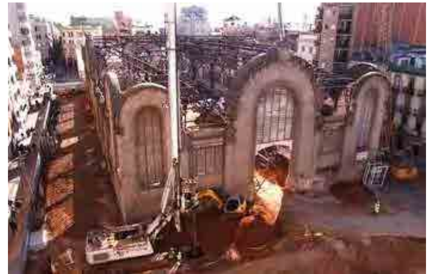
Fig. 646 Imagen de las obras en febrero de 2012. Foto: Diaridetarragona.com 10/02/2012
