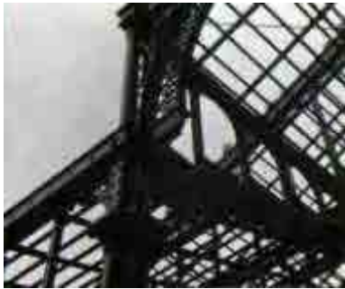
Fig. 200 Izq. La estructura del edificio fue limpiada mediante chorro de arena y protegida posteriormente con nímio. Der. Mediante chorro de arena se dejó al descubierto la obra de fábrica.
