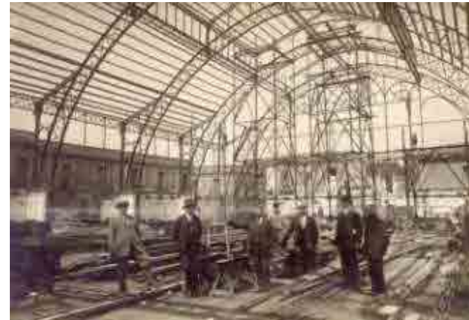
Fig. 771 Construcción del mercado, 1924. Fuente: Museo de Badalona. Archivo Josep M. Cuyàs. Fotógrafo Nyssen.
