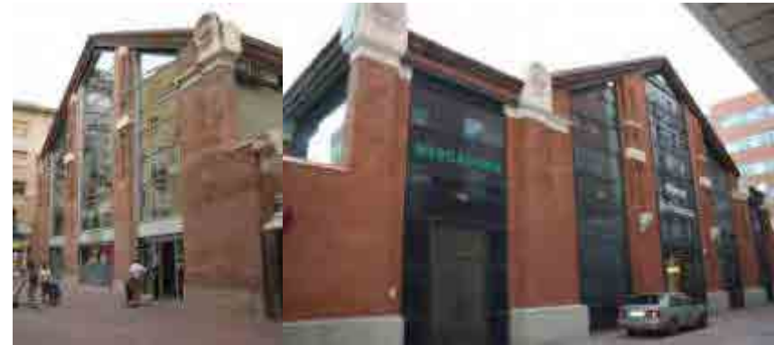
Fig. 15 Estado actual mercados del Clot y de la Unión. Rehabilitados.
