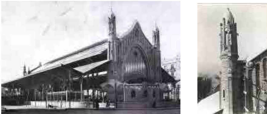
Fig. 378 Vista desde la calle Conde Salvatierra. Fuente: COAC. Derecha, vista del pináculo lateral durante su construcción.
