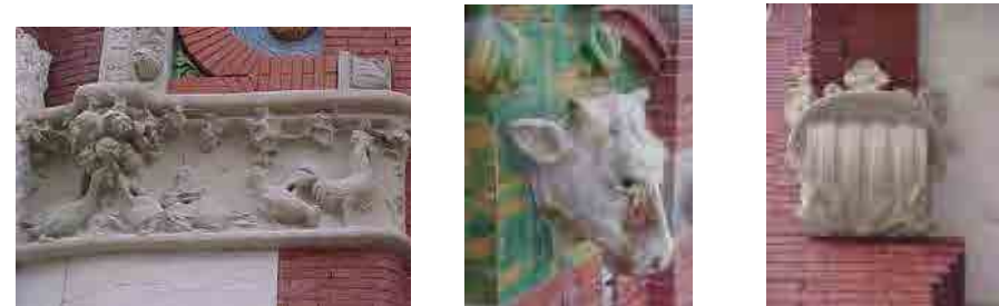
Fig. 424 Trabajos de restauración. Fuente: informe AUMSA
