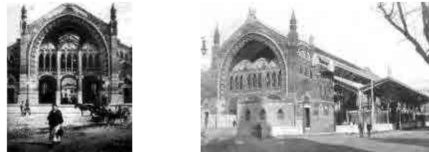
Fig. 380 Izquierda fachada en 1916, derecha el mercado en 1920. Tarjetas postales
