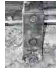
Fig. 198 Izq. Limpieza de albañales. Centro: perforaciones practicadas en los pilares para el retiro del hormigón que los obstruía. Der: Nuevos tornillos y arandelas de plomo sustituyeron a los originales en mal estado.
