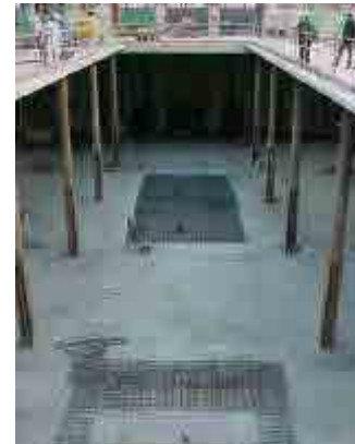
Fig. 411 Vista de la ejecución de la losa del primer sótano y de los pilotes de apoyo de la portada. Fuente: MCPC
