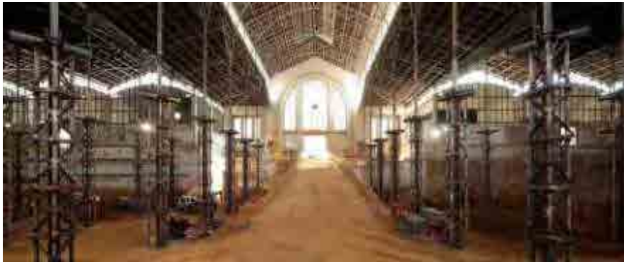
Fig. 703 Interior del mercado en obras donde puede apreciarse el apuntalamiento de la estructura original dado que se han excavado los sótanos. Foto: Adrià Goula, Mateo Arquitectes
