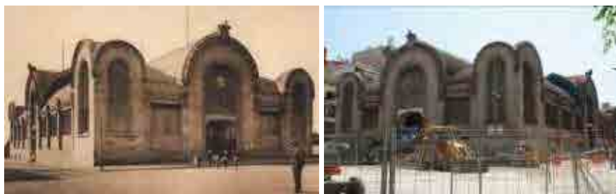
Fig. 22 Mercado Central de Tarragona. Izq. El mercado en 1920, derecha el mercado en 2010, en obras de rehabilitación.
