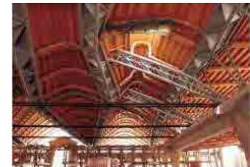
Fig. 156 Vistas interiores del mercado de Santa Caterina con las estructuras de madera que sustentan la cubierta. Fotos: Monográfico de El Periódico, 25/07/2005
