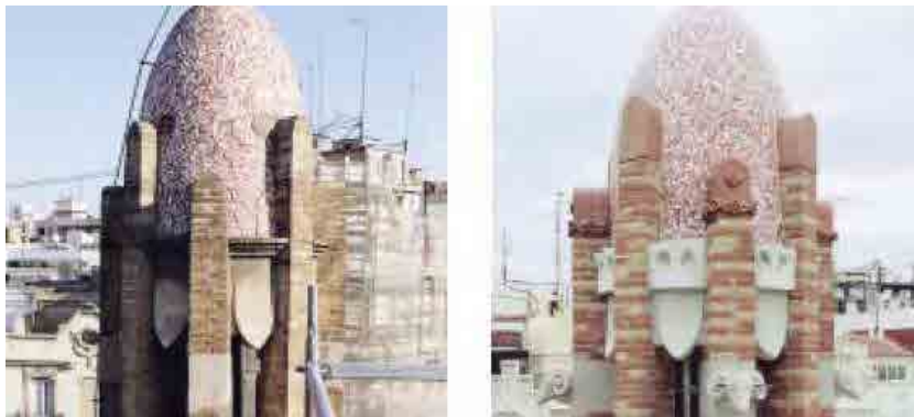
Fig. 427 Proceso de recuperación de pináculos en la fachada Conde Salvatierra. Fuente: Informe AUMSA
