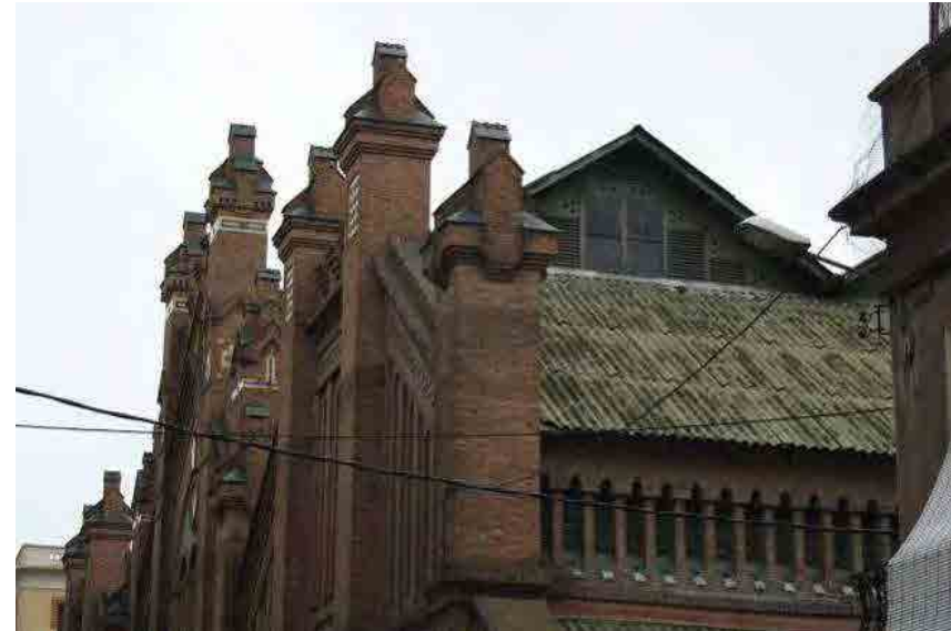
Fig. 679 Estado actual, aún pendientes los trabajos en fachadas y cubiertas. Fotos: Autora
