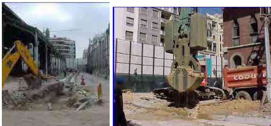
Fig. 393 Murete guía y excavación de pantallas. Fuente: MCPC
