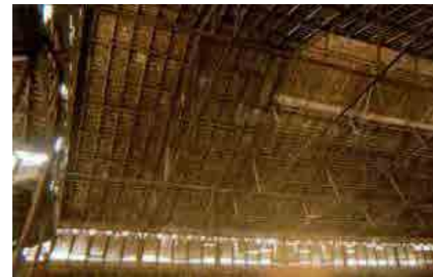
Fig. 194 Madera y fibrocemento habían sustituido al vidrio que fue repuesto en la restauración.
