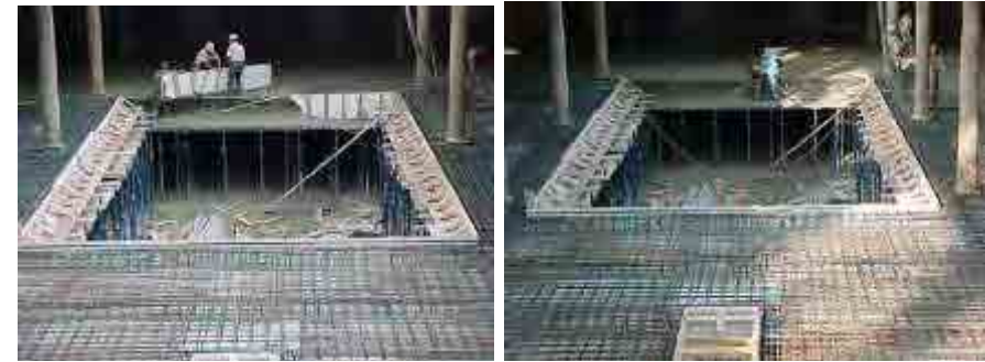
Fig. 415 Armados y hormigonado de la losa. se dejó previsto un hueco central en la planta baja que sirve de conexión con la planta inferior, creando un espacio de interrelación que permite la entrada de luz. Fuente: MCPC
