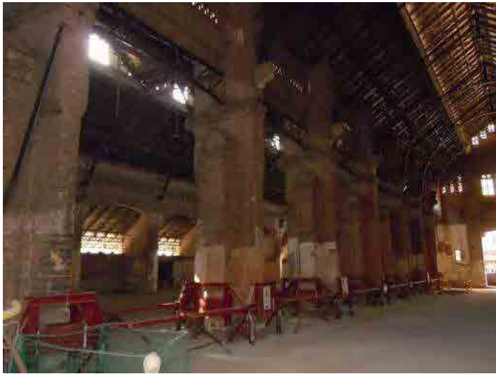
Fig. 674 Estado actual de las obras, julio 2012. Foto: Autora
