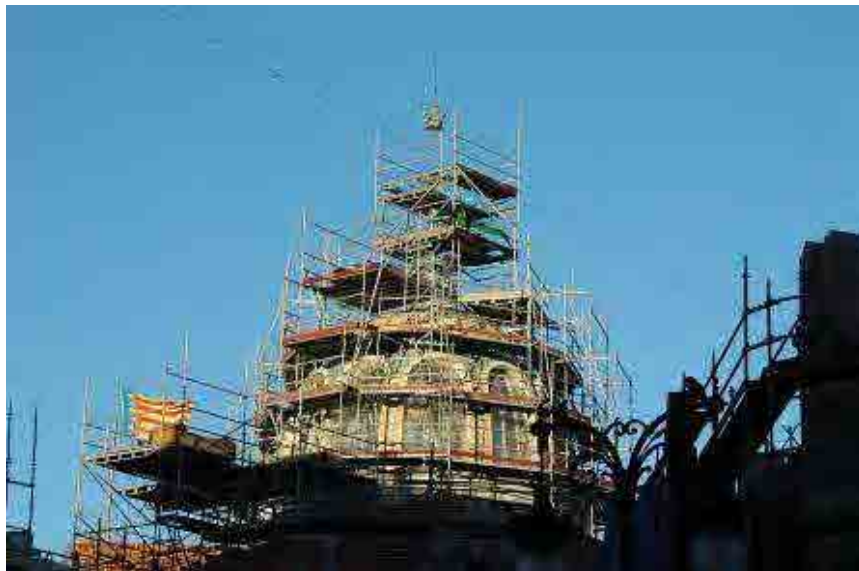
Fig. 356 Detalles de las reparaciones en cubierta. Las piezas repuestas se hicieron prácticamente idénticas a las originales. La empresa Corsan-Corvian quien ejecutó las obras, encargó a Tejas Borja la reproducción de la losa especial 34,5 x 34,5 x 2,5 cm de arcilla cocida de base blanca natural y la sustitución de las tejas planas. Fotos: página web tejasborja.es
