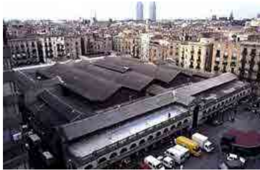
Fig. 72 Santa Catalina. Vista aérea. Antes de la rehabilitación.
