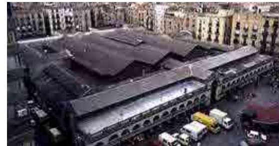
Fig. 144 Vista del mercado antes de la reforma. Foto: IMMB
