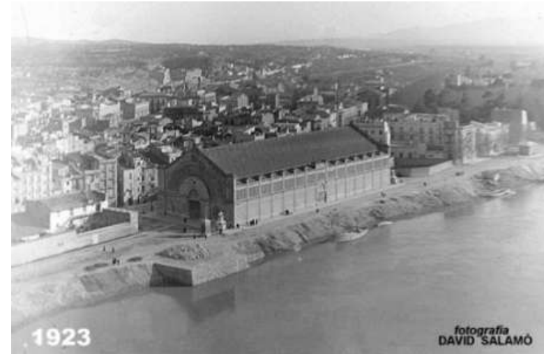
Fig. 798 El mercado en 1923, en la foto puede apreciarse el comienzo de la construcción del muro de contención que protege a los cimientos. Fuente: Archivo de Luís Salamó, foto inédita de David Salamó.
