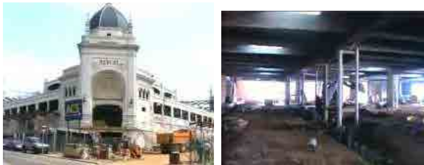
Fig. 445 Derecha, el mercado en obras. Izquierda detalle de la ejecución del muro pantalla de la nave de ventas. Imágenes tomadas del video.
