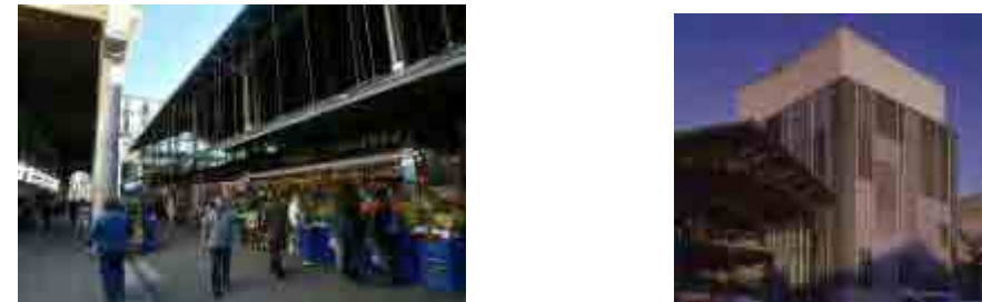
Fig. 111 Izq. Interior del mercado donde pueden apreciarse las plazas fijas de vidrio que cuelgan de la propia estructura del mercado. Der. El nuevo edificio de servicios.
