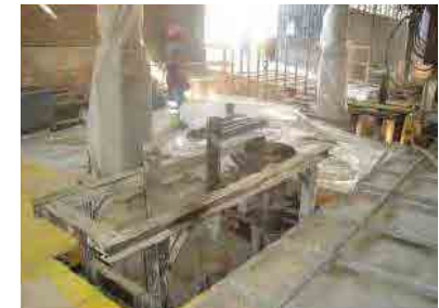
Fig. 225 Izq. Repicado de la base de un pilar para su extracción. Der. Punto de apoyo de la micropilotadora.
