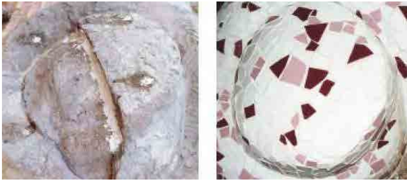
Fig. 426 Proceso de recuperación de pináculos y trencadís. Fuente: Informe AUMSA
