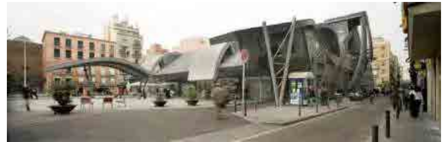
Fig. 488 Vista general. Foto: Plataforma Arquitectura
