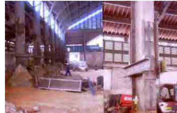
Fig. 569 Apuntalamiento pilares centrales Foto: PB2
