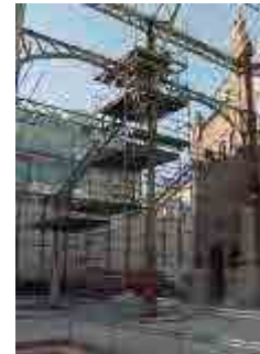
Fig. 420 Montaje de andamios para el reconocimiento y reparación de la estructura. Fuente: Informe AUMSA
