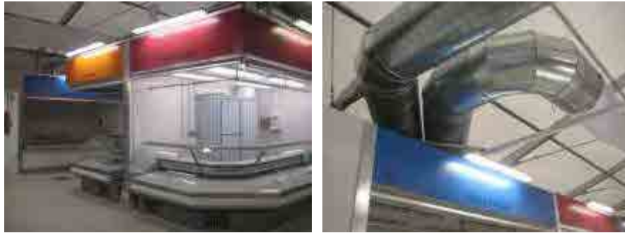
Fig. 767 Imágenes interiores del mercado provisional de Maignon, actualmente ya en funcionamiento. Foto: Ayuntamiento de Badalona
