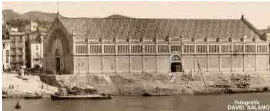
Fig. 796 El mercado hacia 1908, aún no existía el muro de contención que protege los cimientos. Pueden apreciarse las tejas planas de cerámica vidriada de la cubierta y el estucado de la fachada. Fuente: Cortesía del archivo de Luís Salamó, foto inédita de David Salamó.
