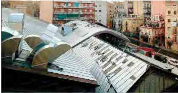
Fig. 483 El tejado del mercado de la Barceloneta, durante el proceso de remodelación del recinto. Foto: El Periódico. 26/03/2007 p.8
