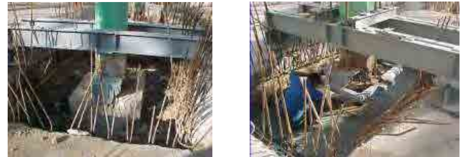
Fig. 406 Apeo de la actual estructura. Colocación de vigas de apeo y apeo provisional del pilar. Fuente: MCPC
