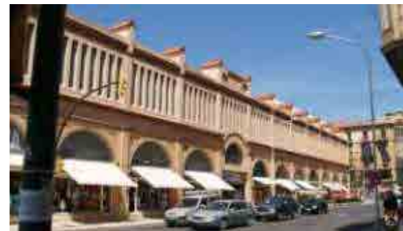
Fig. 819 Fachada lateral con tiendas. Foto: Autora
