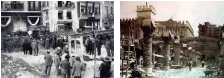
Fig. 338 Izquierda: Colocación de la primera piedra, mercado central, 1915. Derecha, construcción del sótano, pilares circulares de ladrillo. Imágenes: tomadas de valenciablancoynegro.blogspot.com
