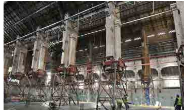
Fig. 670 Obras en el mercado. Foto: Jordi Casañas. Fuente: Ayuntamiento de Barcelona
