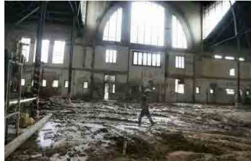
Fig. 702 Interior del mercado durante el proceso de las obras, todas las estructuras interiores derribadas. Julio de 2010. Foto: Josep Losada publicada en El Punt Avui 30/07/2010
