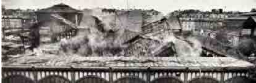
Fig. 3 La destrucción de Les Halles de Paris. (1971)
