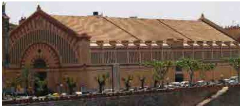
Fig. 821 Vista exterior desde el río Ebro. Estado actual. Foto: autora.
