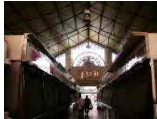
Fig. 717 Vista interior antes de la reforma. Foto: Autora
