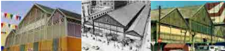
Fig. 88 De izq. a der. Mercados Barceloneta, Concepción y Hostafrancs. Detalle de la continuación de los pilares en los frontones de las fachadas.
