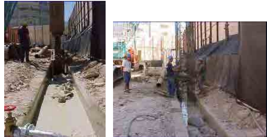
Fig. 394 Maquinaria de excavación y colocación de armadura. Fuente: MCPC
