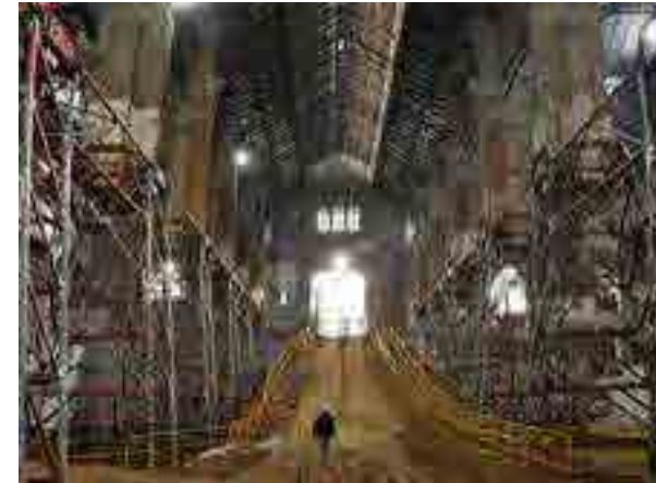
Fig. 669 Obras, en las que puede apreciarse el apuntalamiento provisional de las columnas originales.
