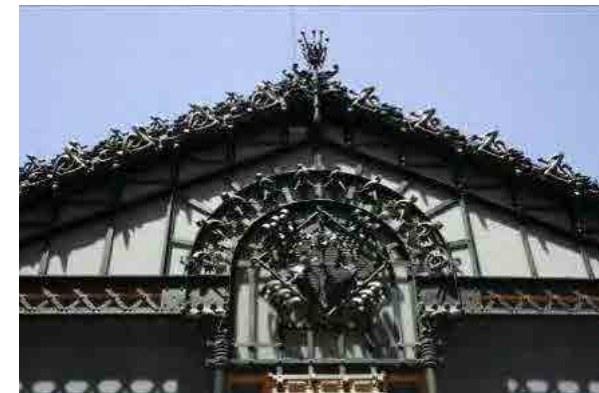
Fig. 576 Imágenes del edificio poco antes de concluir las obras. Fotos: Autora
