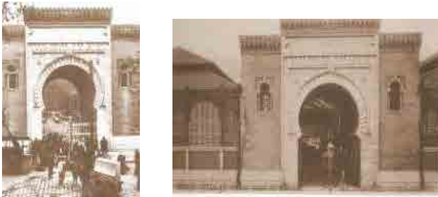
Fig. 249 Detalles del acceso al mercado a finales del siglo XIX
