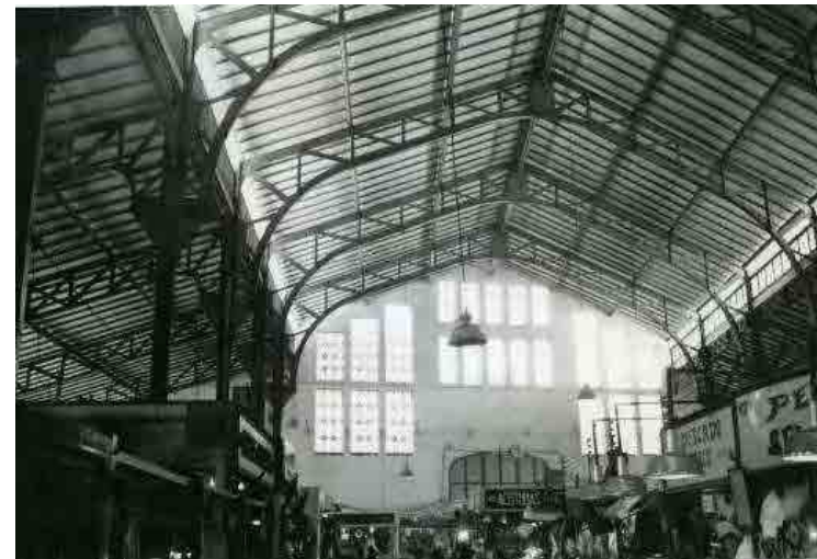
Fig. 742 Interior mercado, foto antigua, sin fecha. Fuente: COAC
