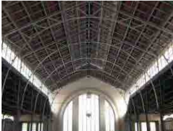
Fig. 688 Vista interior de la estructura. 2006. Foto: autora
