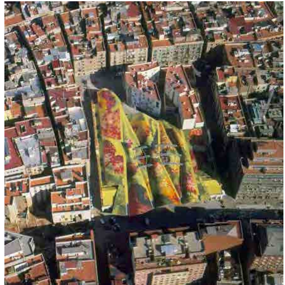
Fig. 165 Vista aérea del mercado. Imagen: Ceramica Cumella, tomada de plataformaarquitectura.cl
