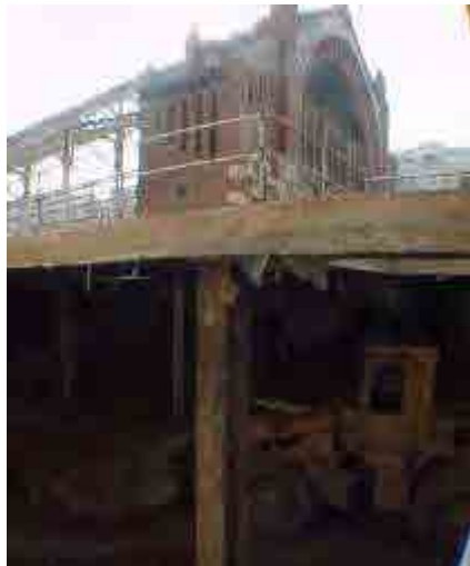
Fig. 409 Extracción de tierras bajo losa del suelo: Excavación bajo la nueva cimentación de la portada Jorge Juan y elevación de tierras y carga de camiones. Fuente: Informe AUMSA
