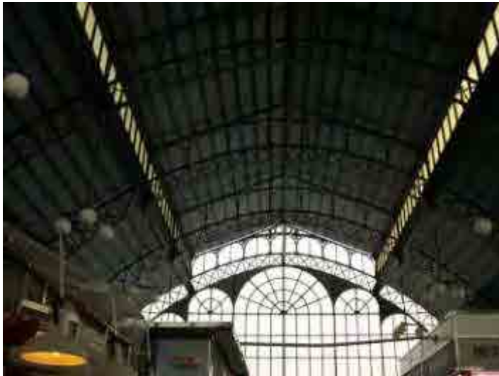
Fig. 779 Vista interior del mercado en la actualidad. Foto: Autora
