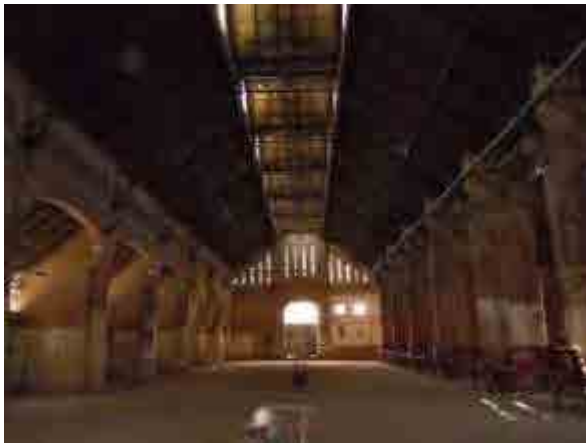
Fig. 675 Estado actual de las obras, julio 2012. Foto: Autora
