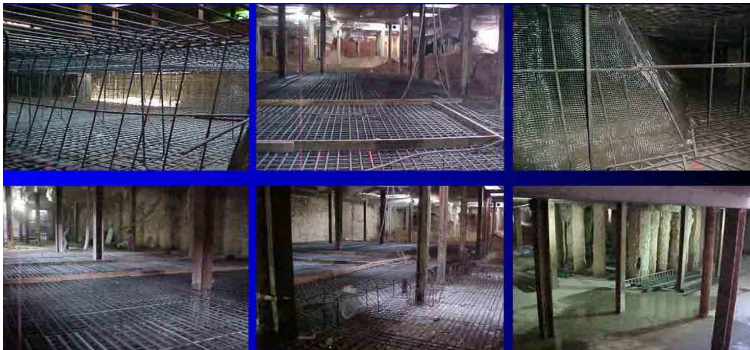
Detalles de armaduras de la losa de cimentación y su hormigonado
