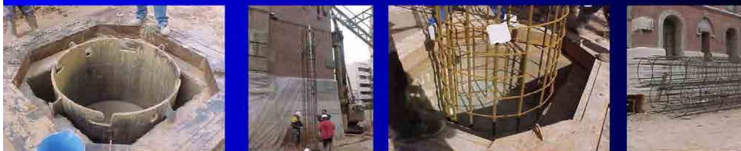
Camisa colocada y armaduras del pilote
