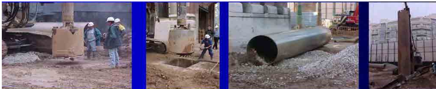
Inicio de excavación e hincada de camisa metálica
