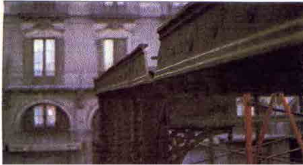
Canalones de cubierta 1977
