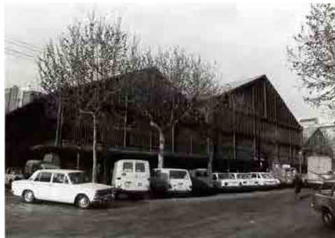
Foto: Archivo Sants. Fachada 1977
