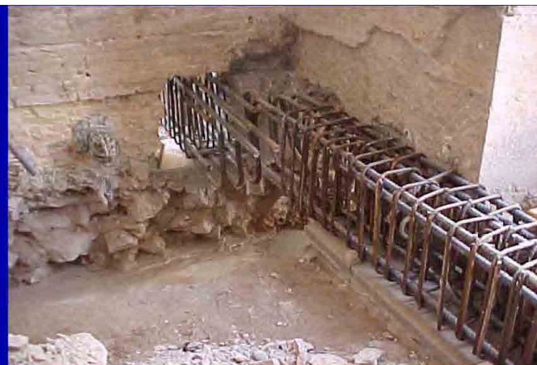
Vista interior armadura vigas
