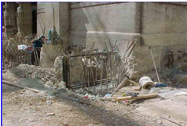
Vista exterior armadura vigas
