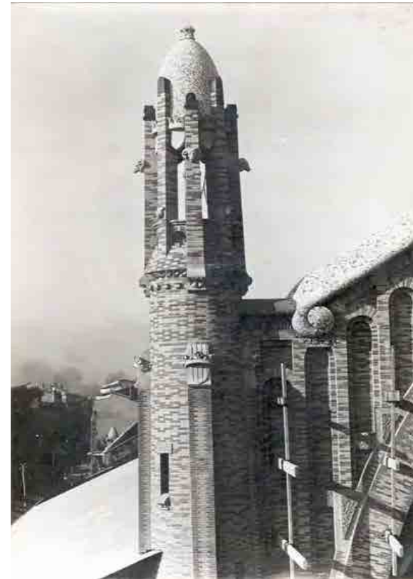
Vista del pináculo lateral de la fachada de Conde Salvatierra durante la construcción
