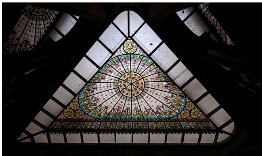
Fig.73. Lluerna. Casa Marfà. Barcelona . Foto. Consol Bancells
