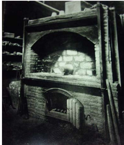
24. Forn de mufla. Taller Rigalt Fotografies fetes per: Fotografies d'art. Francisco Serra. c/ Salmeron, 156, 2 o de Barcelona. AFG
