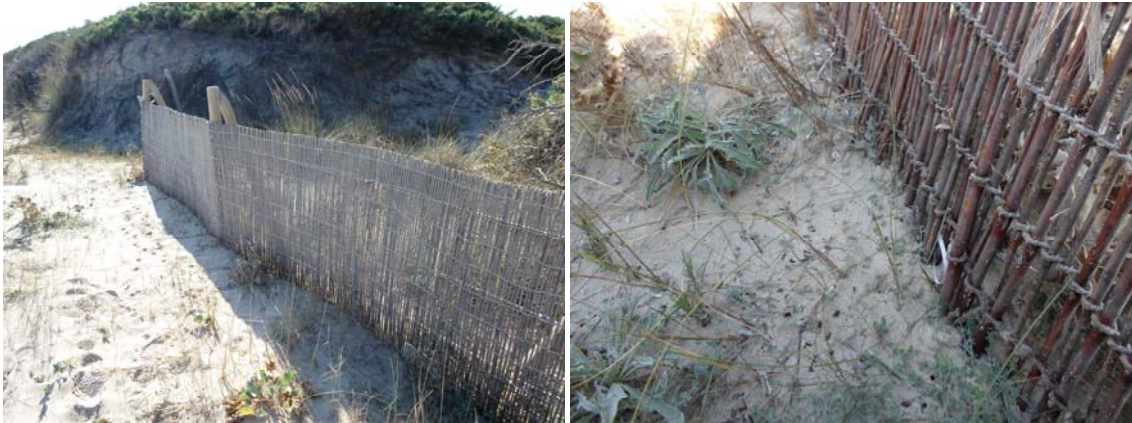
Figura 201: Imatges de detall de la trampa d'interferència sedimentària, i del baix grau d'eficiència mostrat a dia d'avui. Foto del 14/11/2013.
