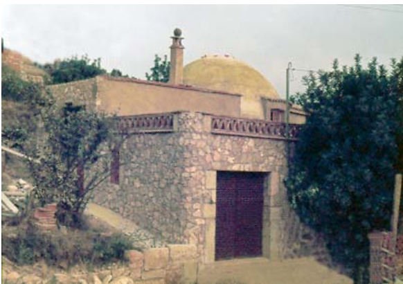
Casa de Castellvell. Procés de construcció, 1978-80.
