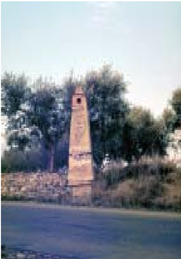
La fita d'Almoster. 1979. Un senyal a la carretera i una pregunta. Respirall d'una mina subterrània.
