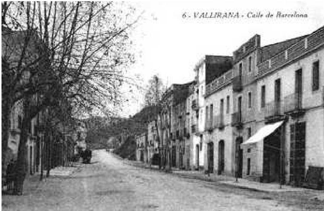
Figura 8.12. Aspecte de la carretera N-II en sentit Ordal al seu pas per Vallirana, devers principi de segle. Nota: la imatge prové d'una postal conservada a l'arxiu documental de l'Ajuntament de Vallirana.
