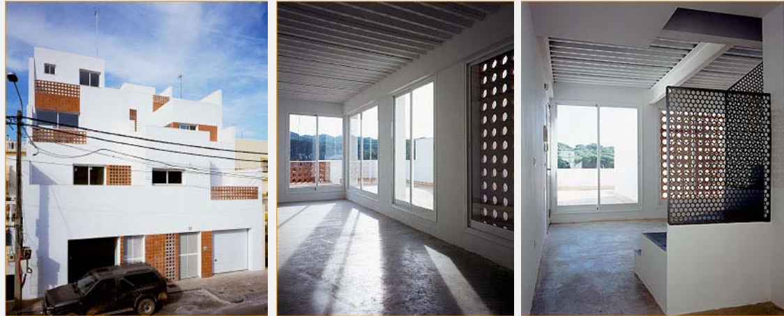
Figura 95: Exterior del edificio e interior de una de las viviendas antes de su ocupación
