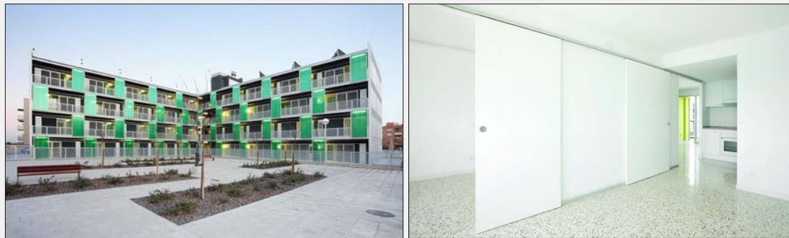
Figura 76: Exterior del edificio e interior de una de las viviendas antes de su ocupación
