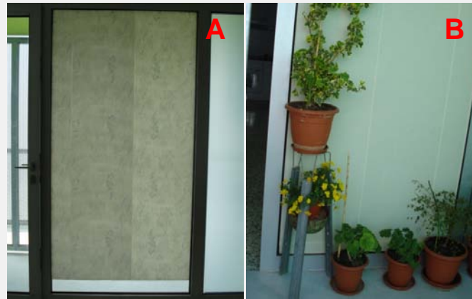
Figura 82: Puerta de entrada
