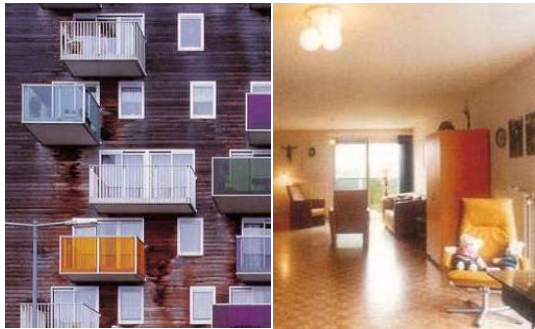
Figura 65: Exterior e interior de las viviendas de Wozoco
