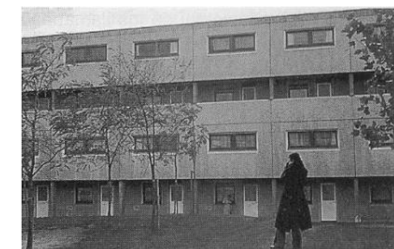
Figura 35: La industrialización abierta para la construcción de viviendas
