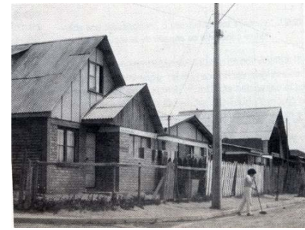
Figura 9: Desarrollo de viviendas adosadas a casetas sanitarias en Chile
