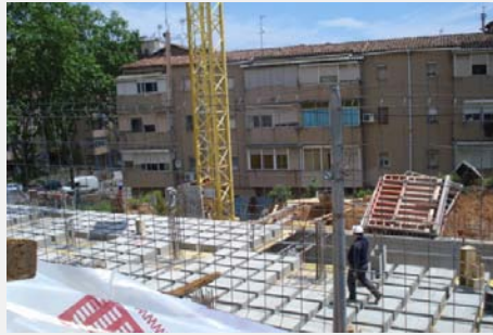
Figura 127: Viviendas en proceso de construcción en Trinitat Nova
