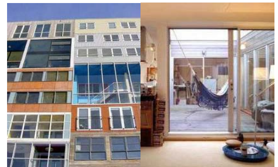
Figura 63: Exterior e interior de las viviendas de Silodam
