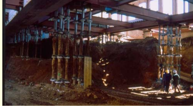
(CUADRO 12) APEO DE LA ESTRUCTURA DE UN FORJADO EXISTENTE PARA HABILITAR NUEVOS SÓTANOS
