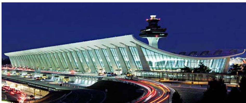
(F-73) Vista general del edificio.
