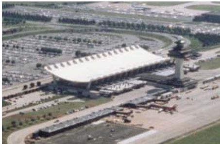
(F-70) Vista general de Aeropuerto.
