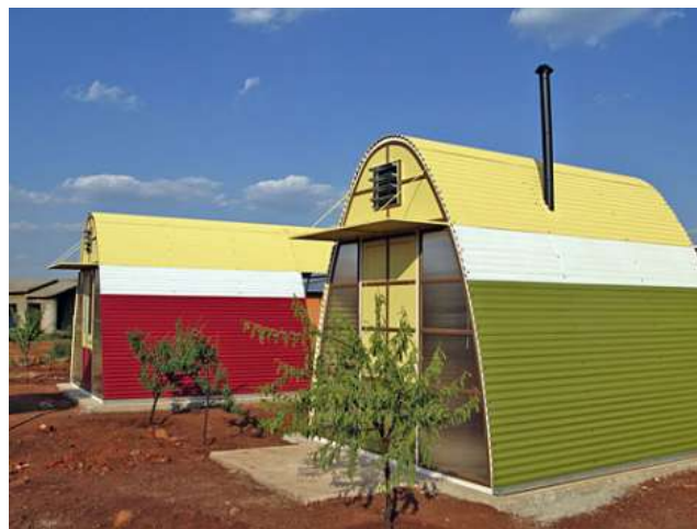
(F-87) Exterior de las casas ya construidas.
