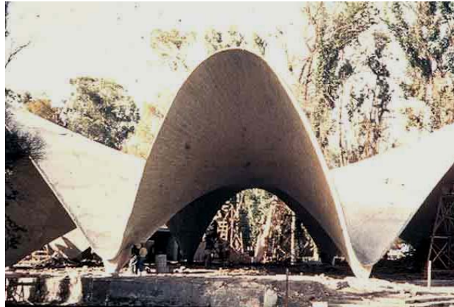
(F-83) Cubierta acabada.
