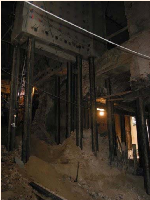
(F-11) Apeo del muro para construcción de 2 nuevos sótanos.
