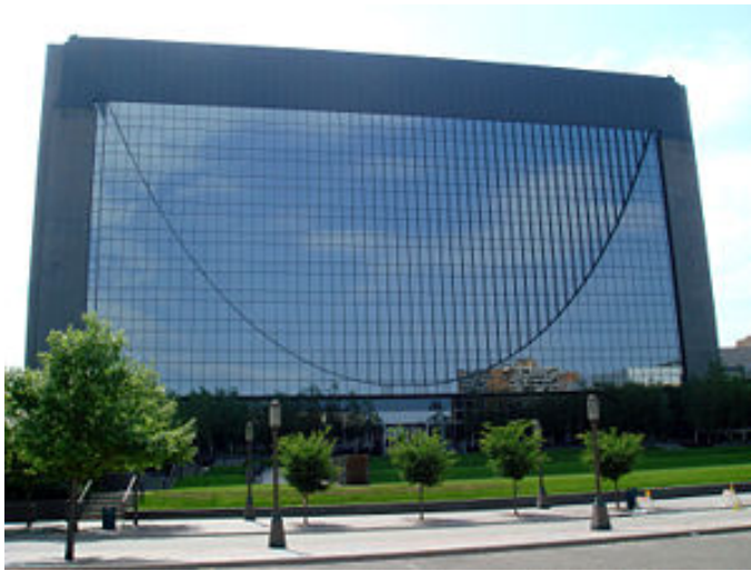
(F-74) Vista frontal del edificio.
