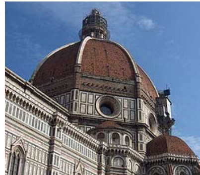
(F-35) Vista exterior de la Cúpula.
