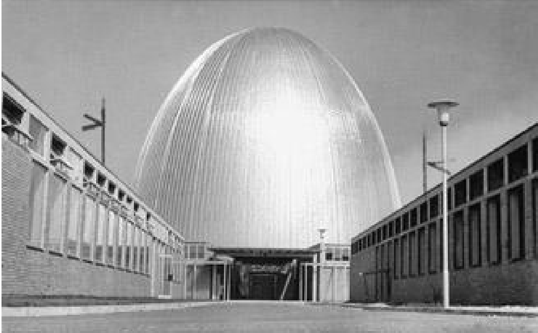
(F-64) Cubierta catenária del reactor nuclear.
