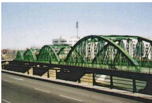
(F-21) Puente en Zaragoza
