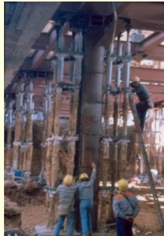
(GRAF.2: 18) Apeo de la estructura de un forjado existen para habilitar nuevos sótanos.
