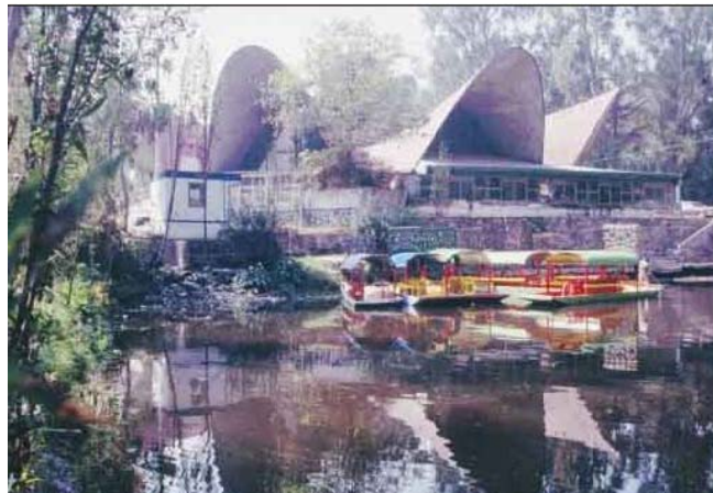
(F-84) Edificio acabado-1.
