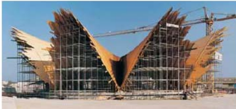
(F-80) Encofrado de la cubierta.
