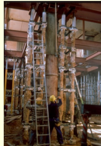
(GRAF.2: 18) Apeo de la estructura de un forjado existen para habilitar nuevos sótanos.
