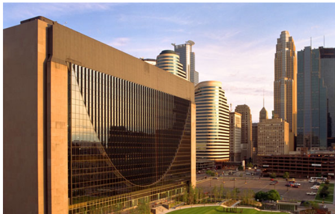
(F-75) Vista lateral con el entorno.
