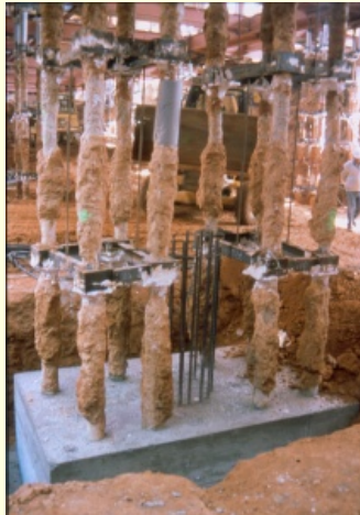
(GRAF.2: 18) Apeo de la estructura de un forjado existen para habilitar nuevos sótanos.
