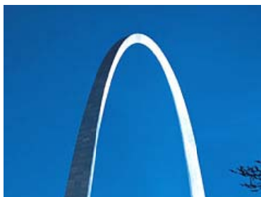
(F-68) Parte superior del Arco.
