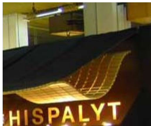
(F-95) Ampliación del extremo superior derecho de la cubierta.
