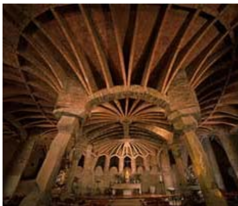
(F-41) Interior de la Cripta
