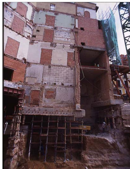
(F-12) Apeo del muro para construcción de nuevos sótanos 15 .
