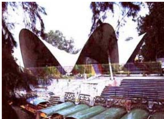
(F-85) Edificio acabado-2.
