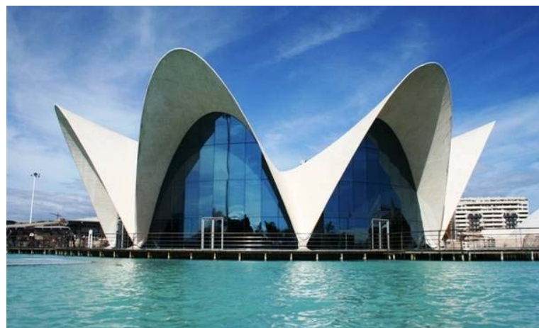
(F-82) Edificio acabado.
