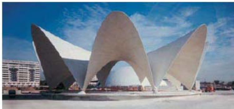
(F-81) Cubierta finalizada.
