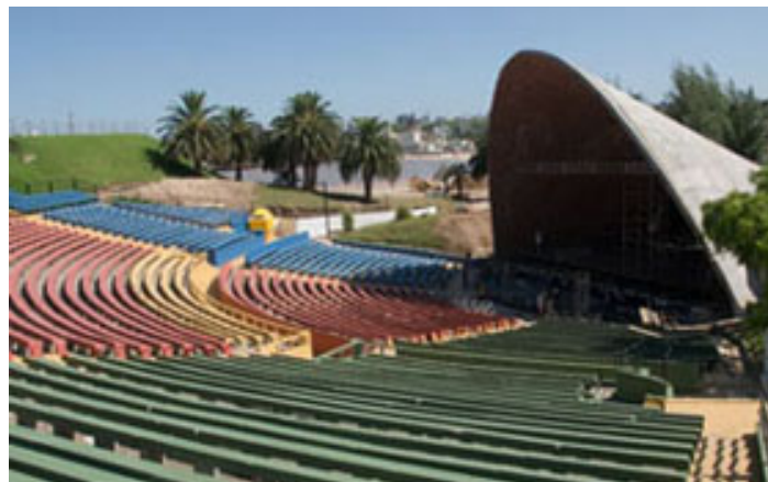
(F-91) Vista lateral derecha de la cubierta.
