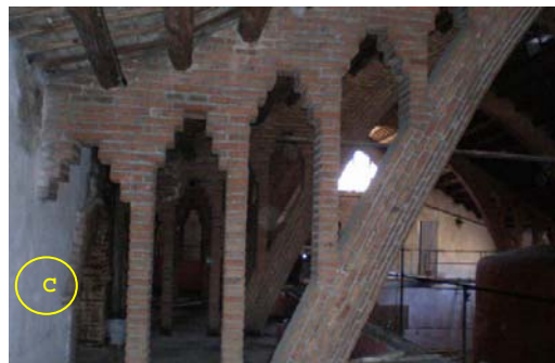
(F-38) Junto a la nave B
