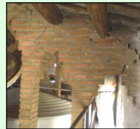
(51) Deformación: primera etapa de fisuras. (0-c)
