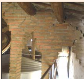
(51) Deformación: primera etapa de fisuras. (0-c)
