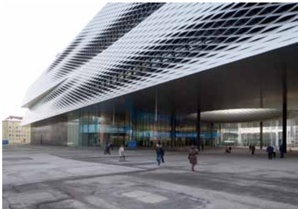
59. Herzog & De Meuron, Messe Basel, New hall, 2013 la maglia déployée scalata modula la permeabilità della facciata.
