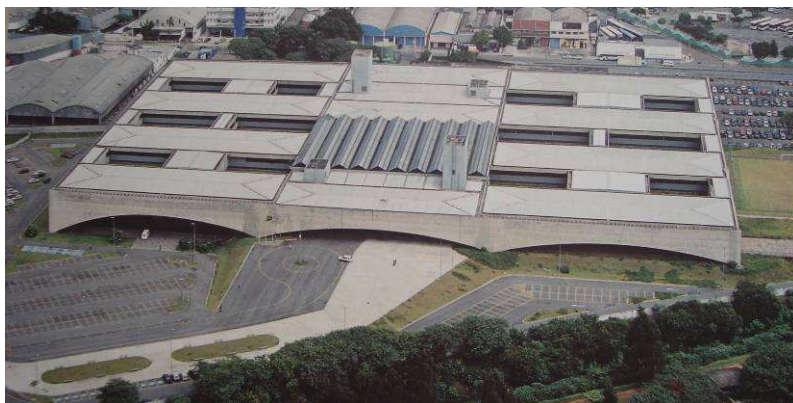
Figura 10. Vista aérea do conjunto com a cobertura evidenciando a setorização interna. Fonte: Arquivo do autor.
