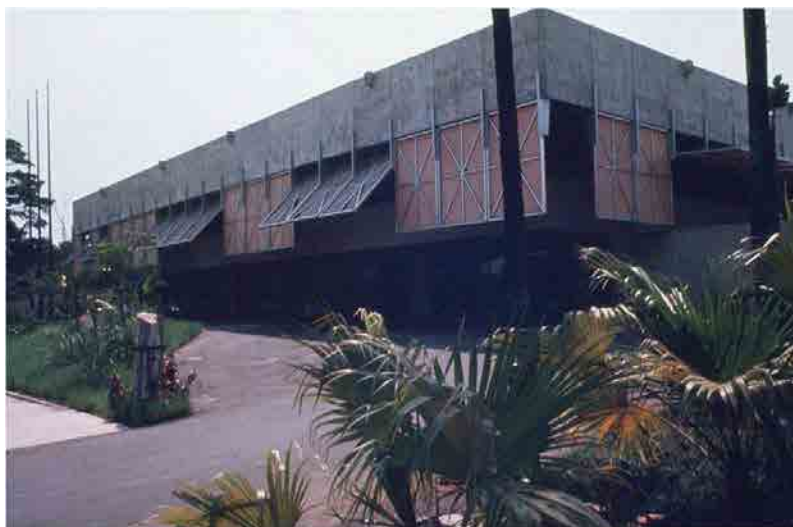
Figura 15. Vista da fachada frontal do clube Harmonia, com os painéis móveis de fechamento lateral.
