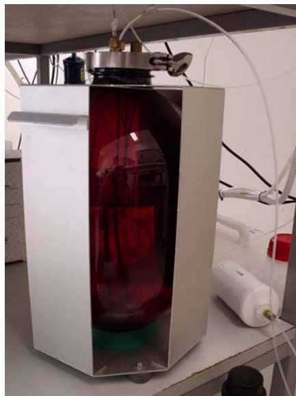
Figura 12.-Detall del tanc pressuritzat i filtre de GAC pel subministrament d'aigua a l'injector automàtic
