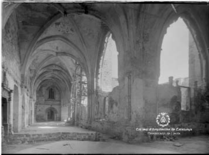
Fig. 256. Desmuntatge dels paraments instal·lats durant l'etapa militar, vista des del racó nord-est del claustre, Alejandro Ferrant, Seu Vella, Lleida, dècada de 1950.
