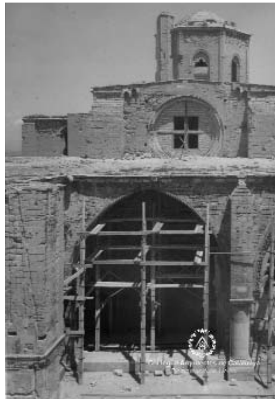
Fig. 259. Tasques de restauració a l'arcada nord de la galeria est del claustre, Alejandro Ferrant, Seu Vella, Lleida, dècada de 1950.
