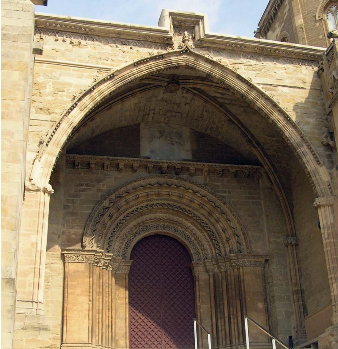
Fig. 235. Porta dels Fillols, oberta al mur de la nau sud, Seu Vella, Lleida.
