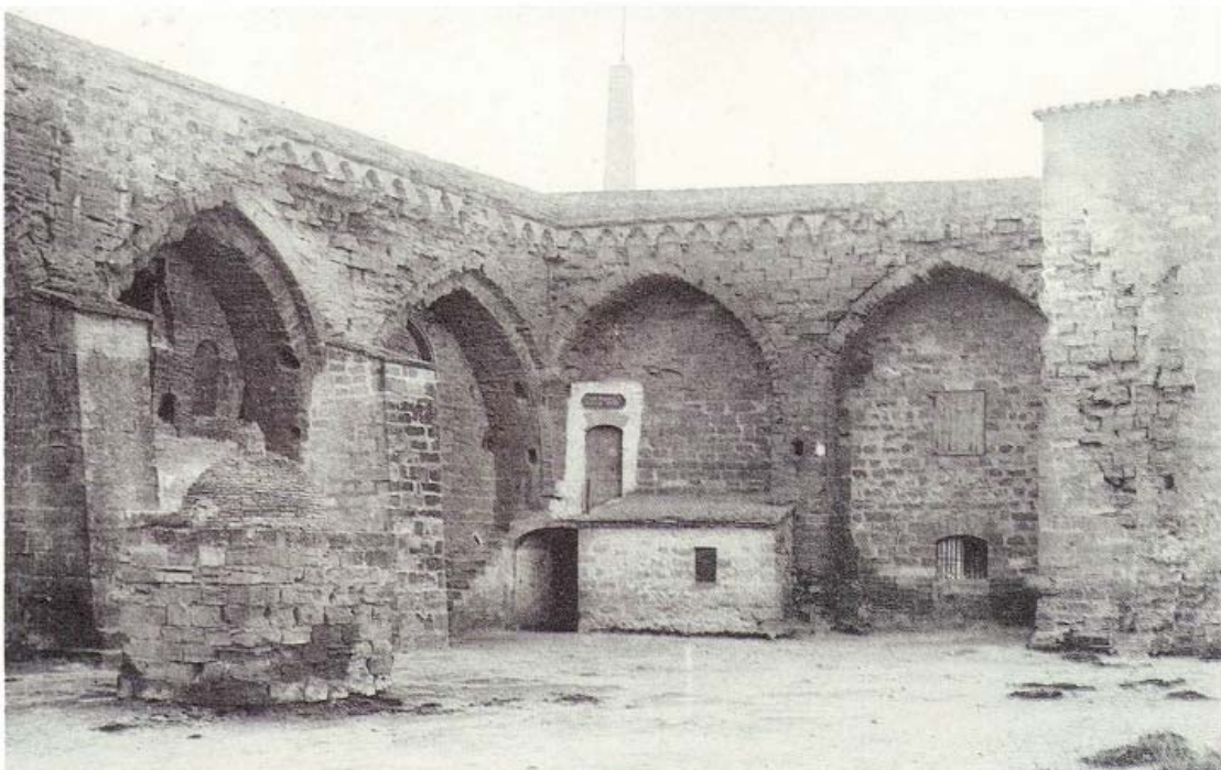
Fig. 45. Ales sud i oest vistes des del pati interior, Castell del Rei, Lleida, vers 1910.
