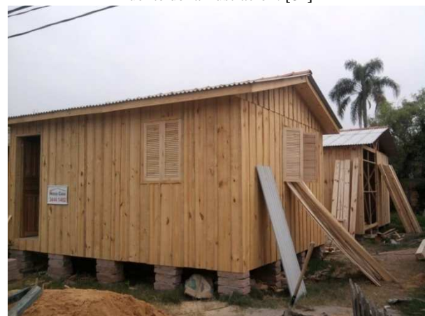
Imagen ilustrativa del sistema en construcción
