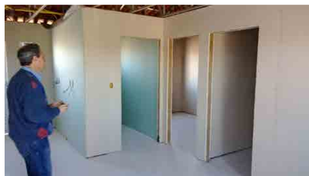
Montaje, vista interior
