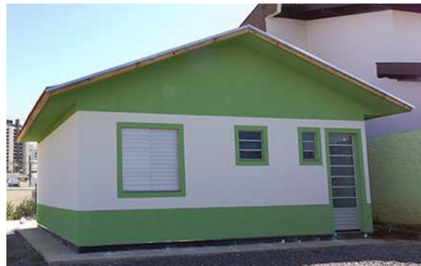
Imagen ilustrativa del exterior de la vivienda
