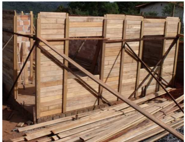
Montaje de la estructura y paredes
