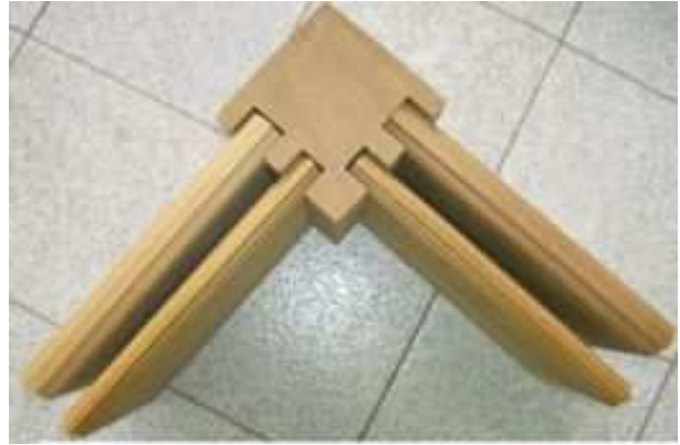
Pared doble (pilar + dos placas). Puede ser con o sin capa de aislamiento.
