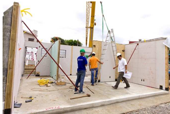
Imagen ilustrativa del sistema en construcción. Tabiques construidos en fábrica
