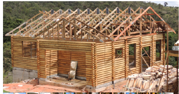
Imagen ilustrativa del sistema en construcción Fuente de la ilustración: [89]
