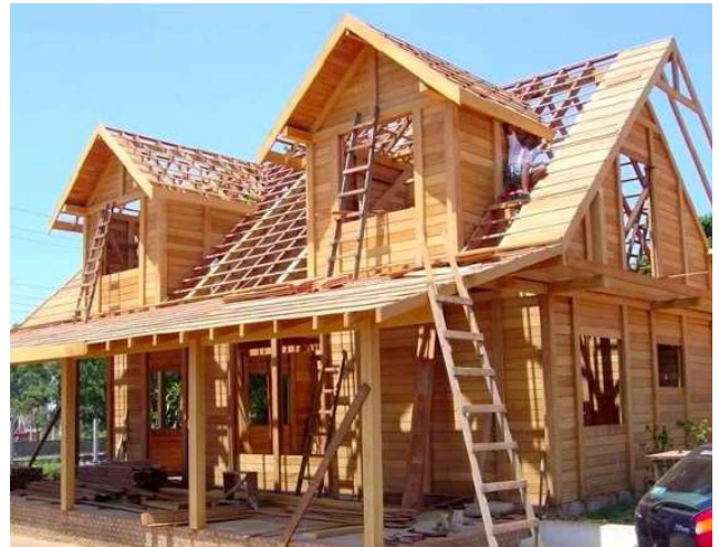
Montaje de la estructura y paredes
