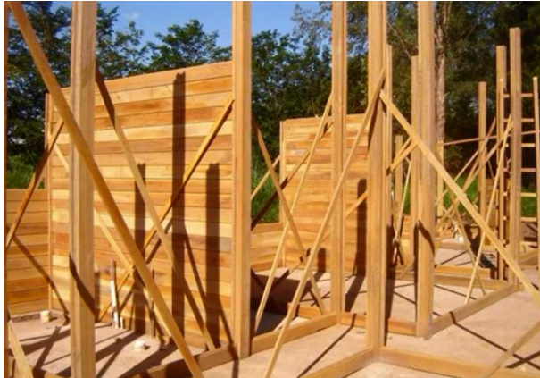
Imagen del sistema en construcción Fuente de la ilustración: [76]
