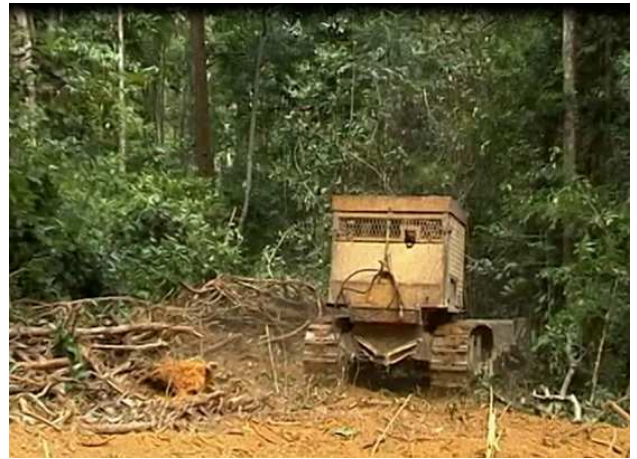
2 – Apertura de vías de acceso y patios de almacenamiento
