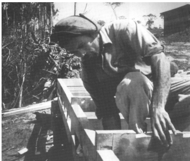
Fig. 2. 4 - Construcción manual de la vivienda de madera
