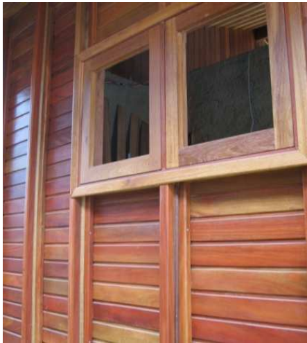
Pared acabada con apertura, acabada
