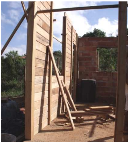
Montaje de la estructura y paredes
