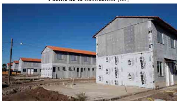
Montaje, vista exterior
