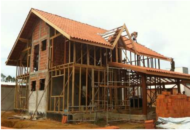
Montaje de la estructura de madera
