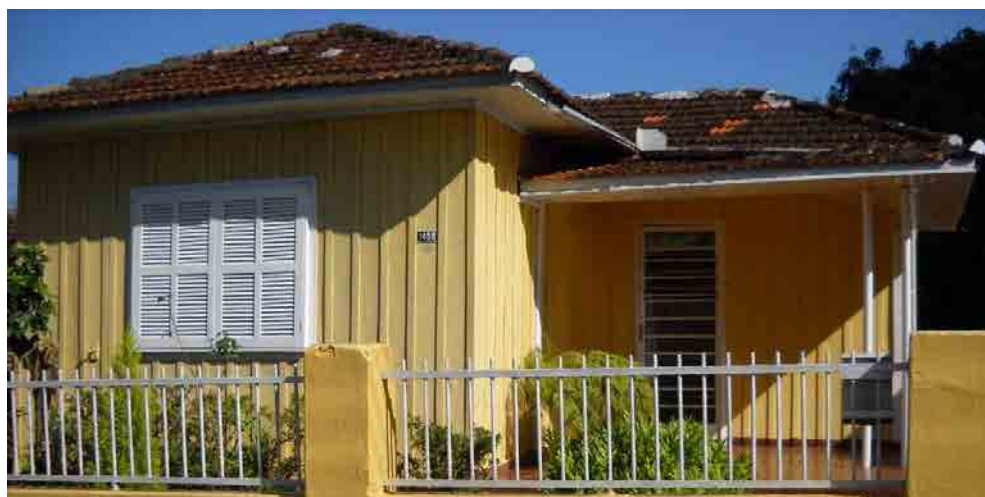
Fig. 2. 9 - Viviendas de madera construidas con la técnica conocida por "tapajuntas". Localizadas en Londrina/PR
