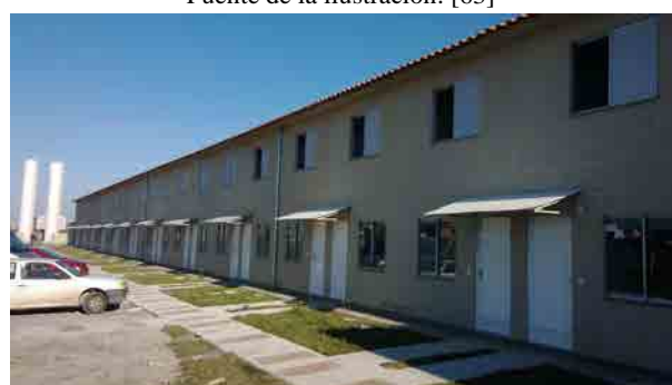
Acabado, vista exterior
