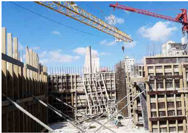
Encofrados de madera
