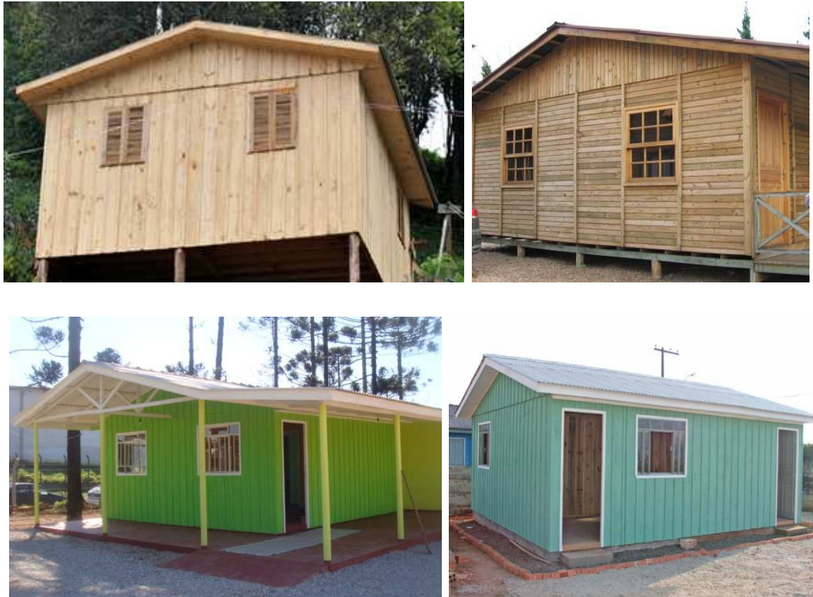
Fig. 2. 13 - Viviendas de madera de bajo coste vendidas en kits para la autoconstrucción
