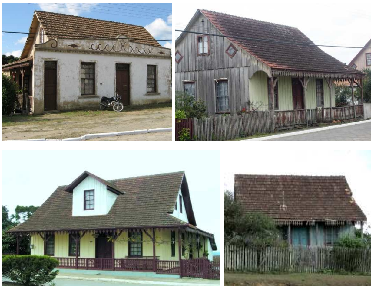
Fig. 2. 11 - Algunas edificaciones de madera del Núcleo Histórico del Alto Paraguaçu, en la ciudad de Itaiópolis/SC
