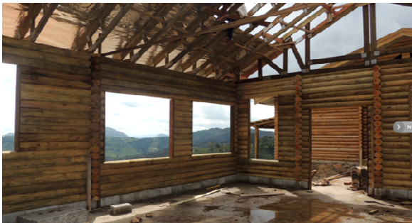
Imagen ilustrativa del sistema en construcción Fuente de la ilustración: [89]
