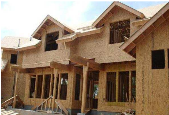
Imagen ilustrativa del sistema en construcción. Tabiques construidos in situ
