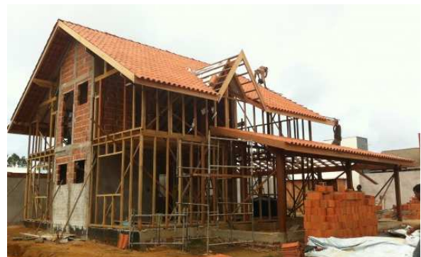
Imagen ilustrativa del sistema en construcción
