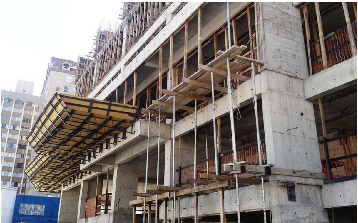
Madera utilizada en apuntalamientos y elementos de seguridad
