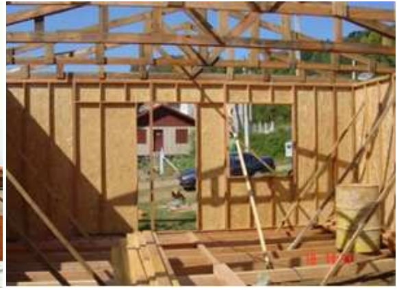
Montaje de la estructura y cierre de paneles de madera
