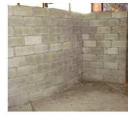
Bloque de hormigón
