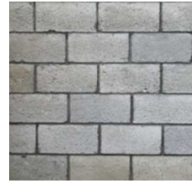
Bloque de hormigón
