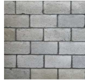
Bloque de hormigón
