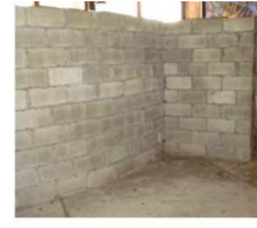
Bloque de hormigón
