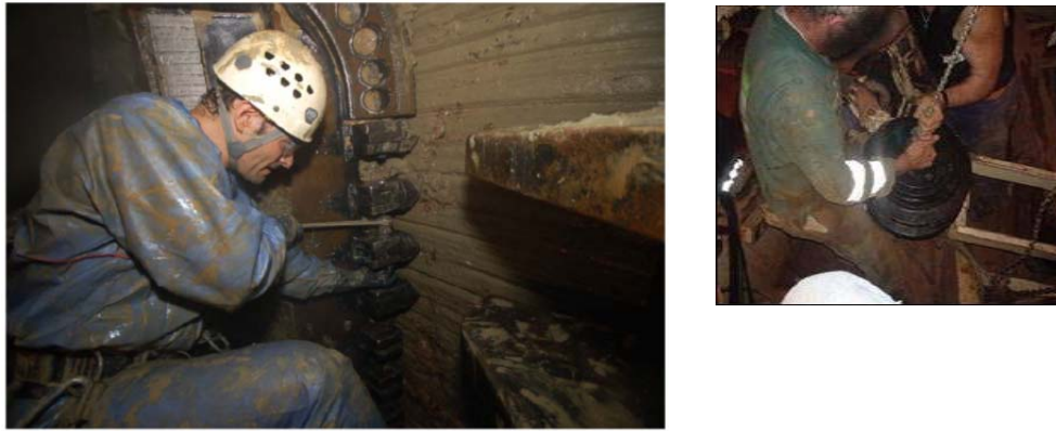
Figura 4.22: Trabajo de cambio de herramientas de corte. (Generalitat de Catalunya, 2009), (Gonzalo, 2008)
