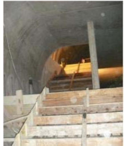
Figura 6.5: Escaleras de conexión entre ambos recintos del túnel. Foto de la autora.
