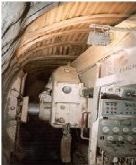
Figura 2.4. Vista de un codal, galería experimental de Tarifa. (Sáenz, 2007).
