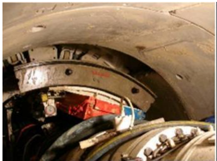
Figura 2.17: Colocación de dovelas. (Cardona, 2008).
