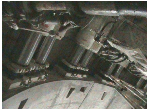
Figura 2.11. Cilindros de empuje. Túnel AVE Tramo Montcada i Reixac (Foto de la autora, 2010).
