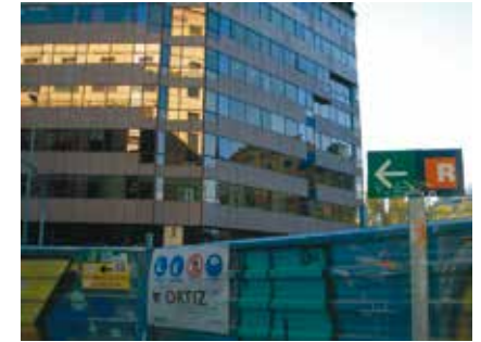
Fig. 92. Estructures i elements que modifiquen el trajecte 'habitual' degut a unes obres. Carrer Aragó amb Passeig de Gràcia, Barcelona. Desembre de 2012.
