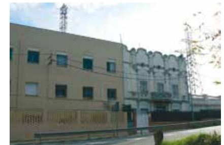
Fig. 122. Contrast d'estils arquitectònics. Carretera de Sant Cugat, Barcelona. Desembre de 2012.
