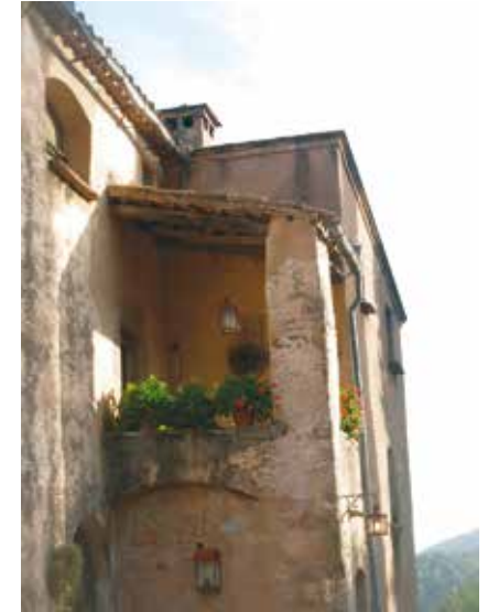
Fig. 76. Edificis que desprenen una pàtina del passat, al mateix temps que evocuen la mateixa terra (per la seva estructura i materials constructius). Sant Sebastià de Montmajor, en el municipi de Caldes de Montbui, al Vallès Oriental. Octubre de 2007.
