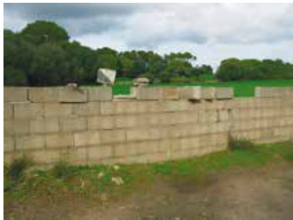
Fig. 102. Paret de blocs, Camí de Binixems, Menorca. Novembre de 2012.
