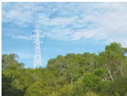
Fig. 95. Línea elèctrica travessant Collserola, Barcelona. Desembre de 2012.
