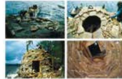
Fig. 420. Procés de construcció de Wave Chamber,
