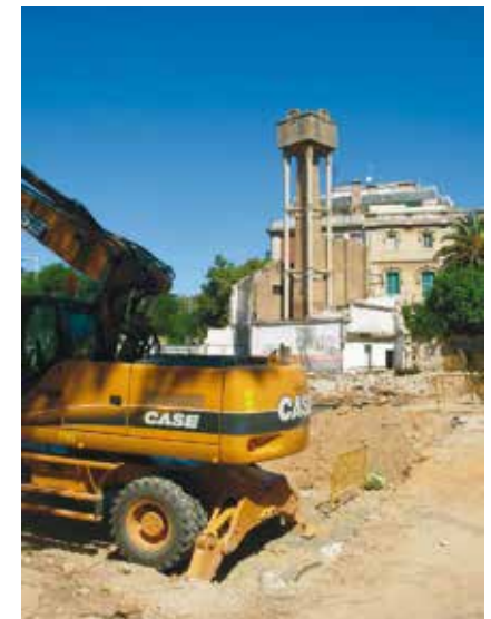
Fig. 48. Obres per Sarrià, Barcelona. Juny de 2007.
