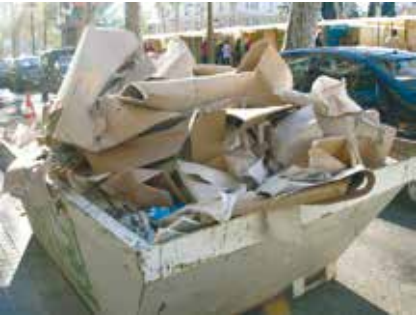
Fig. 244. Contenidor d'obres a la Rambla, Barcelona. Desembre de 2012.
