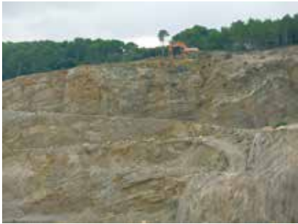
Fig. 238. Màquina a la pedrera de Santa Bàrbara, Alaior, Menorca. Novembre de 2012.
