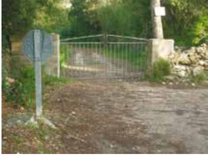
Fig. 101. Barrera de tub galvanitzat i cantonades de blocs, Camí de sa Roca, Menorca. Novembre de 2012.
