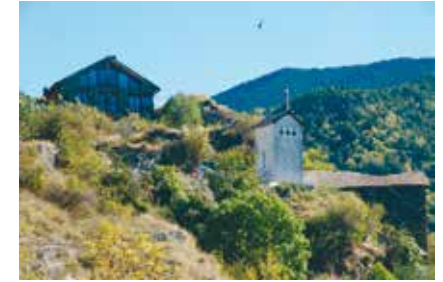
Fig. 34. Edifici de nova construcció i comptador elèctric, Farrera, Lleida. Octubre de 2013.
