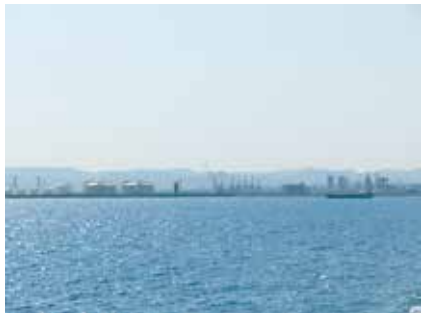
Fig. 19. Vista de la zona de càrrega del port de Barcelona. Juny de 2013.
