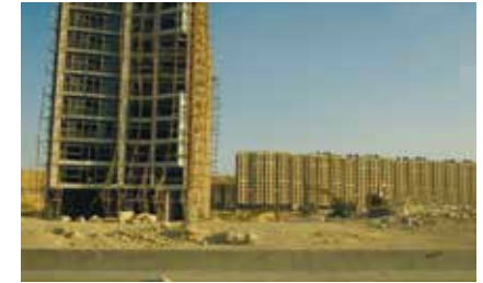
Fig. 121. Edificis en construcció, Egipte. Juny de 2008.
