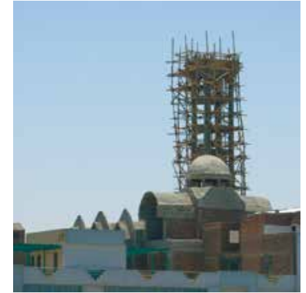
Fig. 86. Bastida a base de taulons i fustes entrelligades i 'precàries' per construir una torre o minaret. Esna, Població vora el Nil, Egipte. Juny de 2008.
