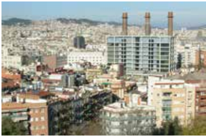
Fig. 125. Xemeneies de l'actual edifici Endesa, Barcelona des de Montjuïc. Desembre de 2012.
