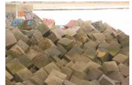
Fig. 39. Blocs de Formigó al port de Gijón, Astúries. Febrer de 2013.
