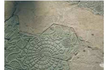
Fig. 54. Rajoles modernistes i ciment per substituir les que falten, Passeig de Gràcia, Barcelona. Desembre de 2012.
