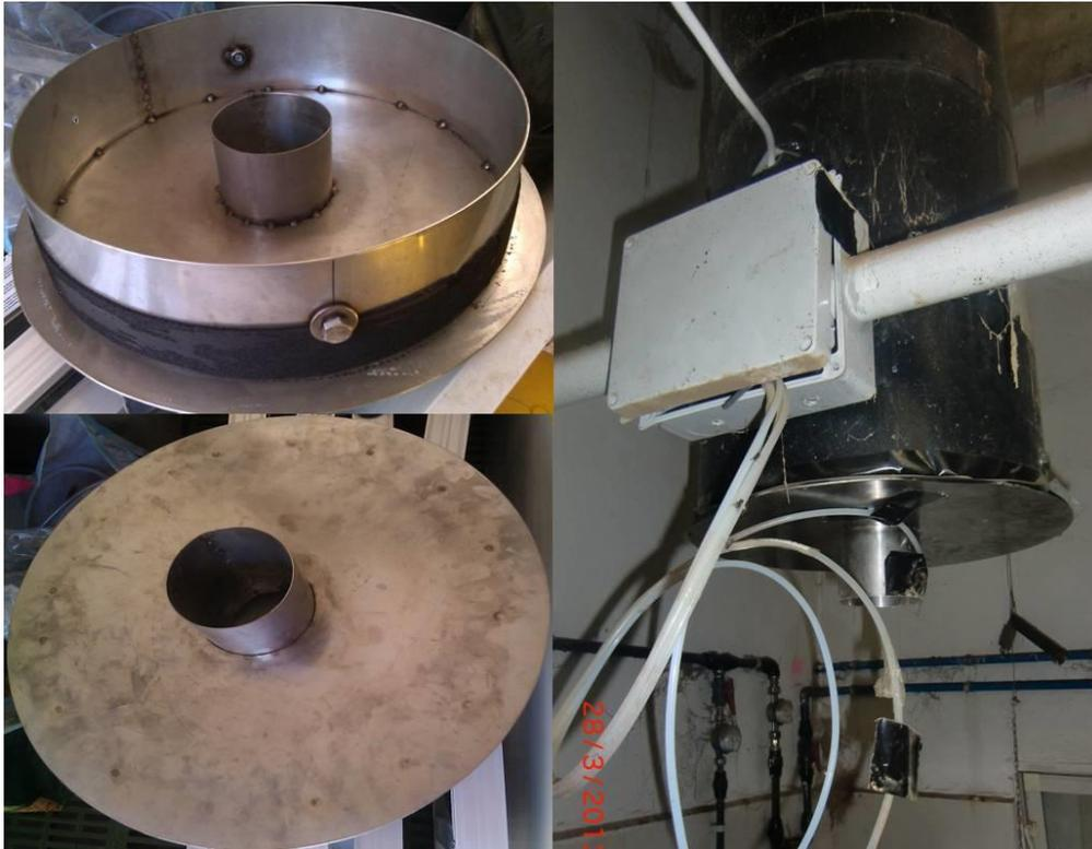
**Figura 4.4.** Sistema de renovación de aire utilizado en salas de transición.
