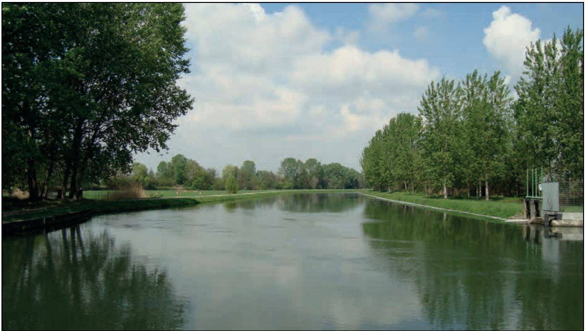
Imatge 5.9. Canal de la Muzza des de la central hidroelèctrica de Paullo (Milà)
