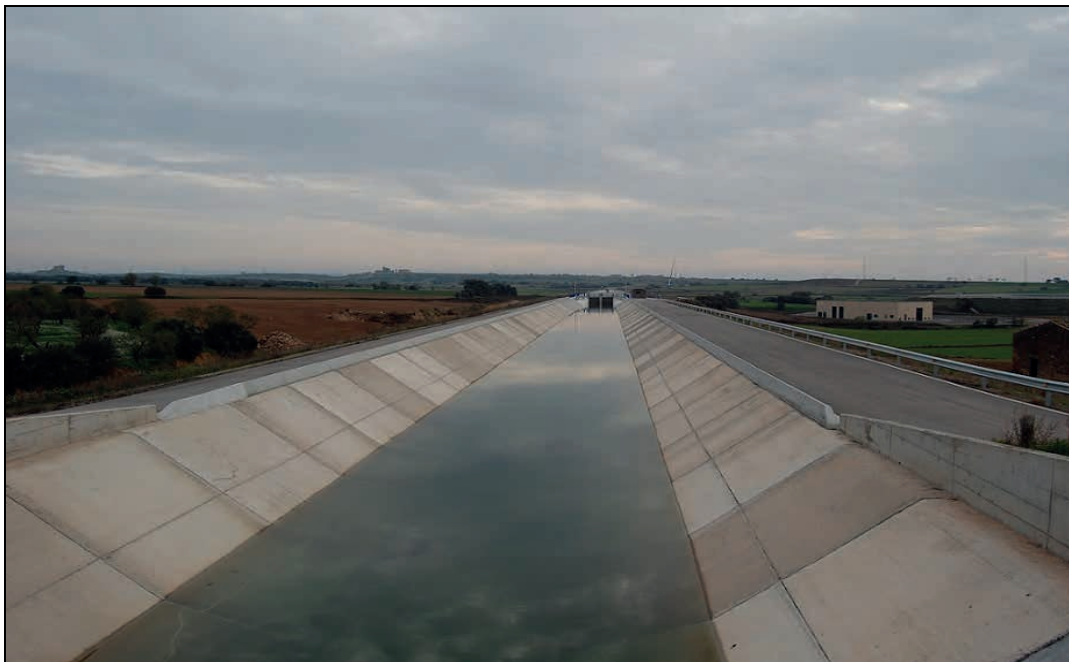
Imatge 5.4. Canal Segarra-Garrigues en funcionament (Les Garrigues)
