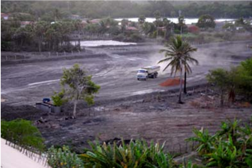
Construcción de una finca camaronera en Cumbe, Aracati. Foto: Jeovah Meireles.
