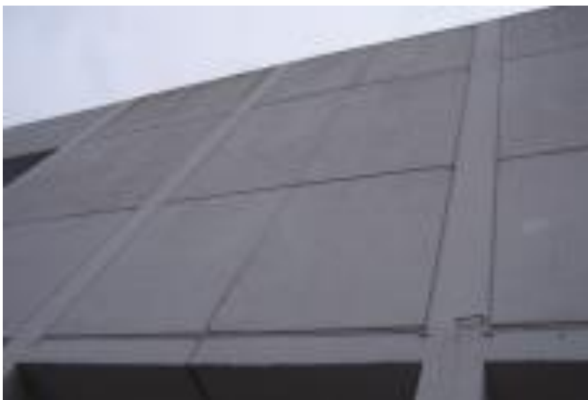
Img.B.4 Vista fachada con junta de dilatación (D)
