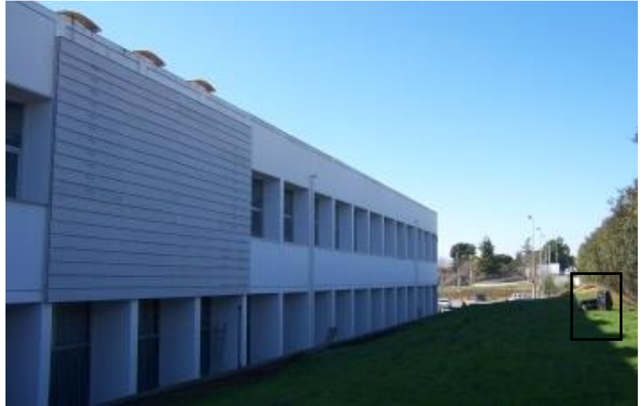
Img.B. 22 Vista general de la zona de ensayo. Localización del altavoz durante el ensayo de la (FVL) Fd (D)
