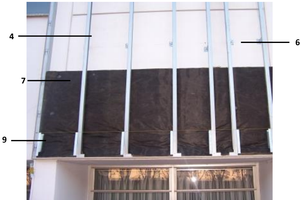
Img.B.13 Colocación de los perfiles auxiliares configuración (Fd). (D)
