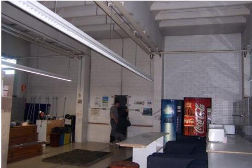
Img.B.18 Configuración general de la sala durante los ensayos. Colocación de banda para el aislamiento la junta de dilatación del edificio (D)
