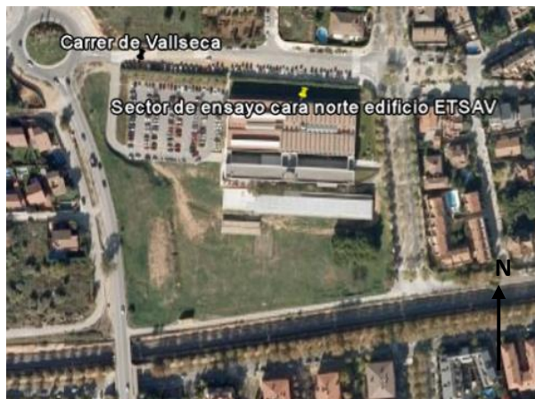
Img.B.1 Vista aérea Edificio ETSAV. Sant Cugat del Vallès (B.3)
