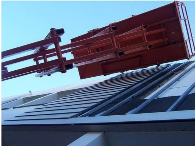
Img.B.34 Colocación de lamas de la configuración (Fd). Primer prototipo de (FVL) que se instaló (D)
