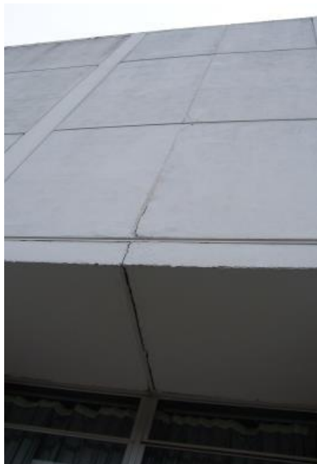
Img.B.21 Detalle del muro base en la sección de ensayo. Se observa la junta de dilatación (D)
