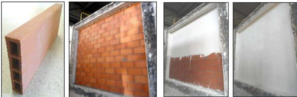
Img. 3. 1 Imágenes del bloque cerámico usado y construcción del muro simple. 4cm de espesor con acabado de yeso de 1cm por los 2 lados (F1)
