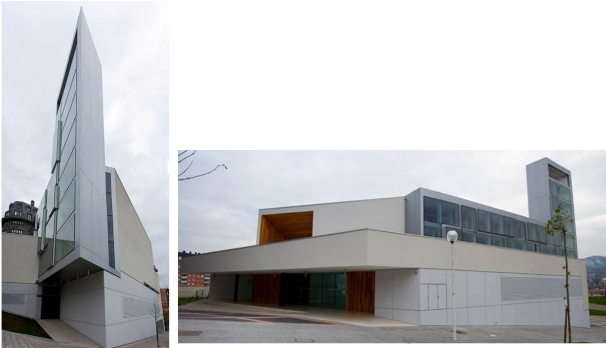
Img.2. 1 Iglesia Barrio Miribilla Bilbao España. IMB Arquitectos 2008-2009 utilización del sistema “Aquapanel” hoja exterior continua con placas de (CB) (C1)
