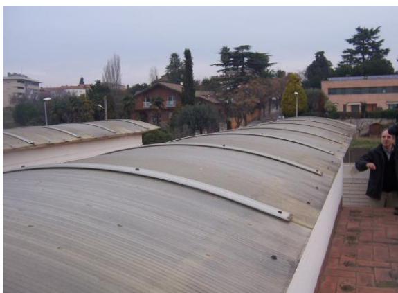
Img.B.10 Vista exterior de los lucernarios antes de los ensayos (D)
