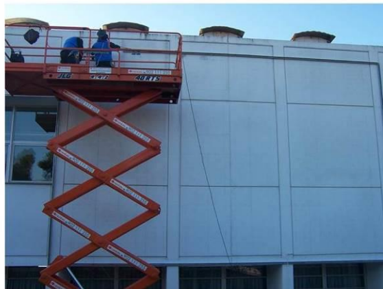
Img.B.30 Fijación de perfil perimetral de la subestructura para los prototipos. Sobre la fachada (FI) muro base (D)
