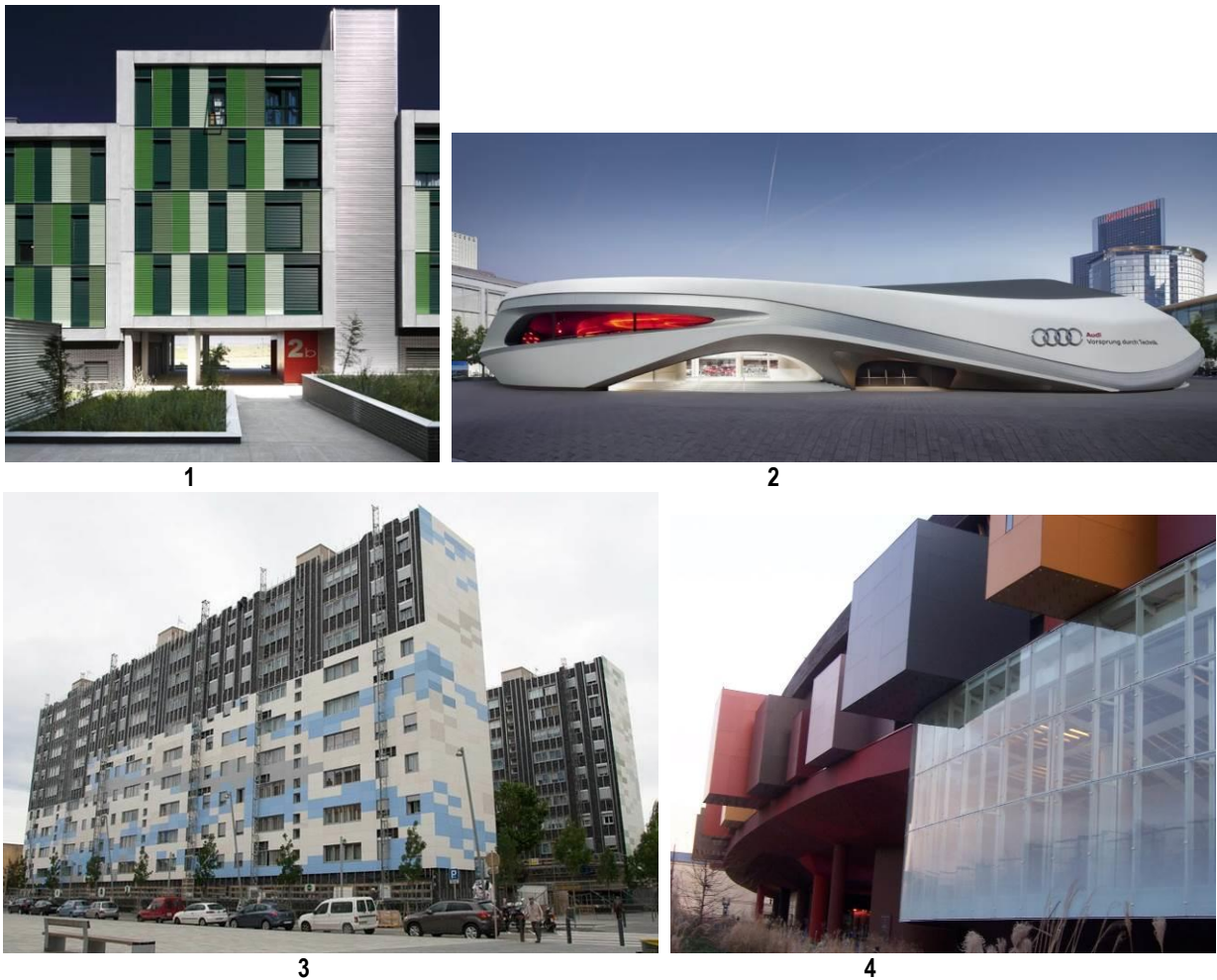
Img.2.8 (FVL) (CB) y sintéticos -1 Viviendas de protección pública en Parla (Madrid), Arquitectos : Arquitécnica. Utilización de paneles GRC, -2 Parque tecnológico Audi (Frankfurt), Arquitectos: Schmidhuber+Partner. Utilización de paneles Cement Board, - 3 Rehabilitación de viviendas (Cornellá de Llobregat), Empresa de Promoción social del ayuntamiento de Cornellá. Utilización de paneles de hormigón polímero. -4 Quai Branly Museum (París), Arquitecto: Jean Nouvel. Utilización de paneles fenólicos (C16, C17, C18 y D)
