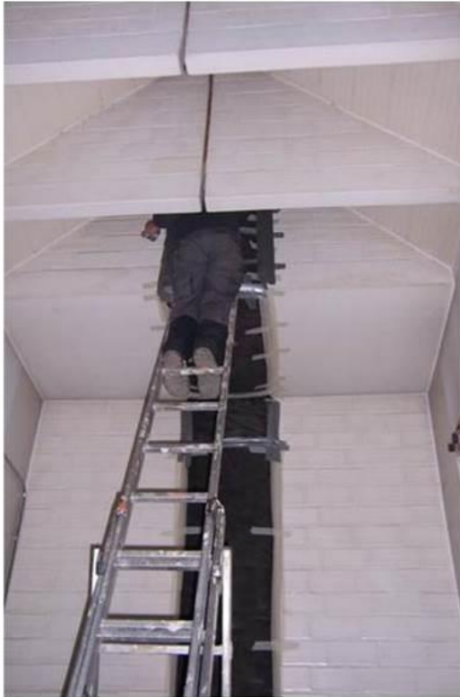
Img.B.36 Adecuación de aislamiento al interior de la sala. Colocación de lana de roca en la junta de dilatación (D)
