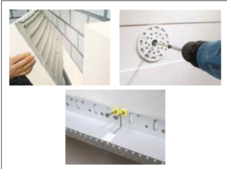
Img.2. 12 Fijación de paneles para ETICS (C25)
