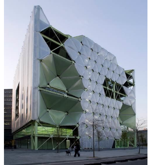
Img.A.3 Edificio Media-TIC Barcelona. Fachada realizada en ETFE permite el aprovechamiento del calor y ahorro energético en un 20%, Arquitecto Enric Ruiz-Gelic (C33)
