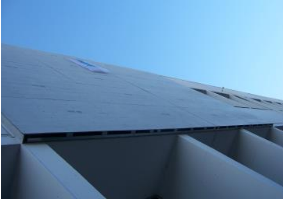
Img.B.27 Imagen de la superficie inferior de ventilación de la cámara totalmente abierta (100%). Ejemplo sistema (Fb-5) (como se indicó anteriormente (Fig. A.11), el grado de apertura de la cámara se realizó en 5 estados siendo “1” cámara totalmente cerrada (0%) y “5” cámara totalmente abierta (100%) (D)
