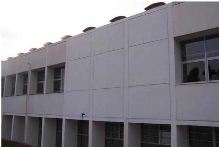
Img.B.44 Ensayo 4 -Febrero 17 de 2011- medida 1 de (FI) fachada sin sistemas instalados (D)
