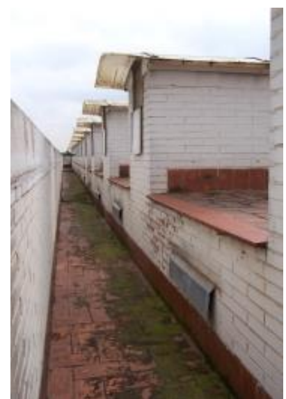
Img.B.3 Lucernarios de la cubierta Detalle de las aberturas de ventilación (D)
