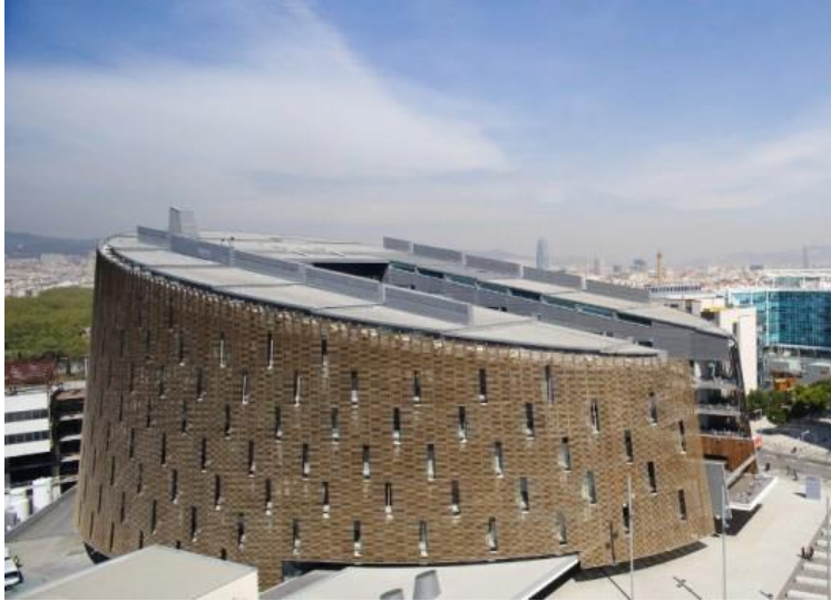
Img.A.2 Edificio Parque de investigación Biomédica de Barcelona (PRBB). Fachada de lamas de madera, Arquitectos Manel Brullet y Albert de Pineda (C32)
