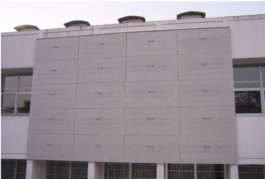
Img.B.16 (FVL) configuración (Fb). Imagen realizada durante el proceso de construcción de los prototipos para los ensayos (D)
