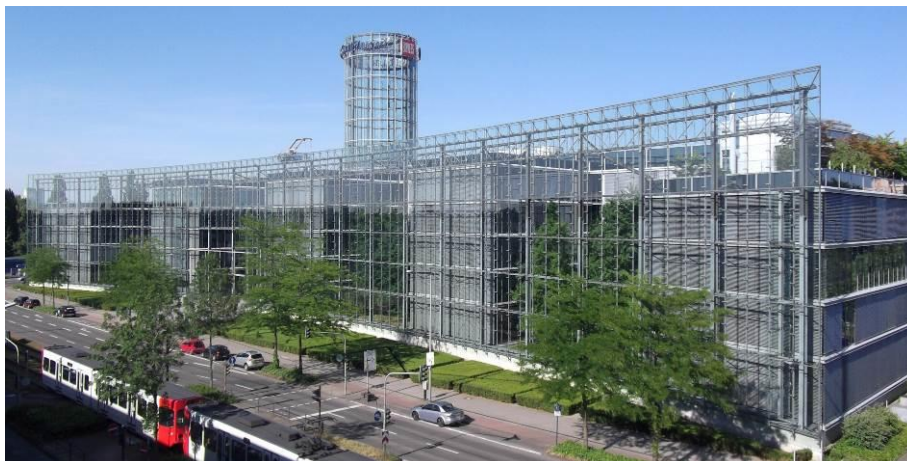
Img.A.4 Edificio Neven-DuMont-Schauberg publishing house. Vista pantalla acústica realizada frente del edificio en Colonia Alemania (C34)
