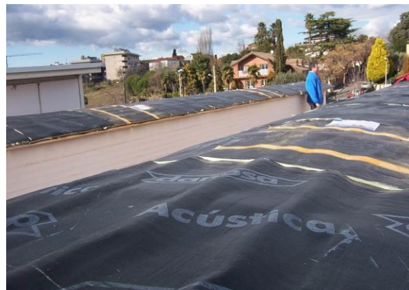
Img.B.9 Acondicionamiento de los lucernarios para los ensayos (D)
