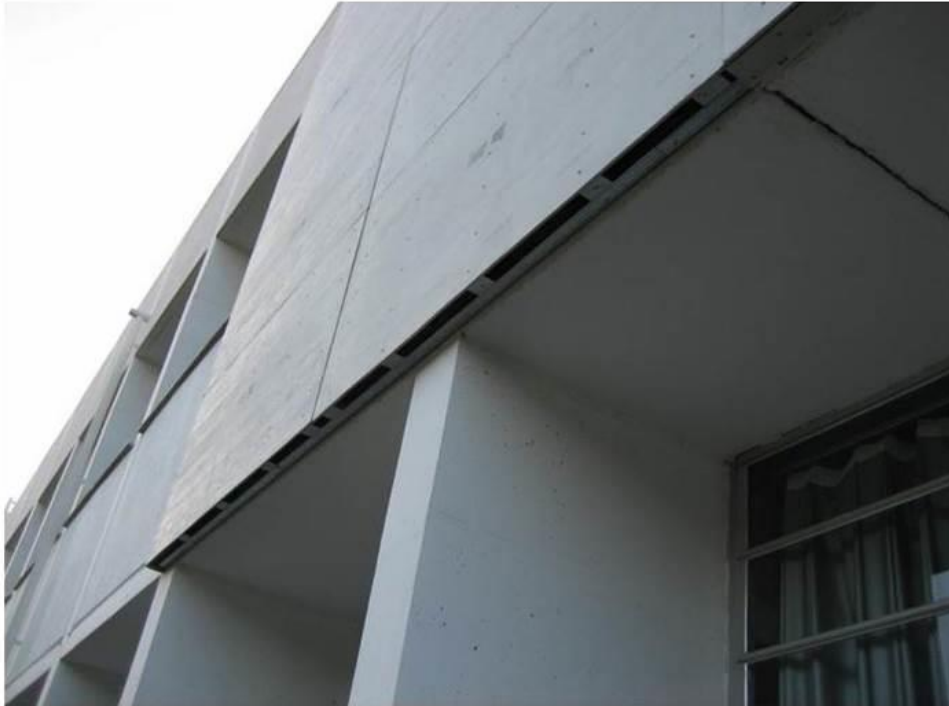
Img.B.43 Ensayo 2 -Febrero 09 de 2011- medida 3 de la configuración (Fb-3) (cámara 50% ventilada) vista inferior se observa la junta de dilatación que atraviesa la sala (D)
