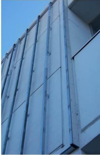
Img.B.32 y Img.B.33 Unión de montantes de 50 x 50mm para formar la cámara de 10cm (D)
