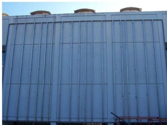
Img.B.31 Colocación de montantes de la subestructura. Perfiles de 50 x 50mm cada 60cm, en algunos puntos la distancia es menor (47cm) cerca de los pilares para no afectar demasiado a la estructura del edificio (D)
