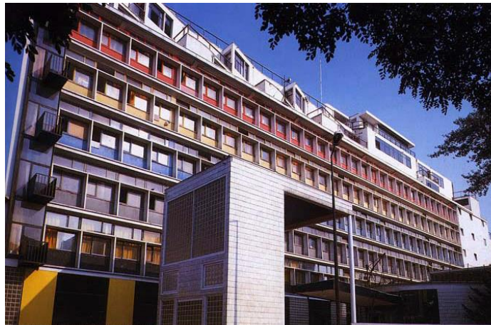
Img.A.6 Le cité de Refugie. Imagen actual de la fachada construida. Arquitecto Le Corbusier Francia 1930 (C35).
