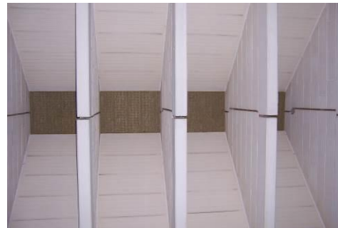
Img.B.8 Colocación de paneles rígidos en los lucernarios. Paneles rígidos de lana de roca instalados a presión para el acondicionamiento de la sala (D)
