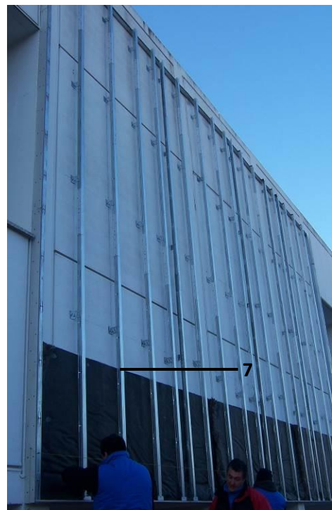
Img.B.11 Colocación del aislamiento de la cámara de la (FVL) (D)
