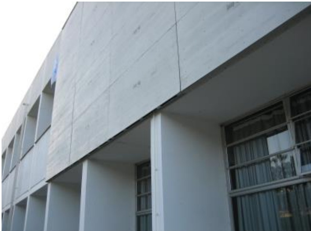
Img.B.28 Imagen de la superficie inferior de ventilación de la cámara parcialmente abierta (75%) de la (FVL) (Fb-4) (D)
