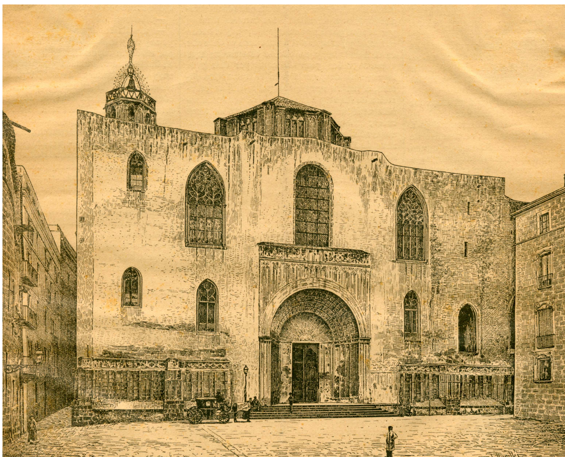
Fotografia núm. 39 Catedral de Sta. Maria. Barcelona Autor: Lluís Urgellis Data: 1891 (document anterior de 1888) Arxiu fotogràfic: SPAL (Diputació de Barcelona)
