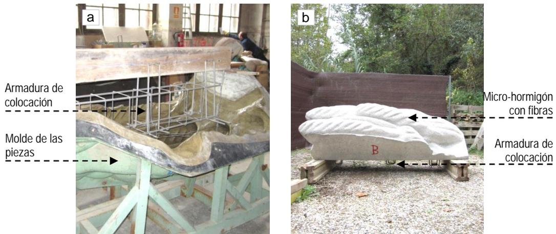
Figura 5.25: Molde y armadura de colocación de las futuras piezas prefabricadas de los pináculos antes del vertido del micro-hormigón y b) Pieza prefabricada de micro-hormigón con fibras una vez desmoldada
