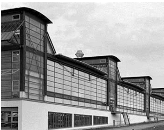
Fotografía 35. Central de producción de energía, Eimbeckh Thomas Herzog.
