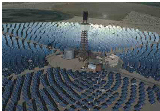
Fotografía 82 Estación Solar Abengoa España
