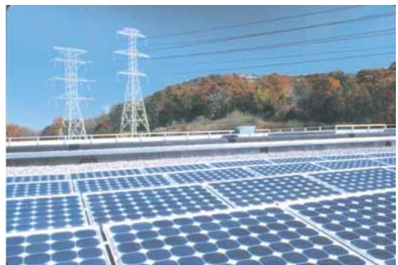
Fotografía 18, Paneles Fotovoltaicos Fuente: Imágenes Google
