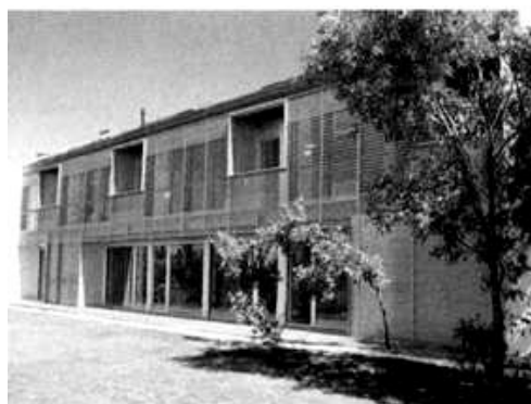
Fotografía 64 Fachada vivienda Madrid, Fujy arq. Fuente: Fujy arquitecto.
