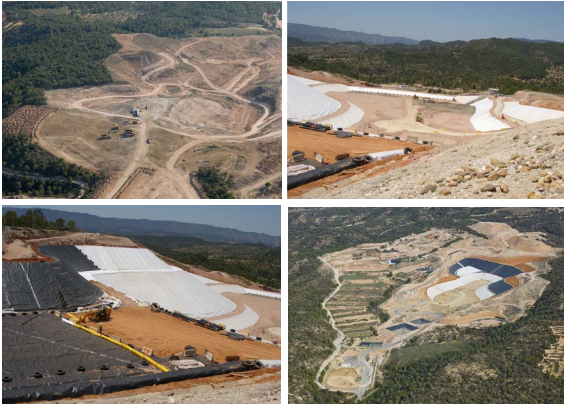
Fig. 16 Vistes aèries i detall de construcció de l'abocador del Racó de la Pubilla A dalt Getinsa (2013). Recuperat des de http://www.dectonaminationflix.com [27.06.2013]. A sota M. Pujadas (juny de 2013)
