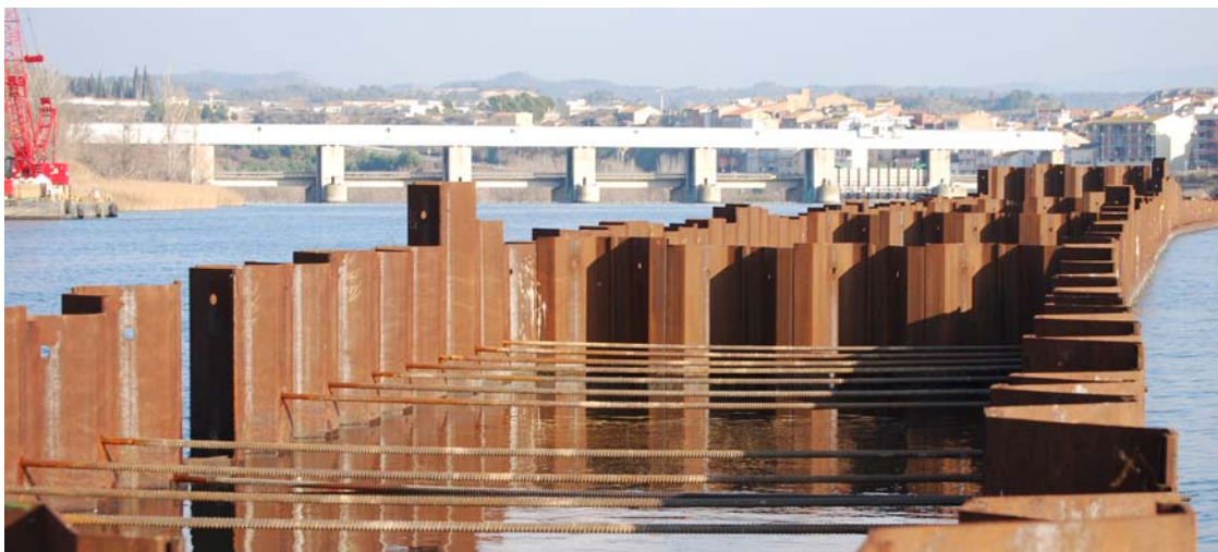
Fig. 14 Recinte de pal-planxes per a l'extracció dels fangs contaminats A dalt a la dreta i última Getinsa (2013). Recuperat des de http://www.decontaminationflix.com [27.06.2013]; resta M. Pujadas (maig 2011)
