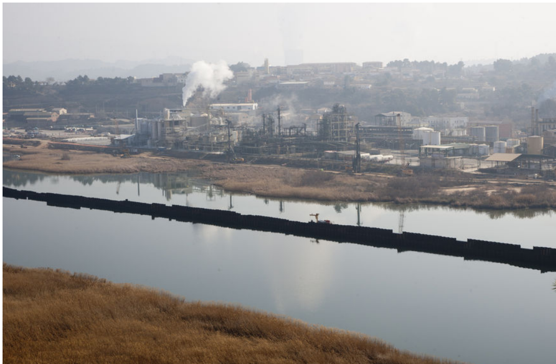
Fig. 1 Vistes a la fàbrica i mur de palplanxes Getinsa (2013). Recuperat des de http://www.dectonaminationflix.com [27.06.2013]
