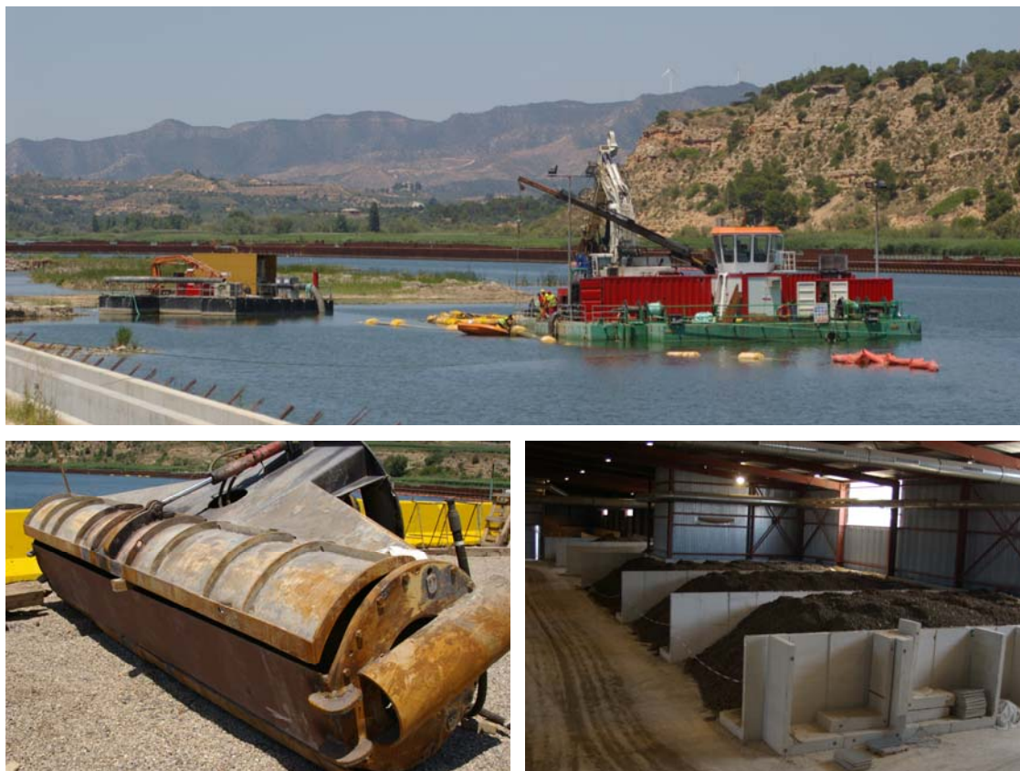
Fig. 15 Treballs d'extracció dels fangs
