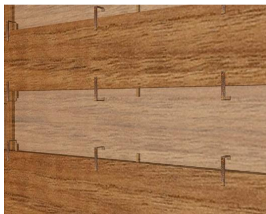
Figura 4.344. Detall de les espigues de fusta que uneixen les posts del plafó central i de les grapes metàl·liques que en reforcen la unió. Visió P1, P3 amb el 50% de transparència. (© BAUTISTA, I.)
