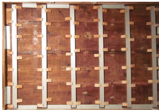
Figura 3.61. Taula de sant Bernat de Palma _4111_ Travessers metàl·lics no originals. (© BAUTISTA, I.)
