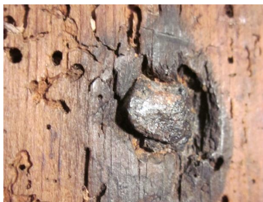
Figura 2.19. Taula de sant Miquel de Soriguerola_3901 _Travesser unit al plafó central amb claus de forja reblats, clavats des del revers cap a l'anvers. (© BAUTISTA, I.)
