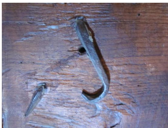
Figura 2.73. Taula de sant Pere_2848_Claus de forja per unir el muntant del marc i el barrot travesser al plafó central. (© BAUTISTA, I.)
