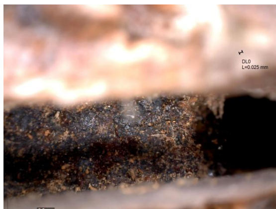
Figura 3.44. Taula de sant Pere_2848_corrosió de les espigues metàl·liques. (© BAUTISTA, I.)
