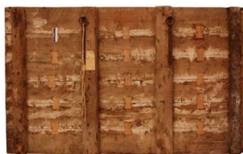
Figura 3.78. Taula de la Verge de l'església de Marinyans_ PM 66000 855_ Reintegració estructural de la cantonada dreta. (© BAUTISTA, I.)
