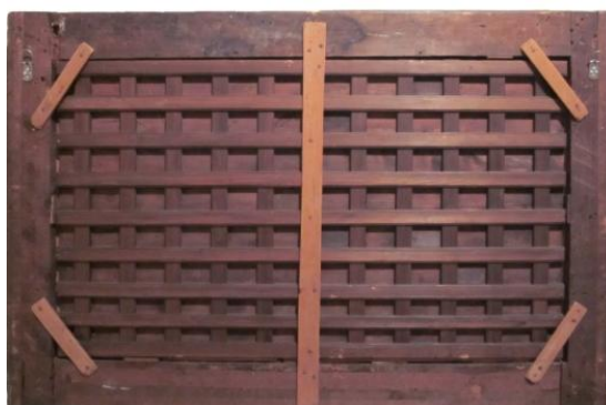
Figura 3.63. Taula de sant Cristòfol de Toses _4370_ Engraellat de llistons mòbils i angles de fusta no originals a les quatre cantonades. (© BAUTISTA, I.)
