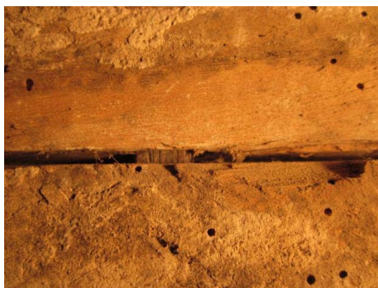
Figura 2.11. Taula de sant Jaume de Frontanyà_13_Unió de les posts del plafó central amb espigues de fusta. (© BAUTISTA, I.)
