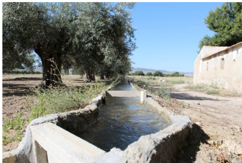
Imagen: Viejas canalizaciones de riego aún en uso en muchas zonas de Murcia.
