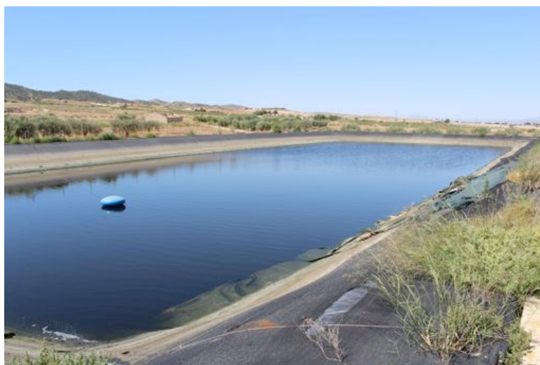
Imagen: Embalse de riego plastificado, de propiedad privada, utilizado para asegurar el agua para el riego por goteo mecanizado.
