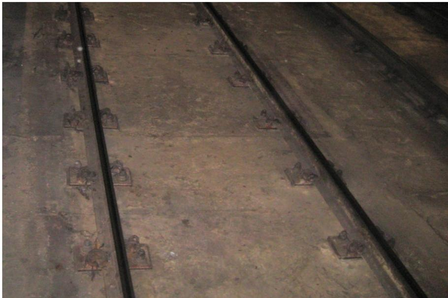
**Figura 3.3.** Vía sobre placa con fijaciones DFF. Línea 3 del Ferrocarril Metropolitano de Barcelona.
