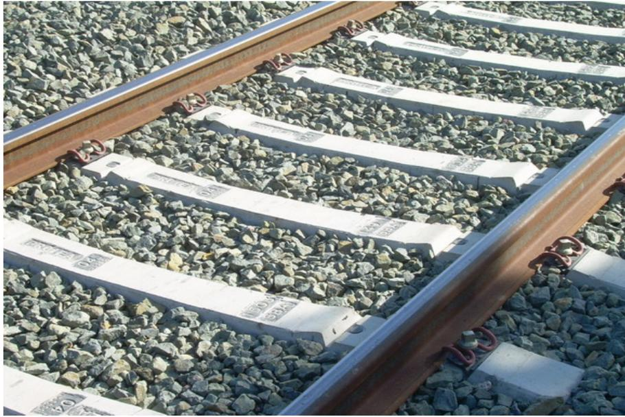
**Figura 3.2.** Vía convencional, con balasto y traviesas de hormigón monobloque.
