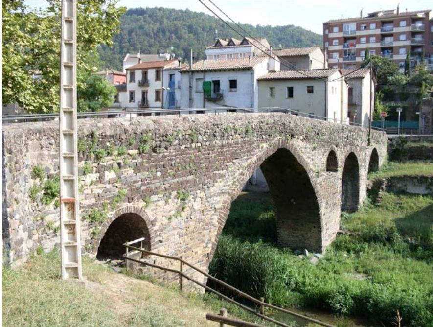
Imagen 12.1 Vista general del puente
