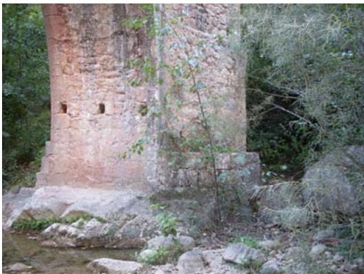
Imagen 14.7 A la izquierda: pila central, tajamar y espolón vistos desde aguas arriba, a mitad de la luz del arco segundo
