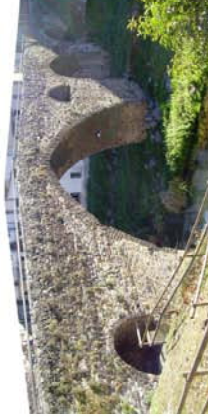
3. Paramento desde orilla izquierda aguas arriba
