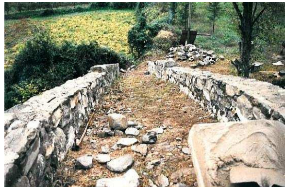
Imagen 13.25 y 26 Reconstrucción de los pretiles
