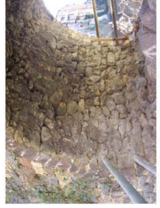
6. Detalle de la bóveda del arquillo de aligeramiento
