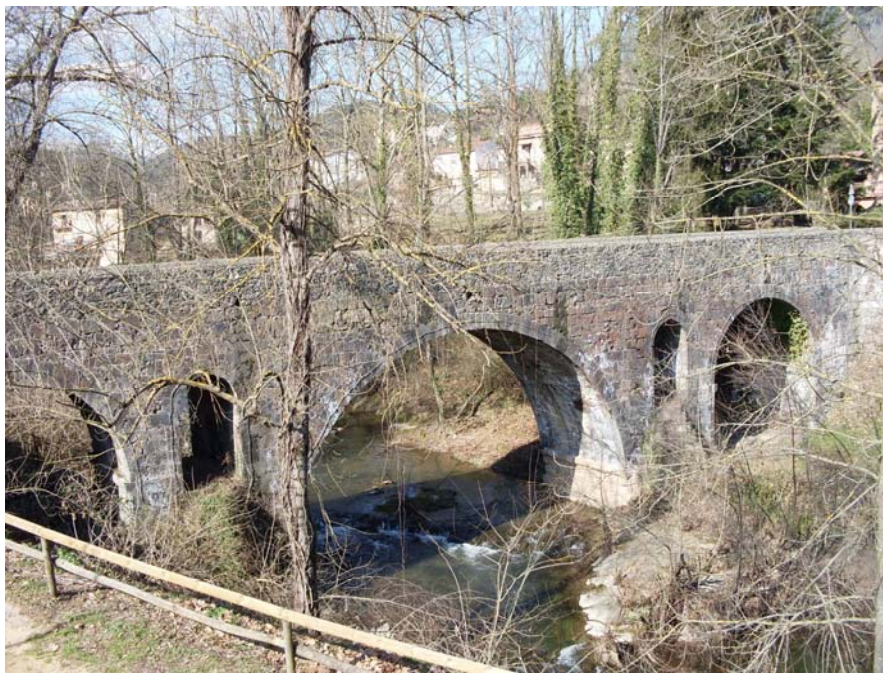
Imagen 11.1 Vista del puente desde aguas abajo
