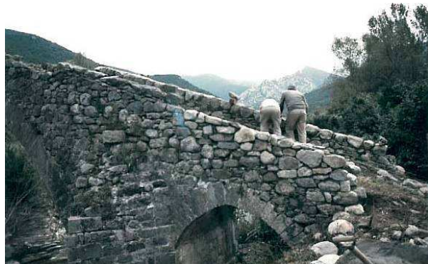
Imagen 13.21 A la izquierda: reconstrucción de pretilos y tímpanos.
