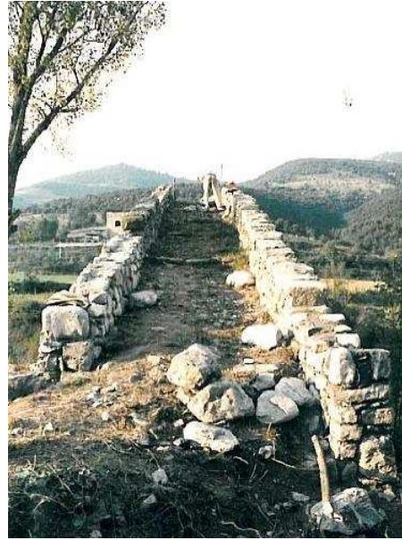
Imagen 13.23 A la izquierda: los tímpanos reconstruidos y en cursote la reconstrucción de los pretiles
