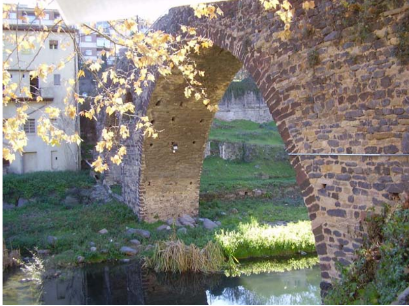
Imagen 12.9 Detalle de la bóveda, enlucida con una capa de mortero.
