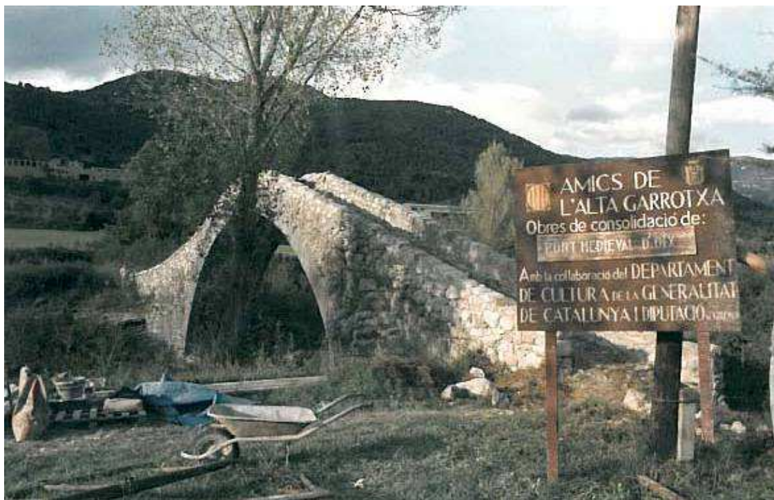
Imagen 13.29 El puente después de los trabajos de reconstrucción 1988.
