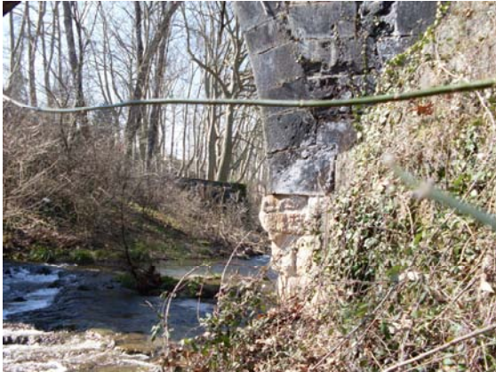
Imagen 11.5 A la izquierda: arranque del arco principal sobre sillares de arenisca
