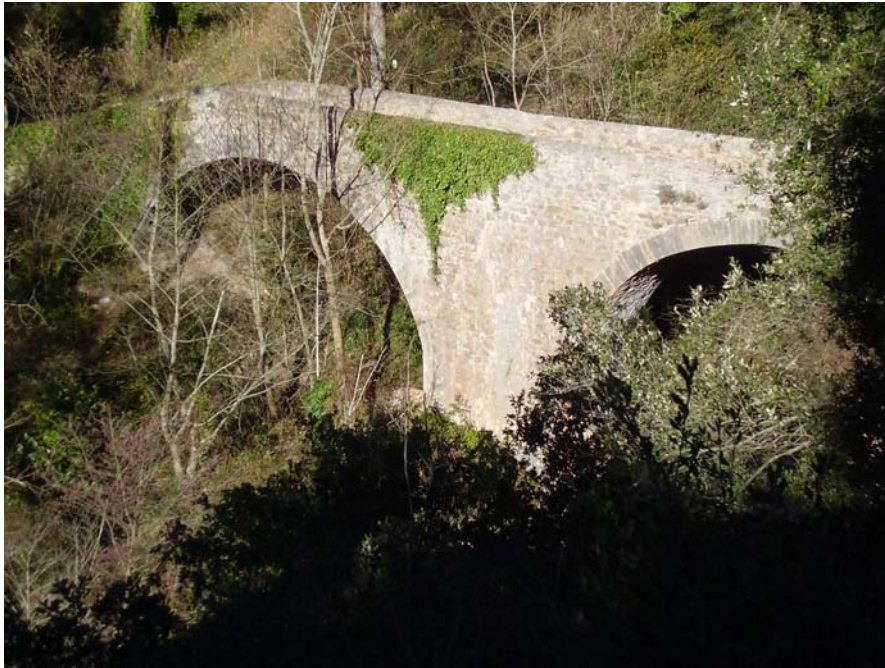
Imagen 14.1 Vista general del puente
