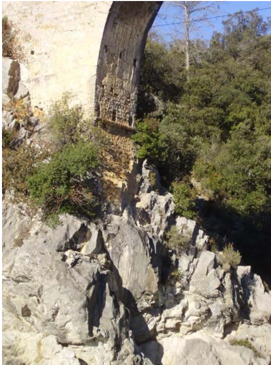
Imagen 15.6 Vista del arranque, desde la pila derecha y aguas abajo.
