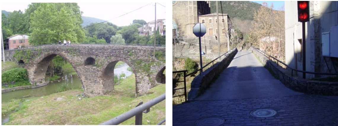
Imagen 12.5 A la izquierda: el puente visto desde el margen derecho y aguas arriba. Obsérvese que los arquillos no están contenidos en el mismo plano horizontal
