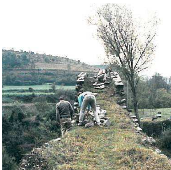
Imagen 13.20 Trabajos de Reconstrucción de los tímpanos y pretilos
