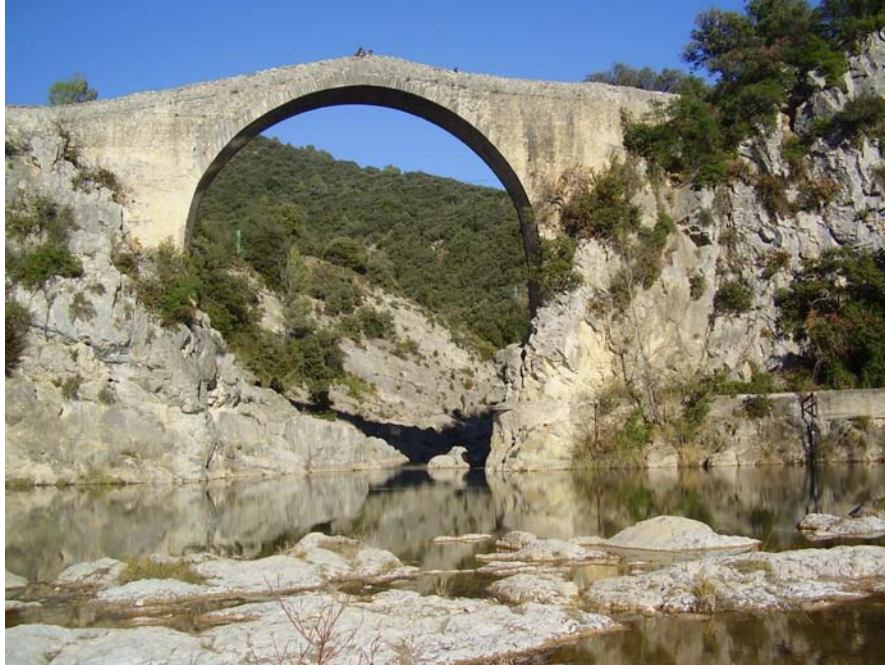
Imagen 15.1 Vista general del puente.
