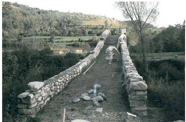
Imagen 13.27 y 28. Finalizando los trabajos de reconstrucción de los pretiles y compactación de la calzada
