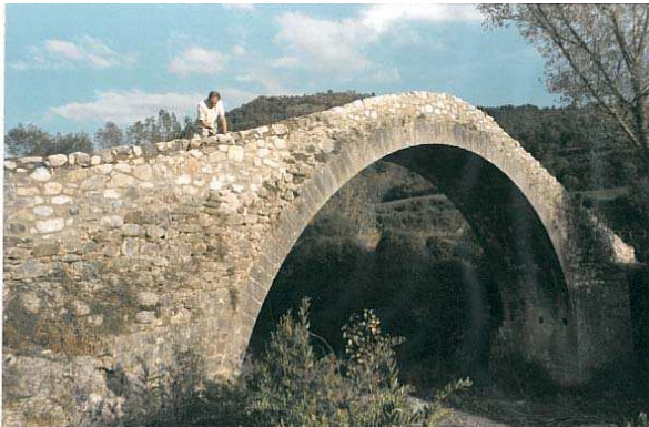
Imagen 13.25 y 26 Reconstrucción de los pretiles
