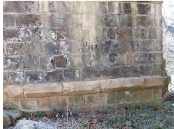
Imagen 11.5 A la izquierda: arranque del arco principal sobre sillares de arenisca
