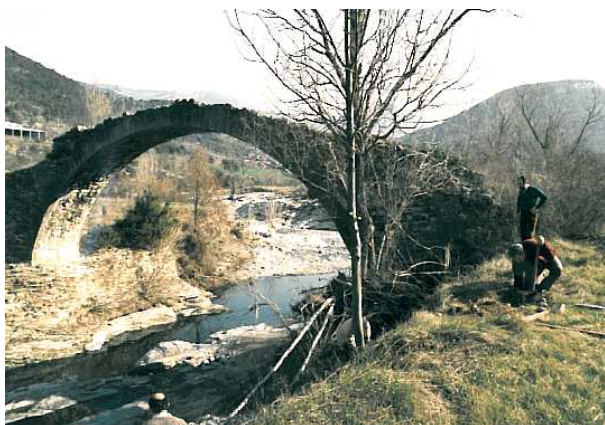
Imagen 13.19 Silueta del puente después del desbrozado
