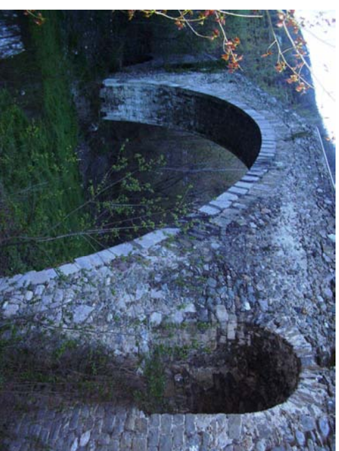
6. Paramento y arco de aligeramiento desde orilla derecha
