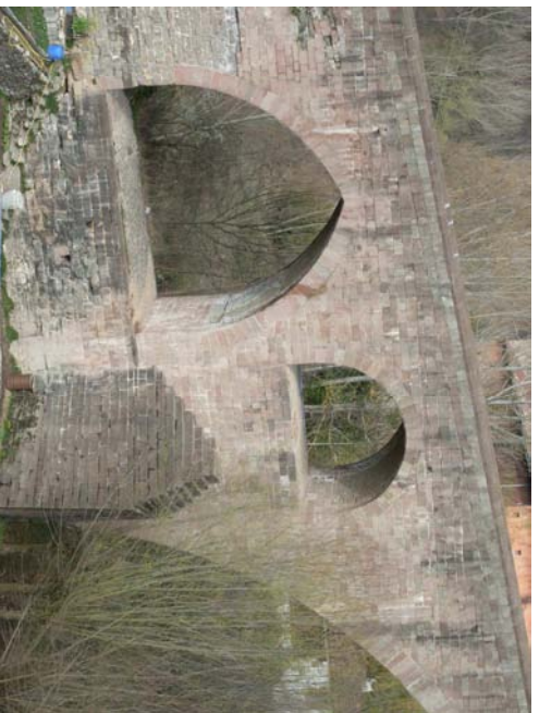
1. Arquillos y tajamar orilla derecha aguas abajo
