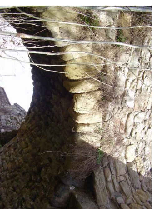
6. Bóveda del arco extremo orilla derecha, aguas arriba
