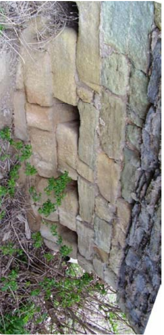
4. Arranque del segundo arco
