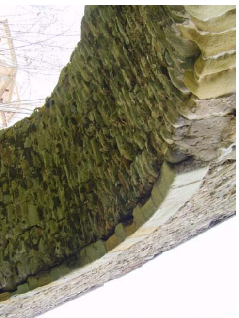
5. Bóveda con boquilla aplacada, vista desde aguas abajo
