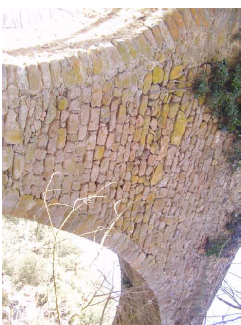
5. Paramento entre los arcos desde la orilla derecha
