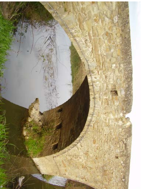
4. Arco, pila y paramento desde la orilla derecha aguas abajo
