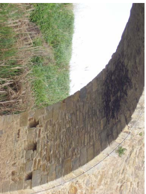
5. Bóveda de uno de los arcos
