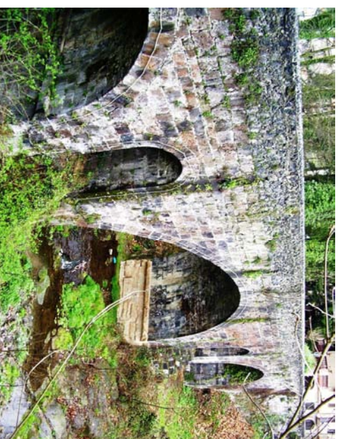
2. Vista general desde aguas abajo orilla derecha
