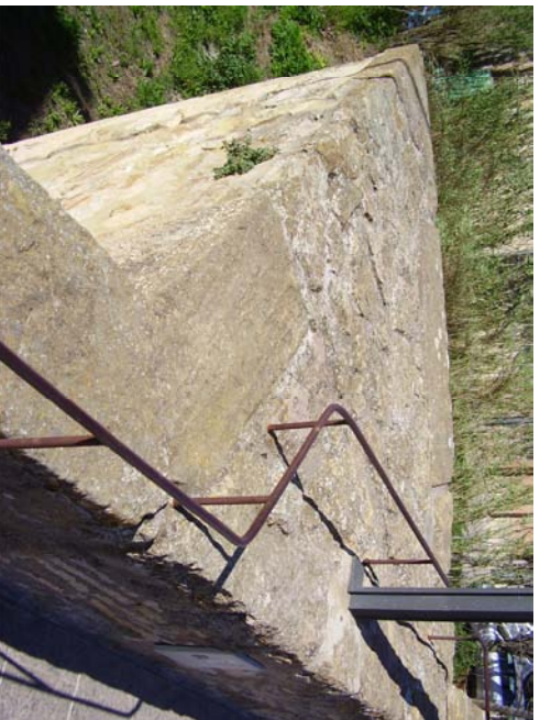
4. Balconillo del tajamar relleno de mampostería
