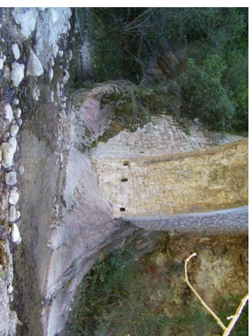
6. Arranque y bóveda desde la orilla izquierda
