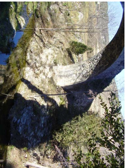
1. Arranque del arco desde la orilla izquierda
