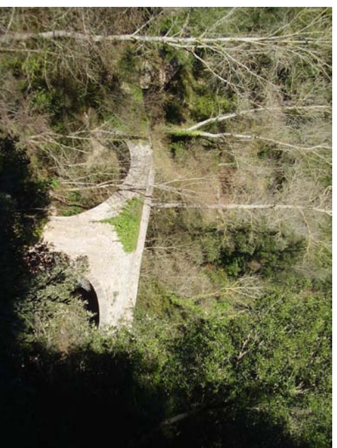
2. Arcos y paramento desde aguas abajo
