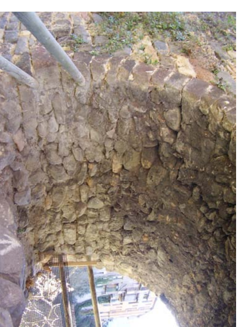
6. Detalle de la bóveda del arquillo de aligeramiento
