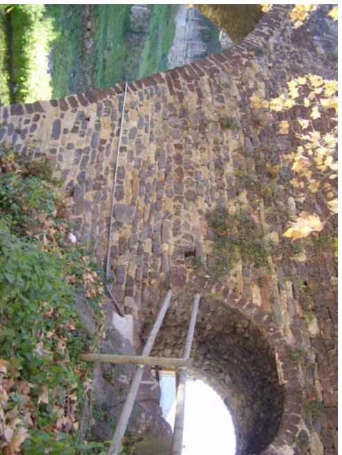
4. Pila y arquillo de aligeramiento desde orilla izquierda aguas abajo
