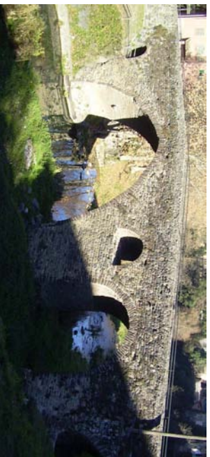
1. Paramento desde orilla derecha aguas arriba
