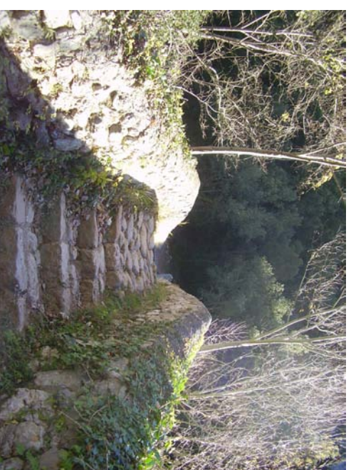
3. Escalera de acceso a la calzada desde la orilla derecha
