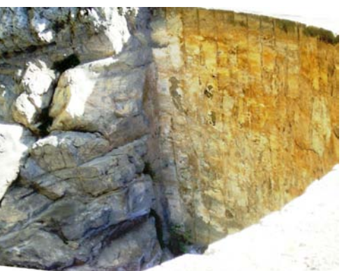
5. Asiento de la bóveda sobre el estrato rocoso
