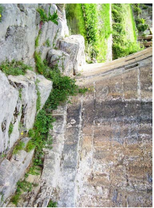
6. Estrato rocoso sobre el que se apoyan las pilas
