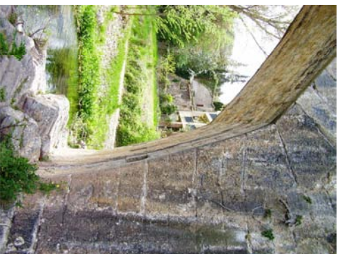
4. Arranque del arco central desde estrato rocoso, orilla izquierda
